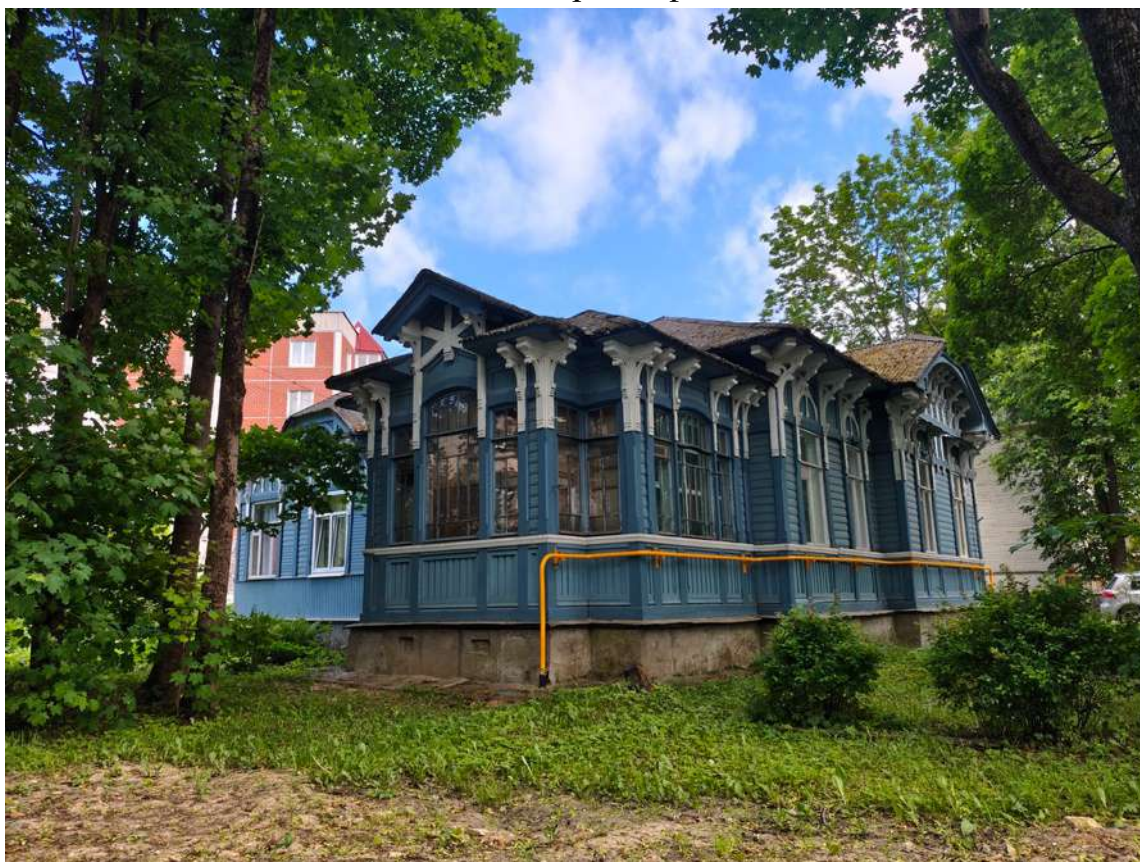
12. Вид с северо-запада
