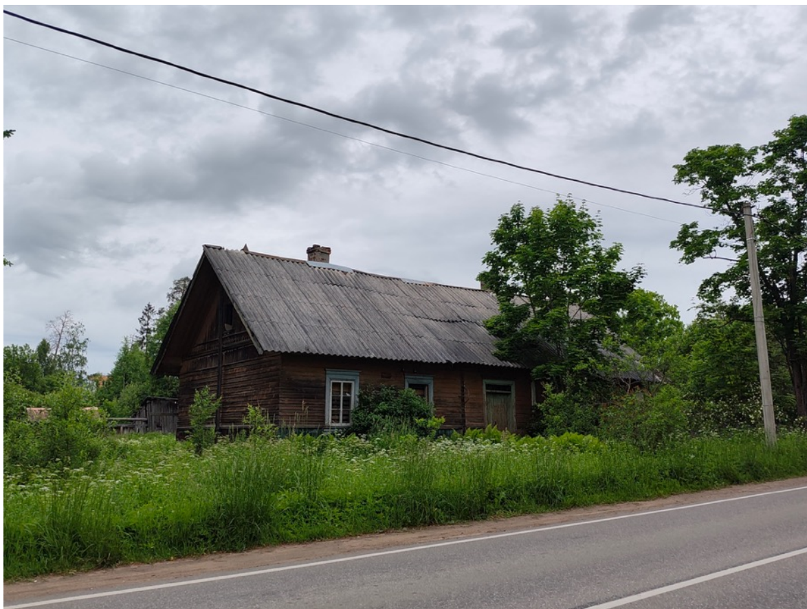
3. Вид с юго-запада
