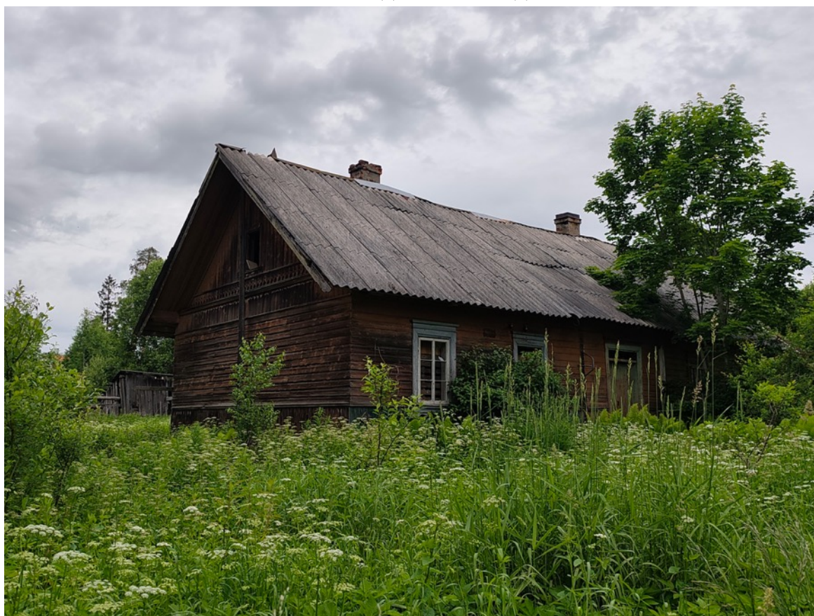
4. Вид с юго-запада
