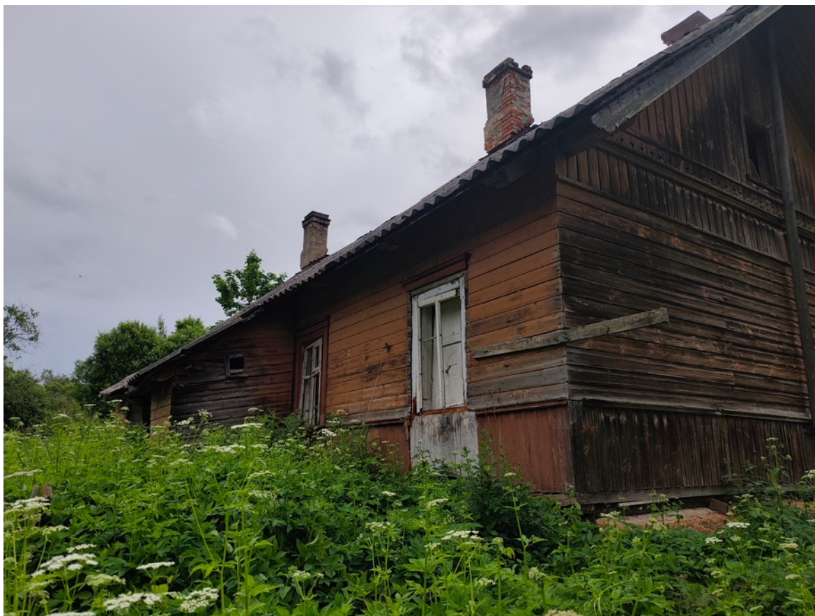
11. Вид с северо-запада
