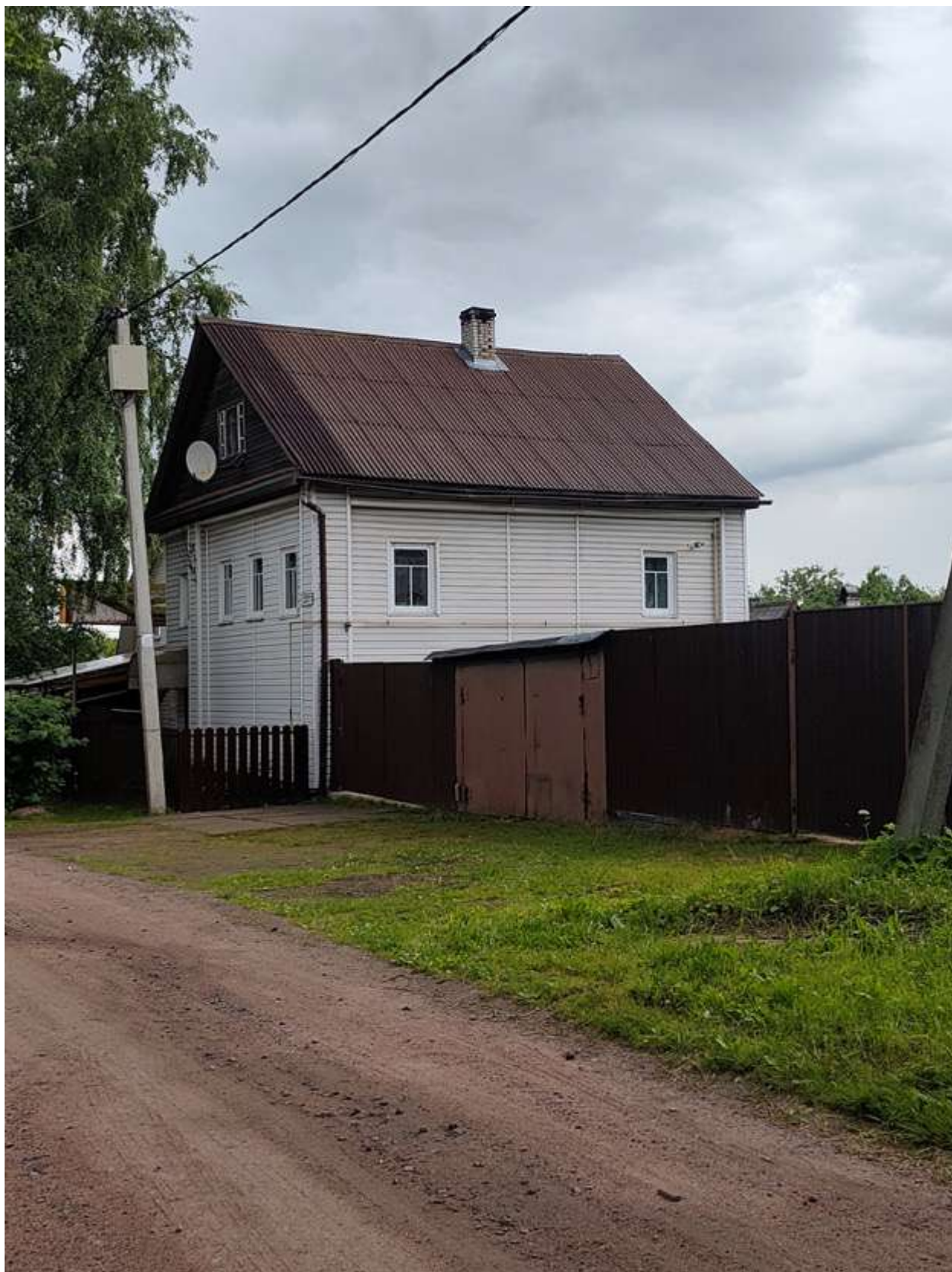
1. Северо-восточный и северо-западный фасады.
