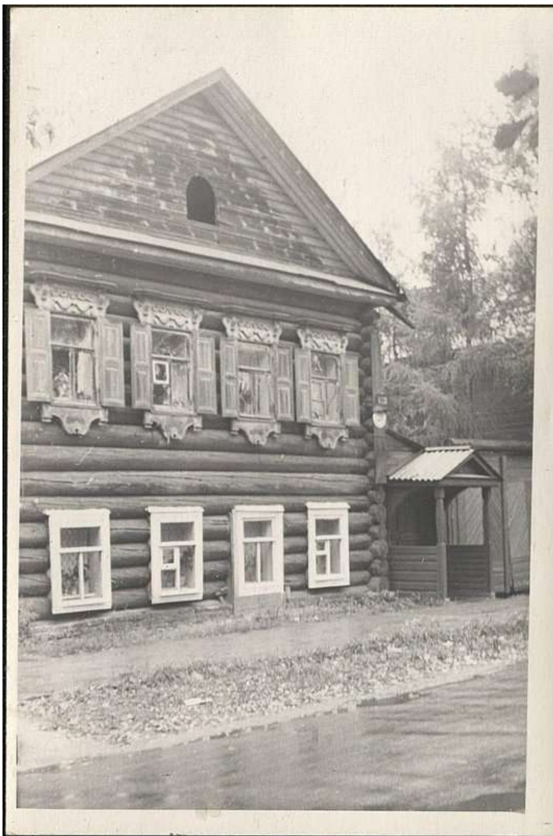
18. Тихвин. Дом в старом городе (Ул. Новгородская, д. 29). 1973 г.
