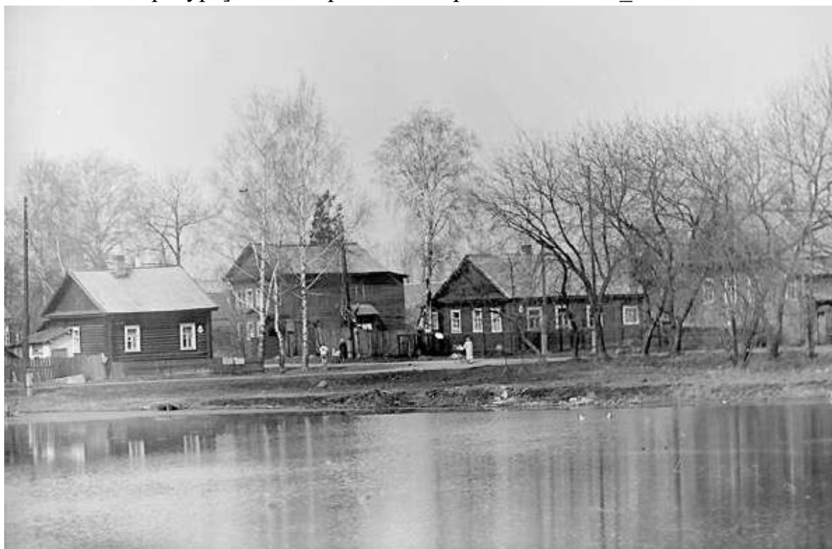
26. Перекрёсток улиц Васильева и Ращупкина. Вид с улицы Красной. Весна, 1990 год [Электронный ресурс] URL: https://vk.com/photo-48380027_457260206
