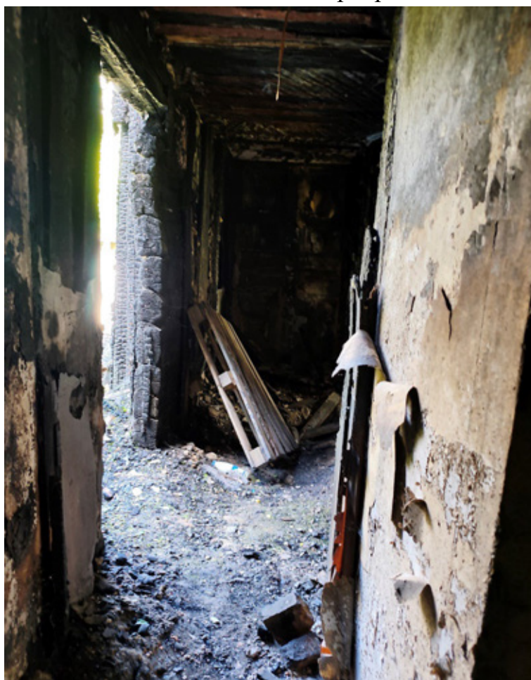
13. Часть интерьера 1 этажа, коридоры.
