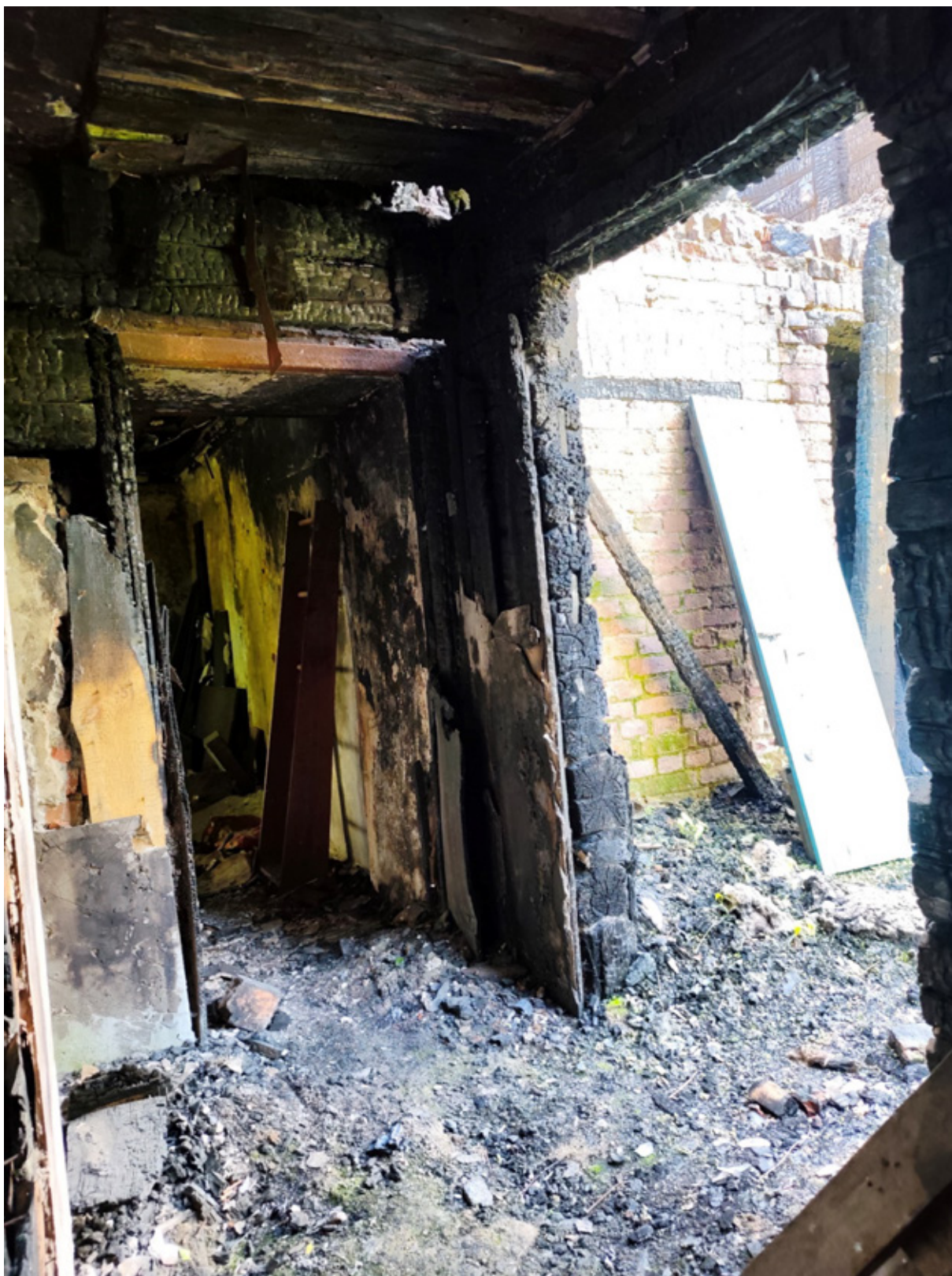
14. Часть интерьера 1 этажа, входной коридор.
