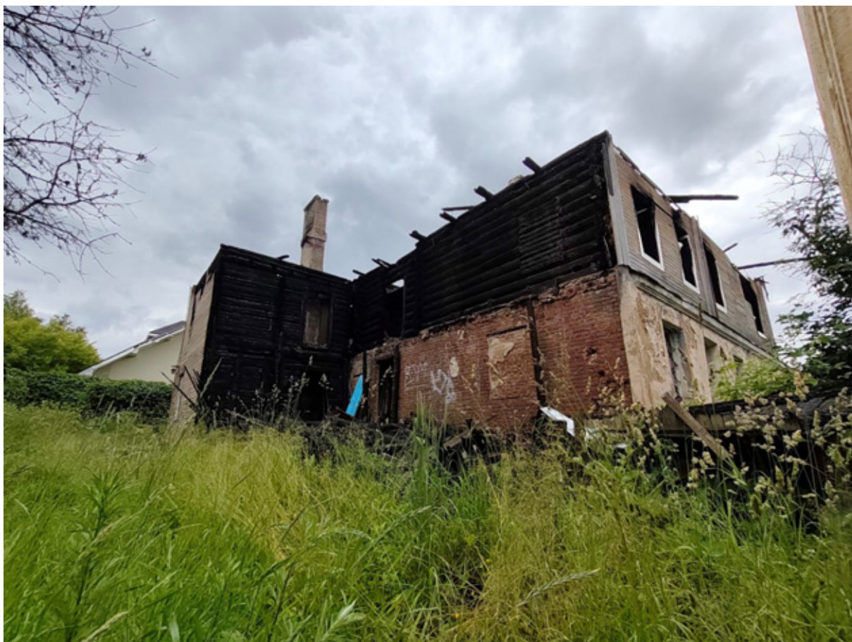
5. Вид с северо-запада.
