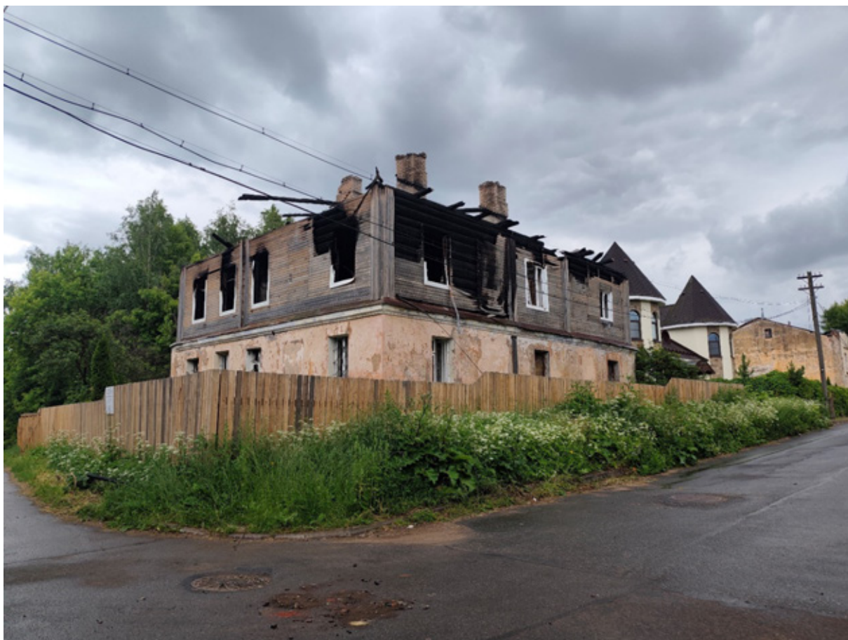
1. Западный и южный фасады.
