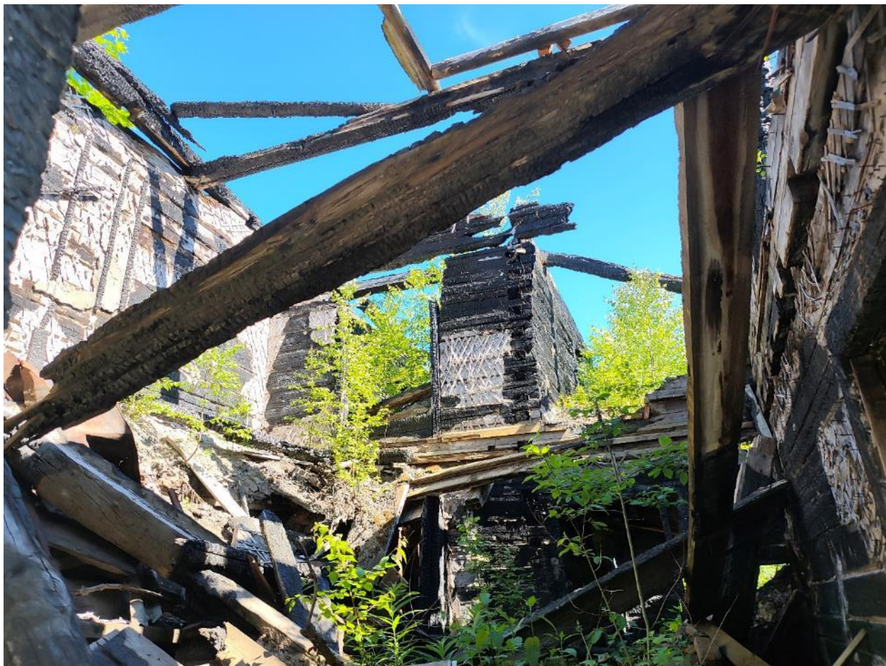
9. Общий вид центральной части дома.
