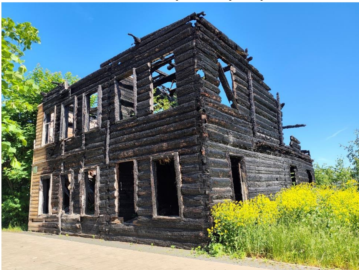
2. Общий вид объекта с запада.
