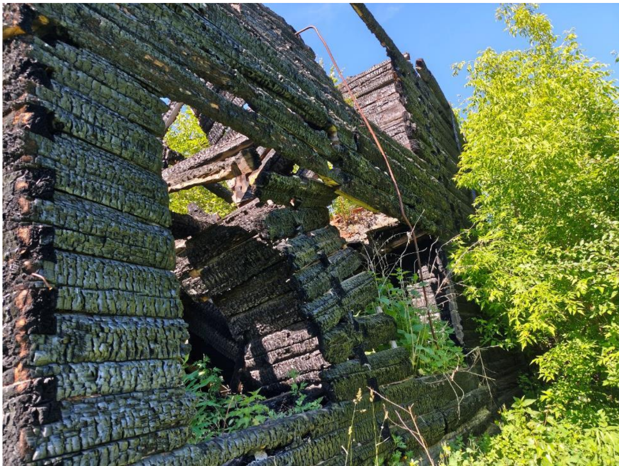
15. Вид вдоль восточного фасада.
