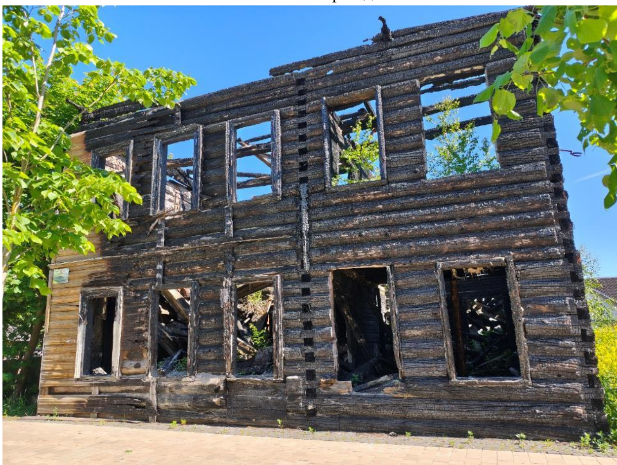
4. Западный лицевой фасад.
