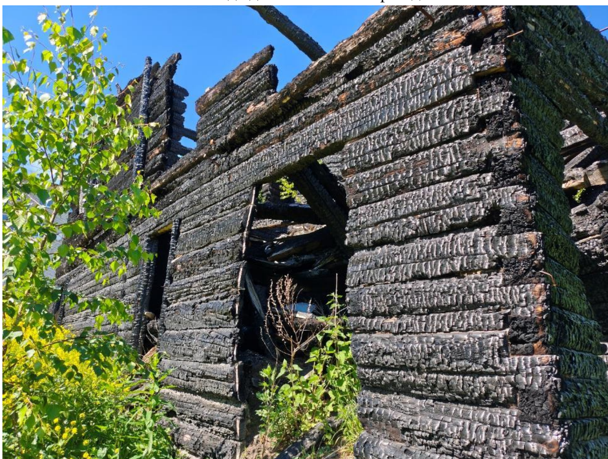
16. Вид на южный фасад с юга.
