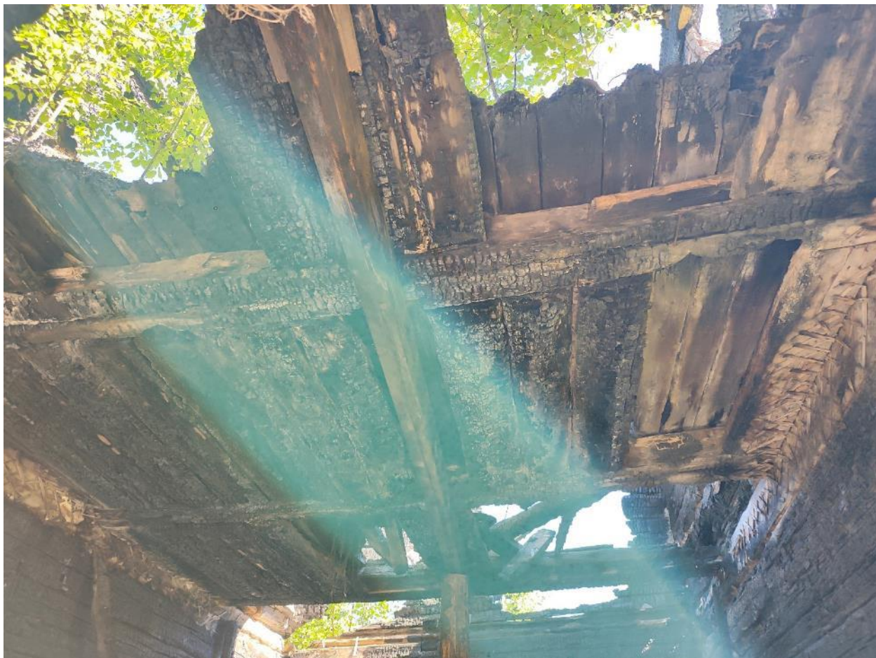
11. Фрагмент перекрытия в юго-западном помещении.
