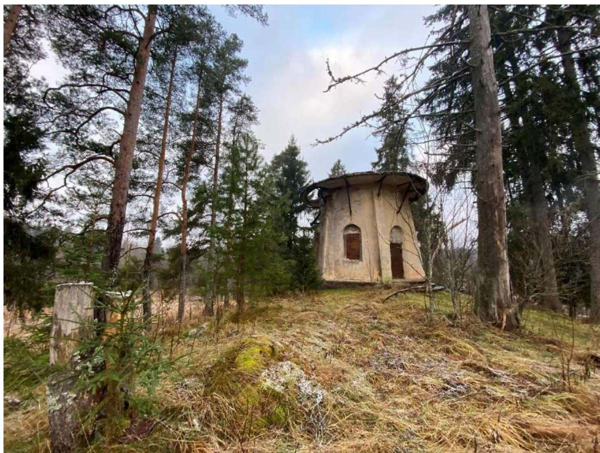
Фото 7. Вид на обсерваторию.
