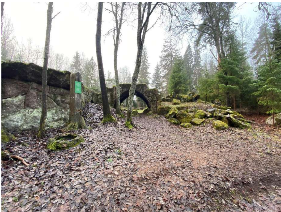
Фото 68. Вид на фрагменты цоколя, стену, огораживающую двор, и арочный проезд.
