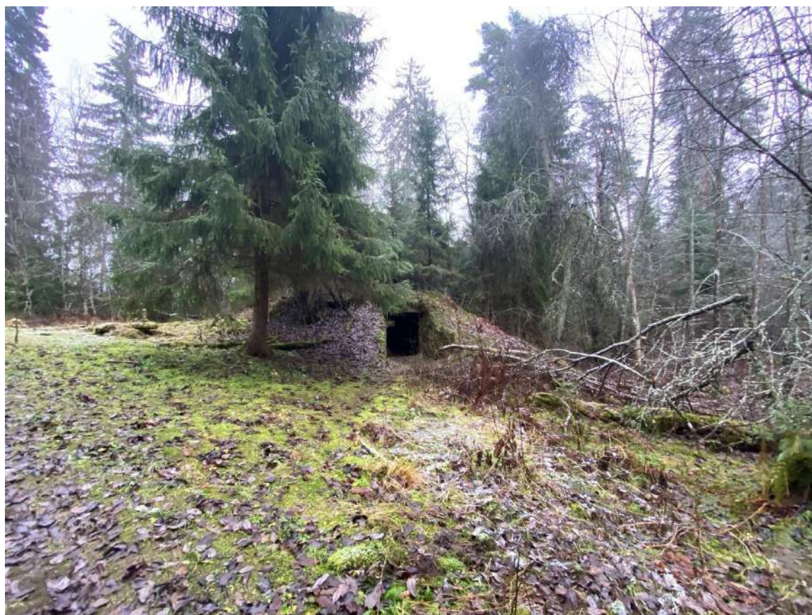
Фото 21. Хозяйственная постройка на территории бывшего имения Суур-Мерийоки.
