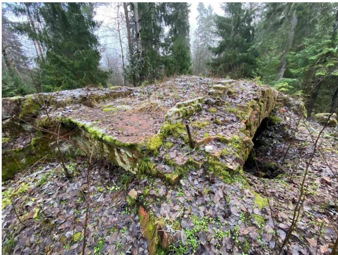
Фото 36. Фрагмент цоколя усадебного дома.
