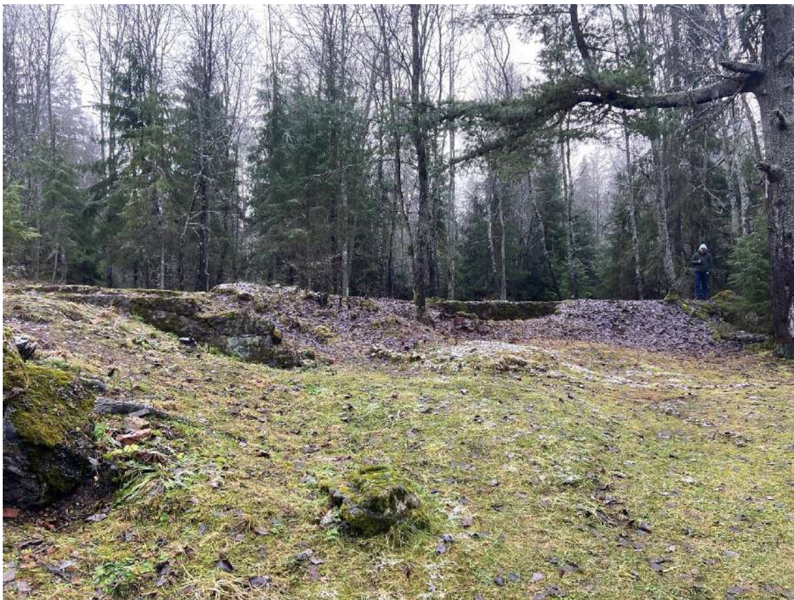
Фото 77. Вид на фрагмент цоколя.
