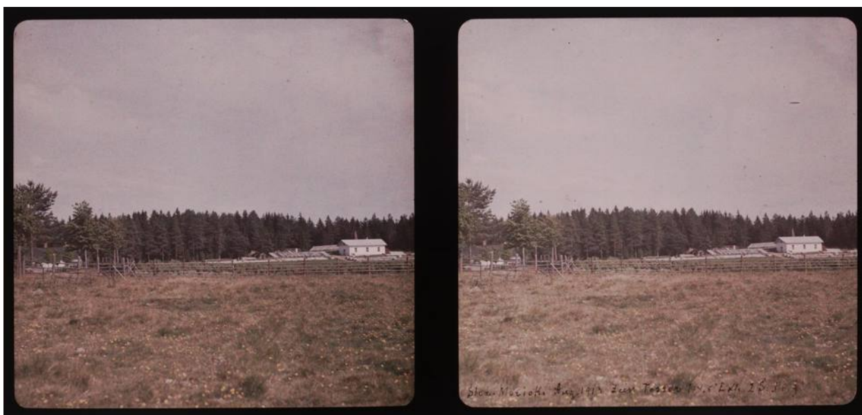
Илл. 70. Конюшня и другие хозяйственные постройки на территории усадьбы. Дата: 1913 г. Автор: М. Нойшеллер. Источник: https://finna.fi/Record/fmp.D1970:11%2F9?sid=5359897836
