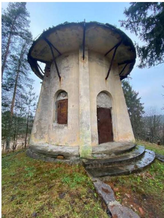
Фото 2. Вид на обсерваторию.
