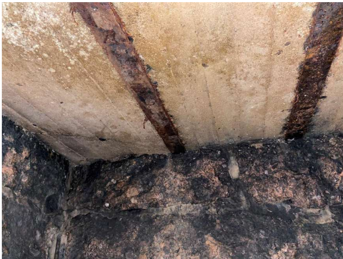
Фото 23. Помещение хозяйственной постройки.
