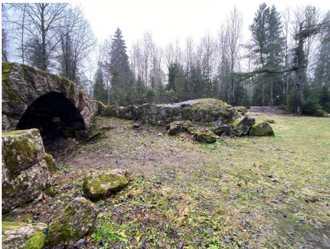
Фото 74. Вид на фрагмент цоколя.
