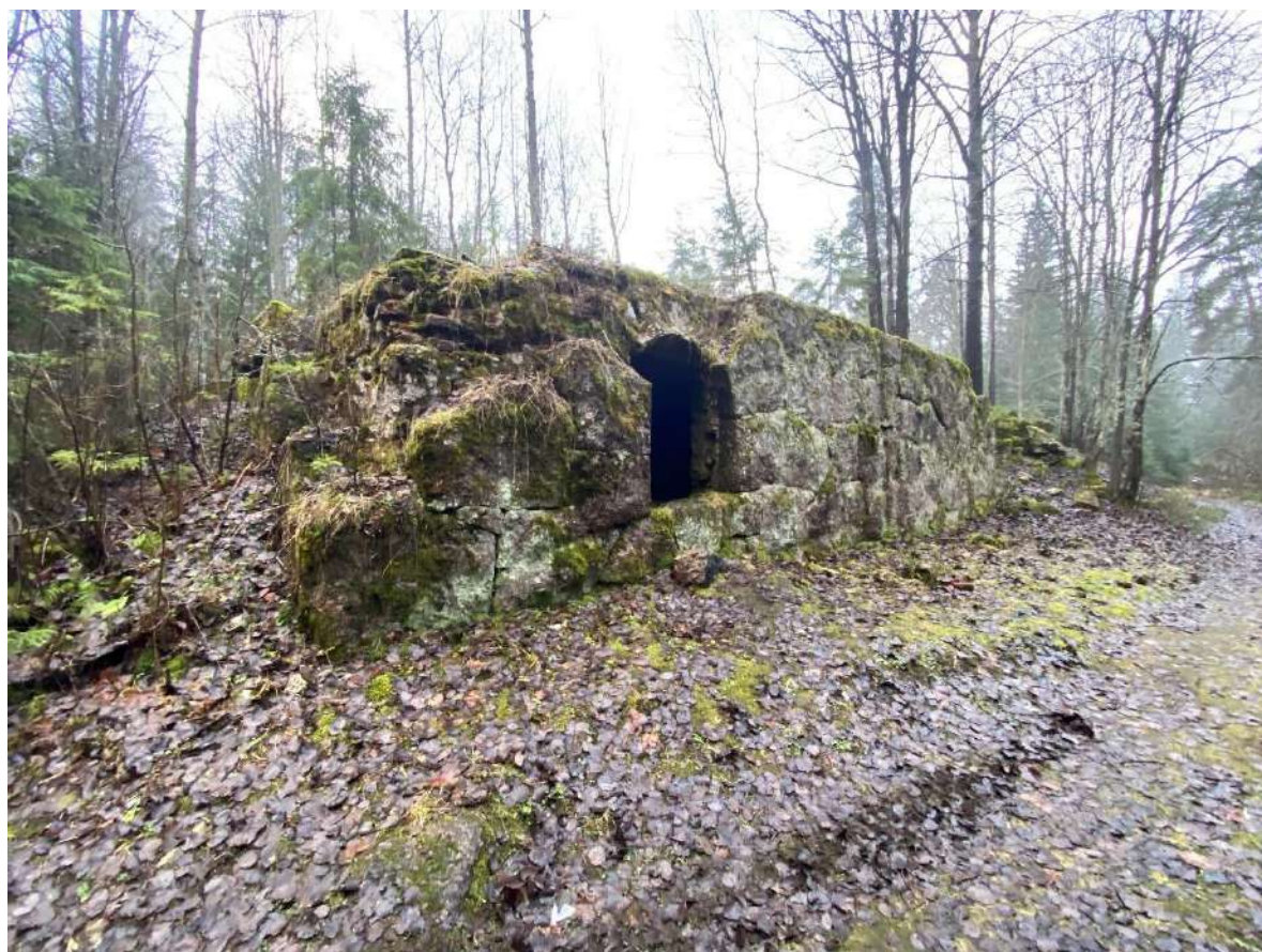
Фото 27. Фрагмент цоколя усадебного дома.
