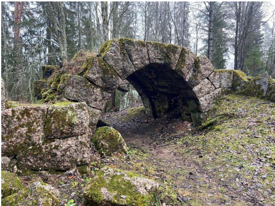
Фото 73. Вид на арочный проезд.
