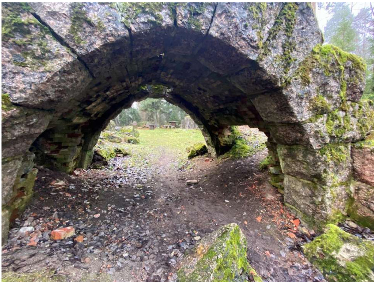
Фото 70. Вид на арочный проезд.
