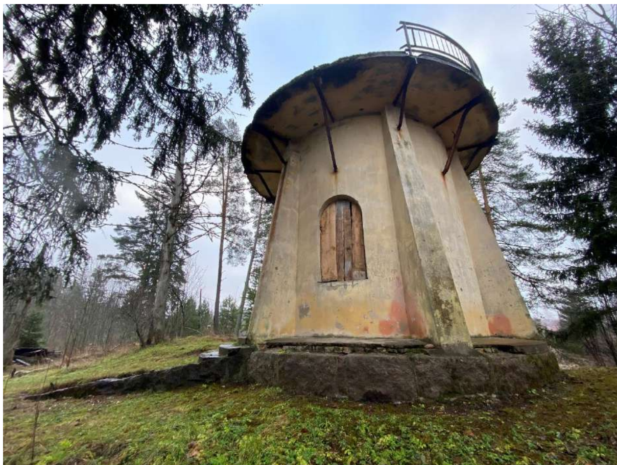
Фото 6. Вид на обсерваторию.
