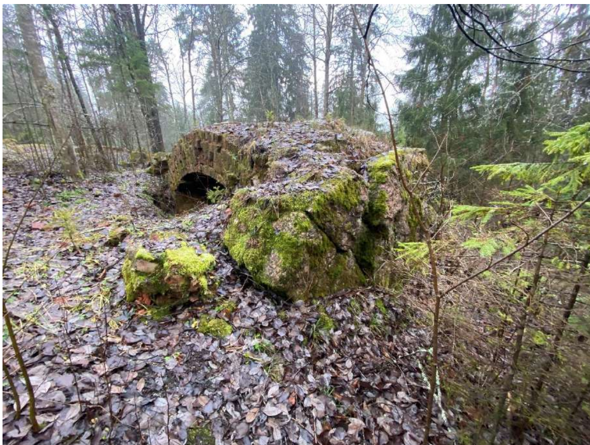
Фото 38. Фрагмент цоколя усадебного дома.
