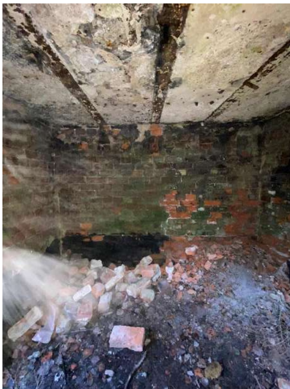
Фото 30. Фрагмент цокольного помещения усадебного дома.
