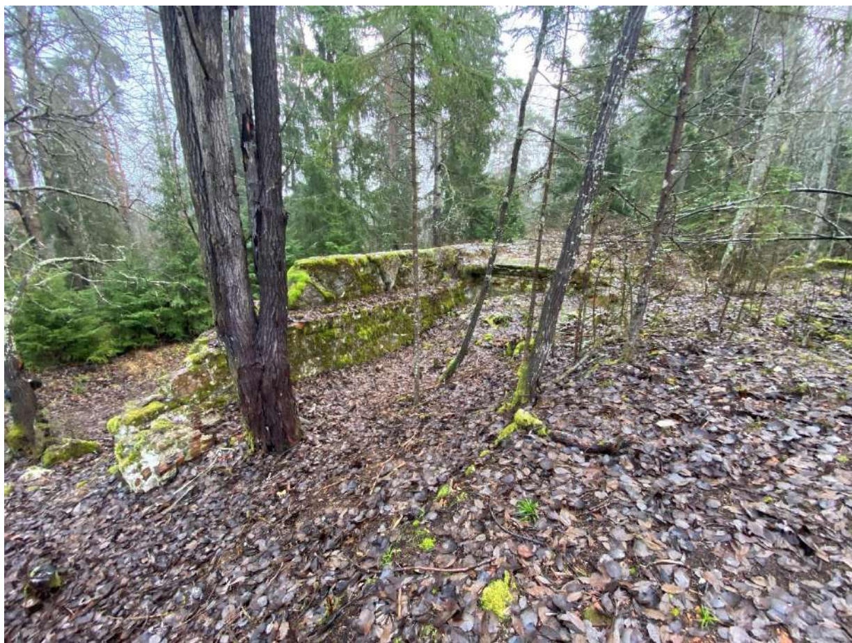
Фото 34. Фрагмент цоколя усадебного дома.
