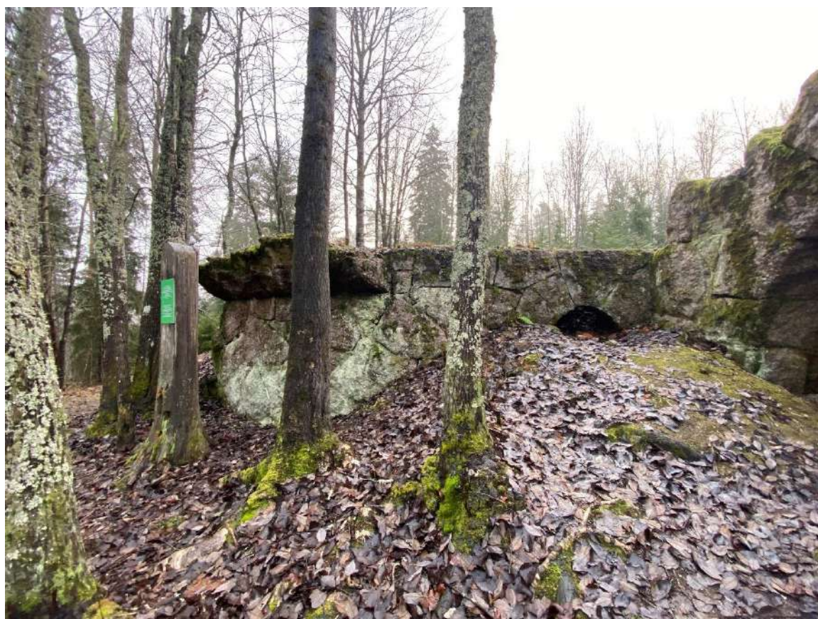
Фото 69. Вид на фрагмент цоколя.
