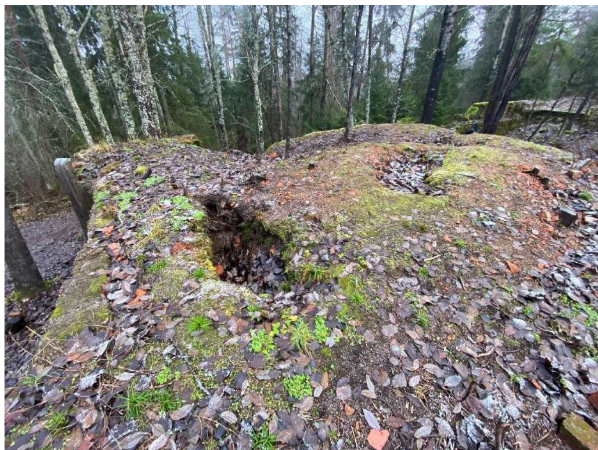
Фото 82. Фрагменты фундамента и цоколя.
