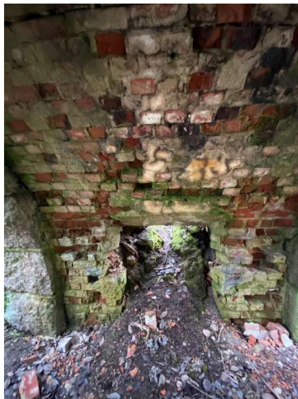
Фото 72. Вид на арочный проезд.
