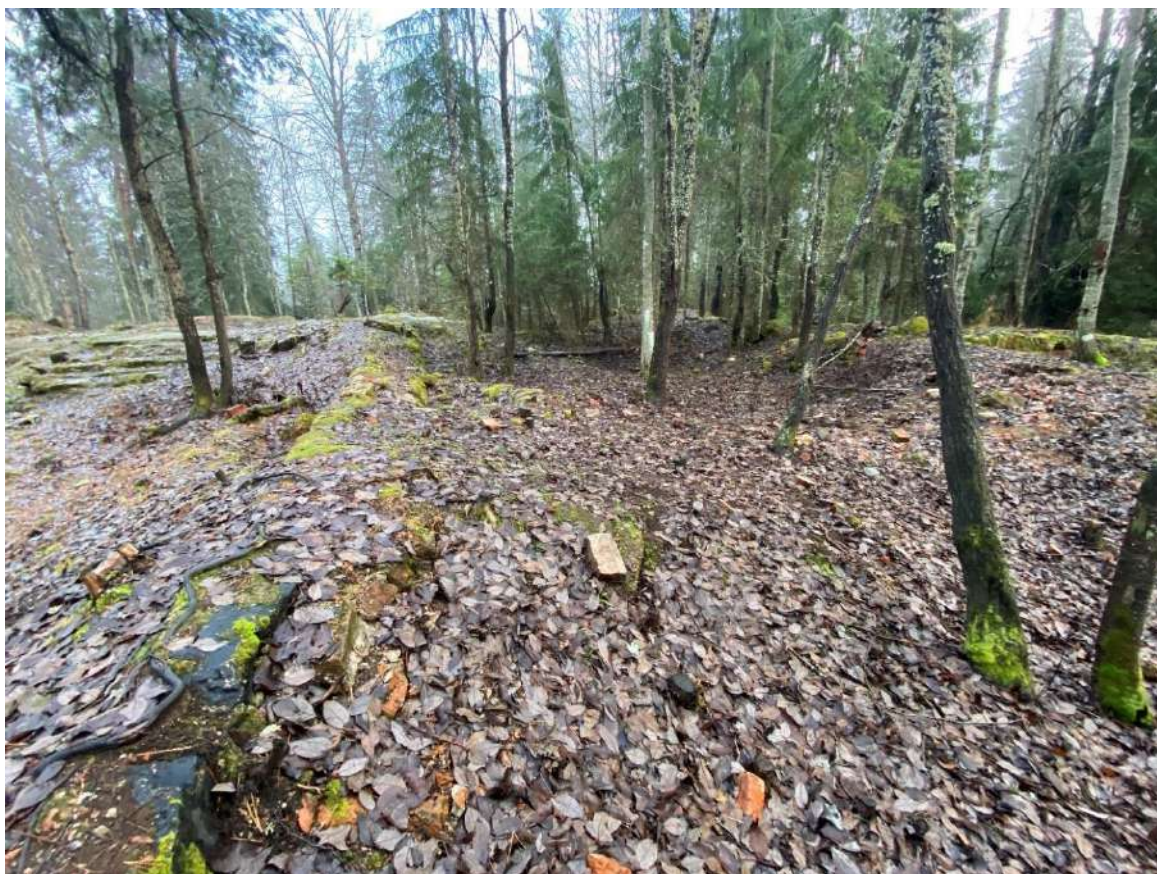
Фото 54. Фрагменты фундамента и цоколя.
