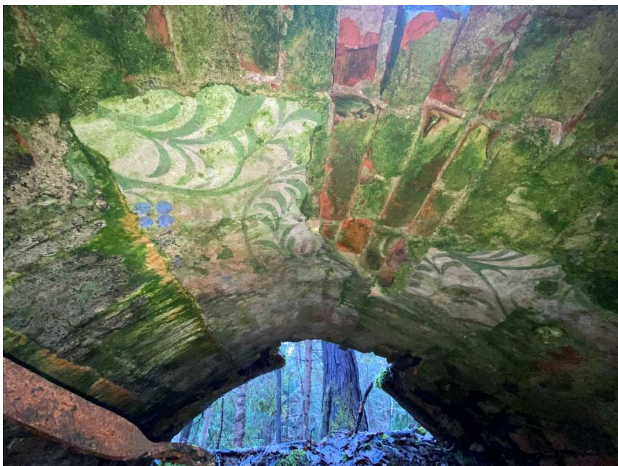
Фото 41. Роспись внутри оконного проема цокольного этажа.
