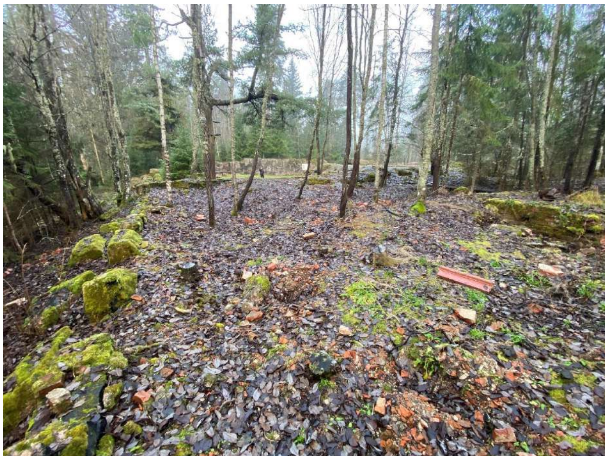
Фото 50. Фрагменты фундамента и цоколя.
