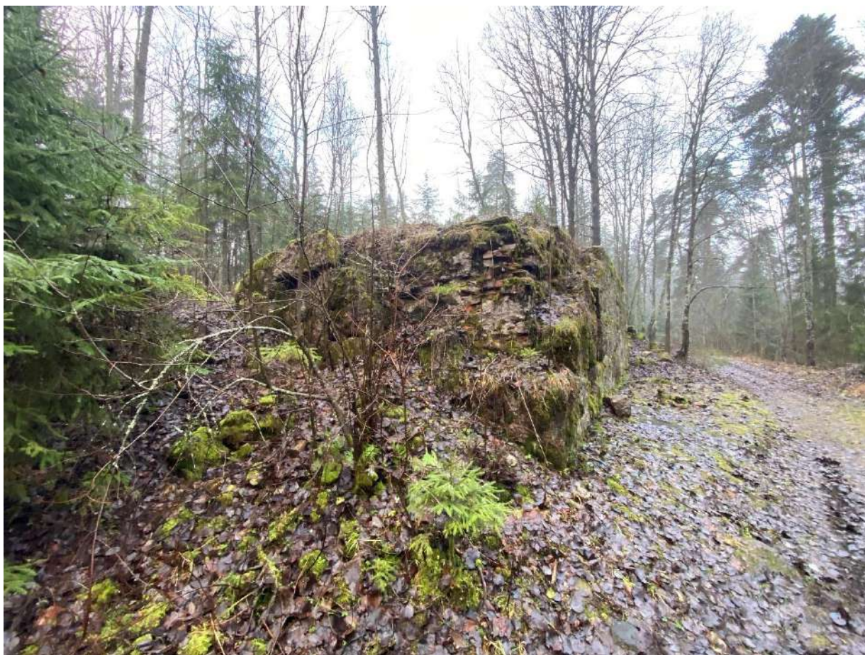
Фото 26. Фрагмент цоколя усадебного дома.
