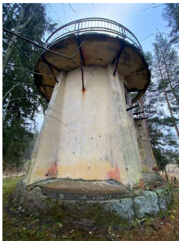
Фото 5. Вид на обсерваторию.
