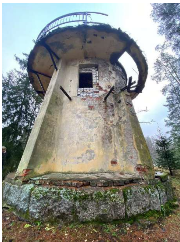
Фото 4. Вид на обсерваторию.
