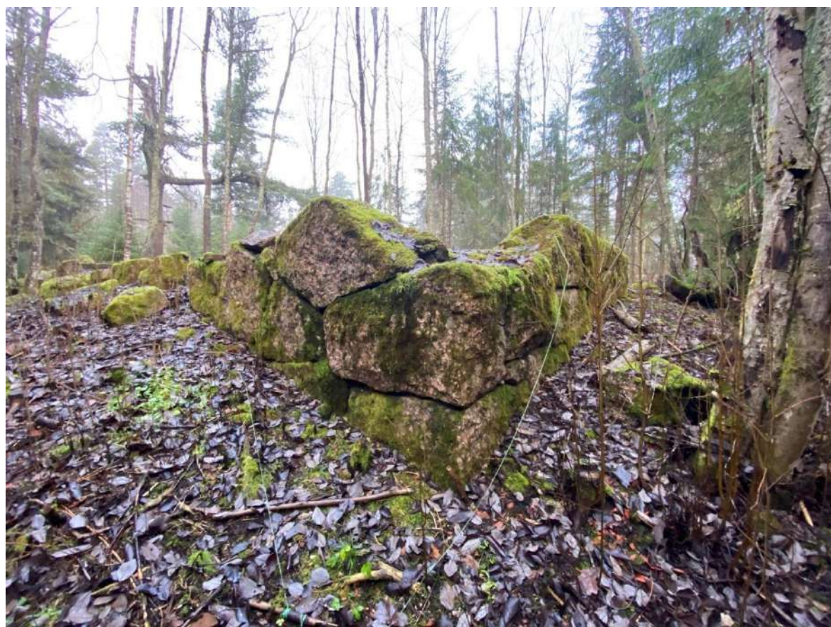
Фото 51. Фрагменты фундамента и цоколя.
