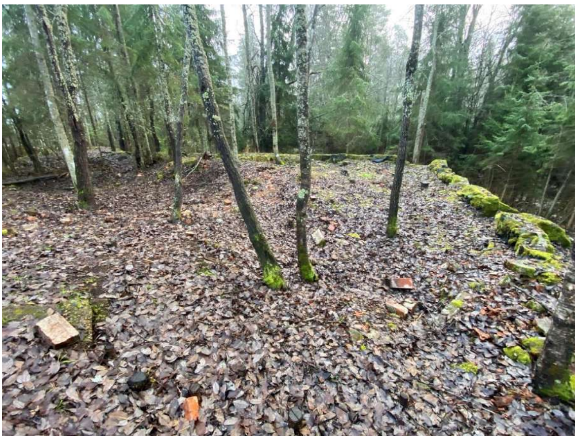
Фото 53. Фрагменты фундамента и цоколя.
