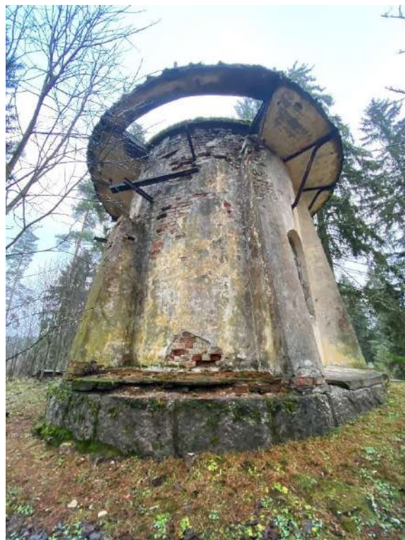
Фото 3. Вид на обсерваторию.
