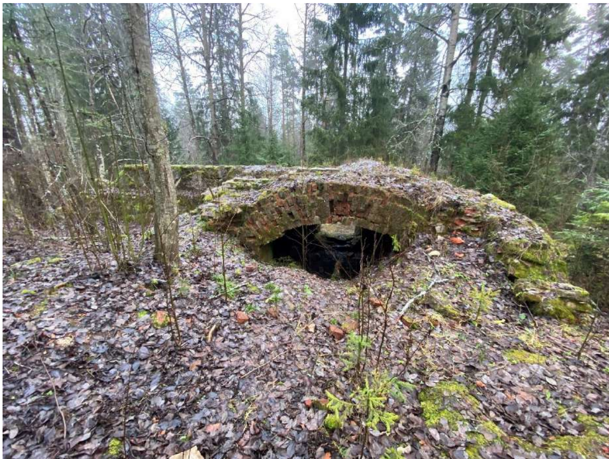
Фото 37. Фрагмент цоколя усадебного дома.
