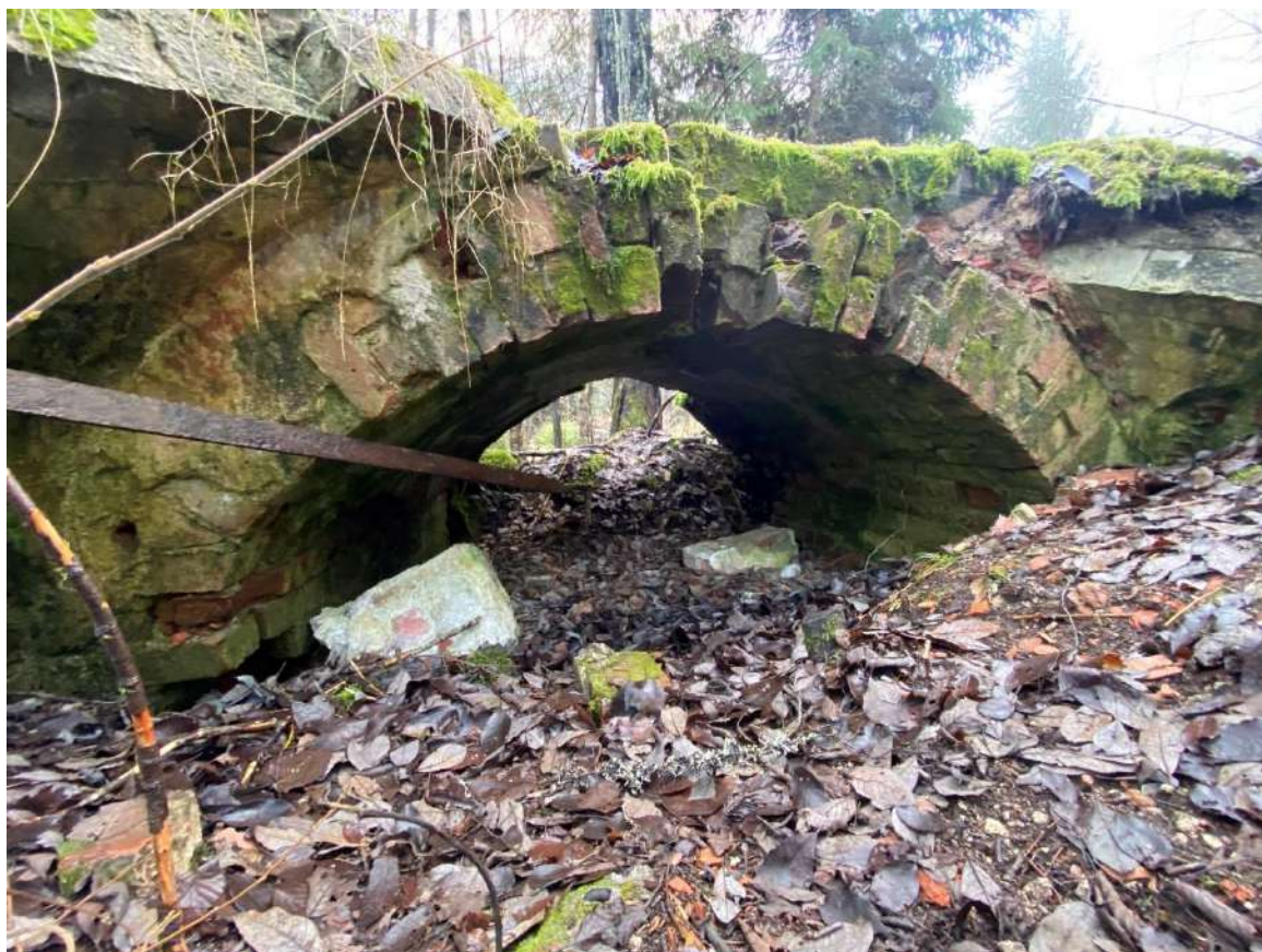
Фото 40. Вид на оконный проем, расположенный в цоколе.
