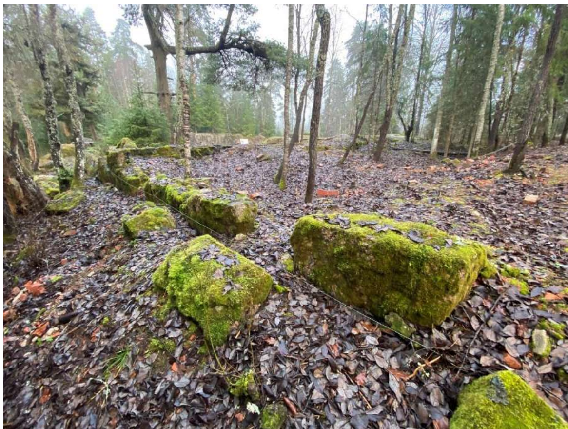
Фото 52. Фрагменты фундамента и цоколя.
