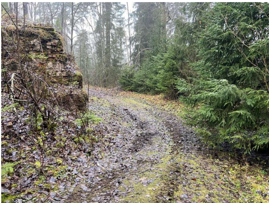
Фото 25. Фрагмент цоколя усадебного дома.
