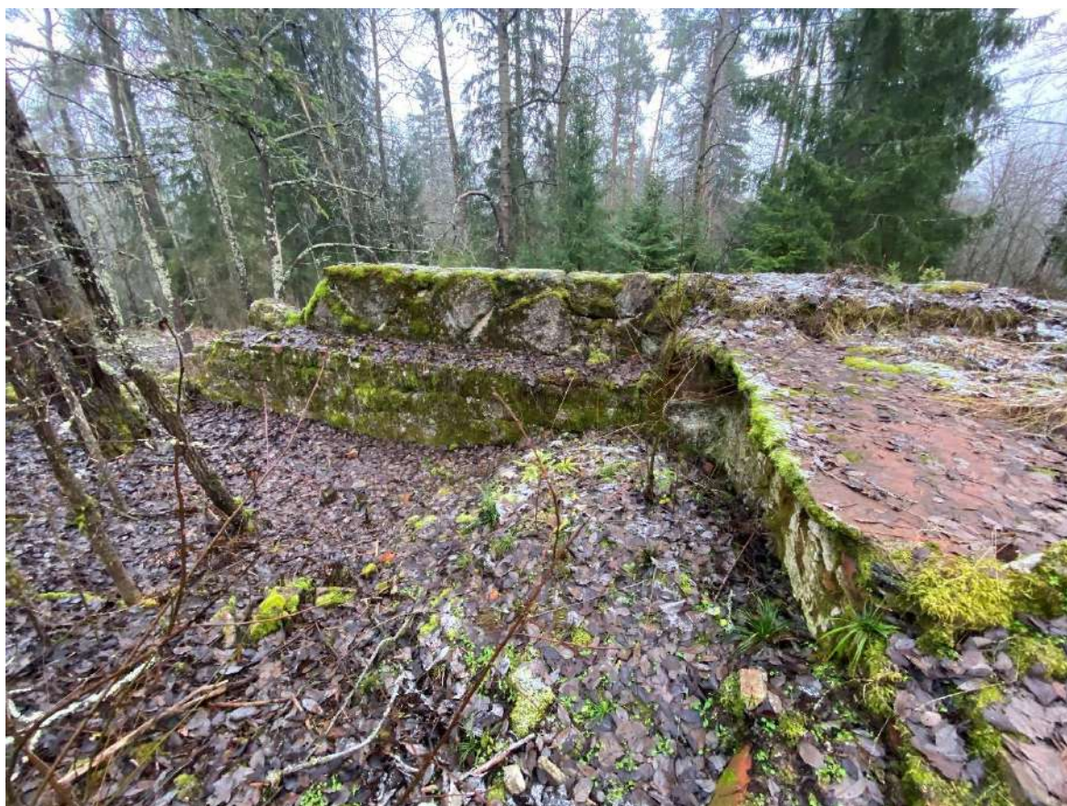
Фото 35. Фрагмент цоколя усадебного дома.
