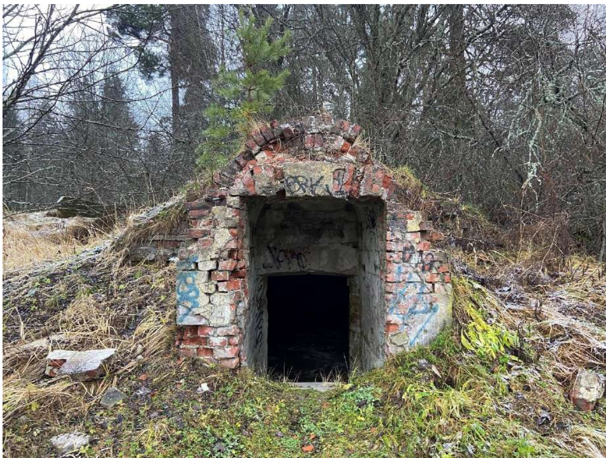
Фото 16. Хозяйственная постройка на территории бывшего имения Суур-Мерийоки.
