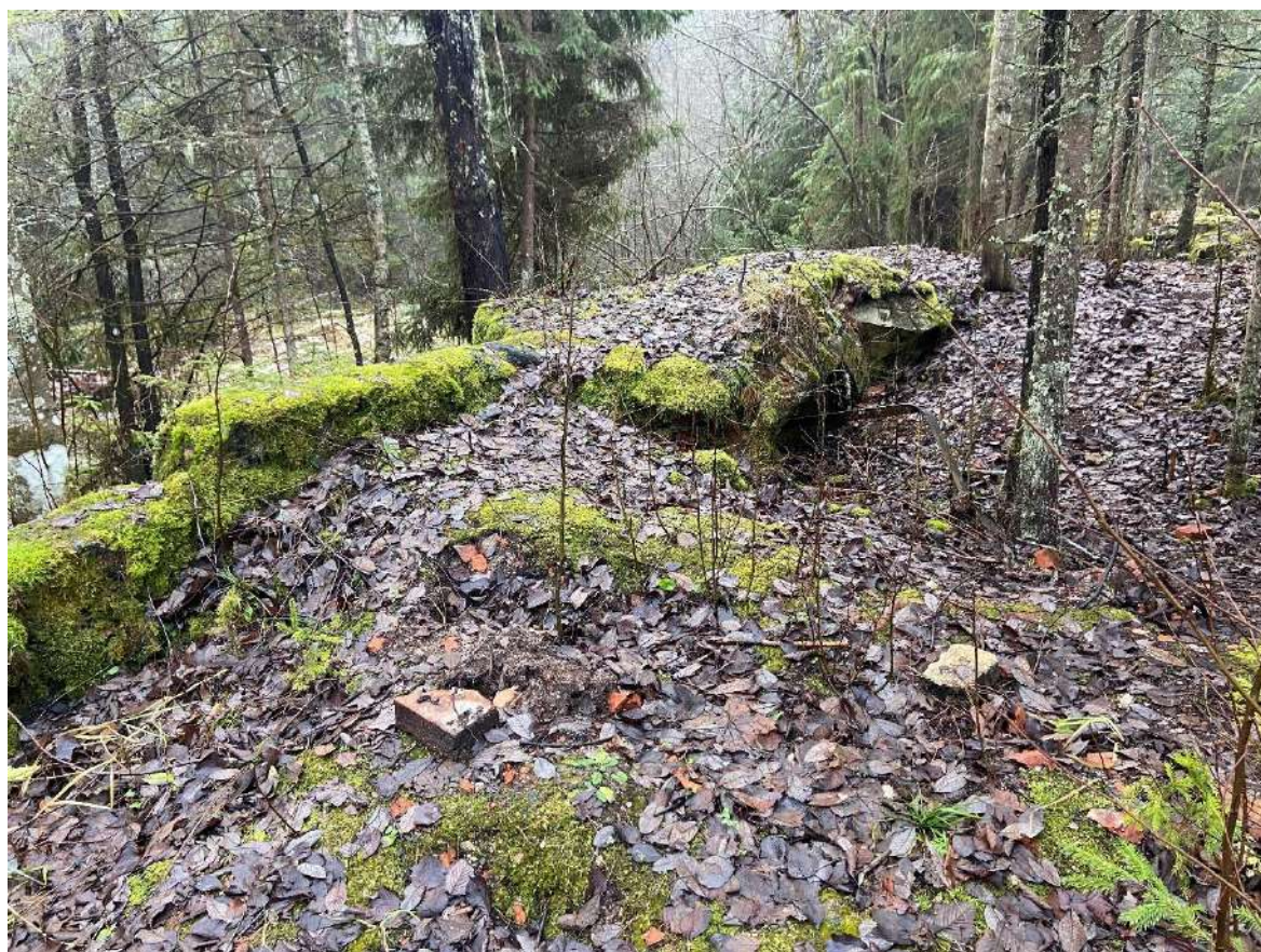
Фото 39. Фрагмент цоколя усадебного дома.
