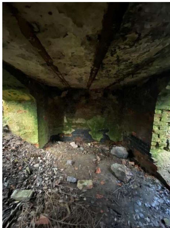
Фото 31. Фрагмент цокольного помещения усадебного дома.
