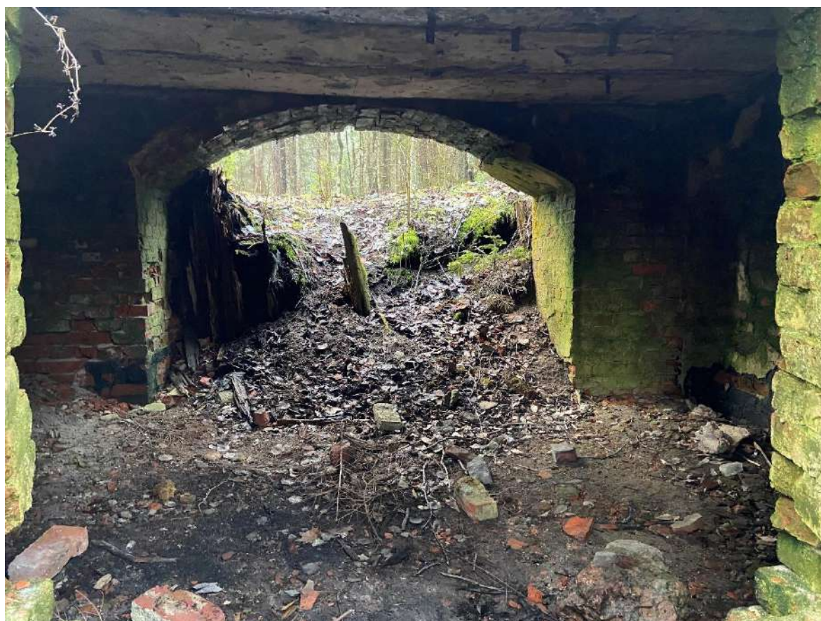
Фото 29. Фрагмент цокольного помещения усадебного дома.
