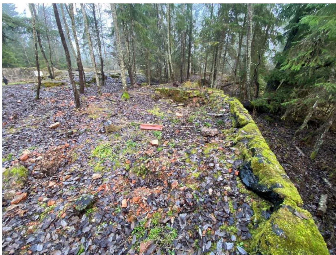
Фото 49. Фрагменты фундамента и цоколя.
