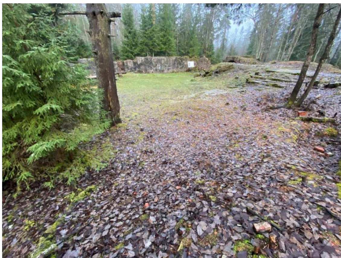
Фото 55. Фрагменты фундамента и цоколя. Вид на двор.
