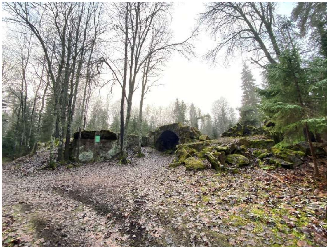
Фото 67. Вид на фрагменты цоколя, стену, огораживающую двор, и арочный проезд.
