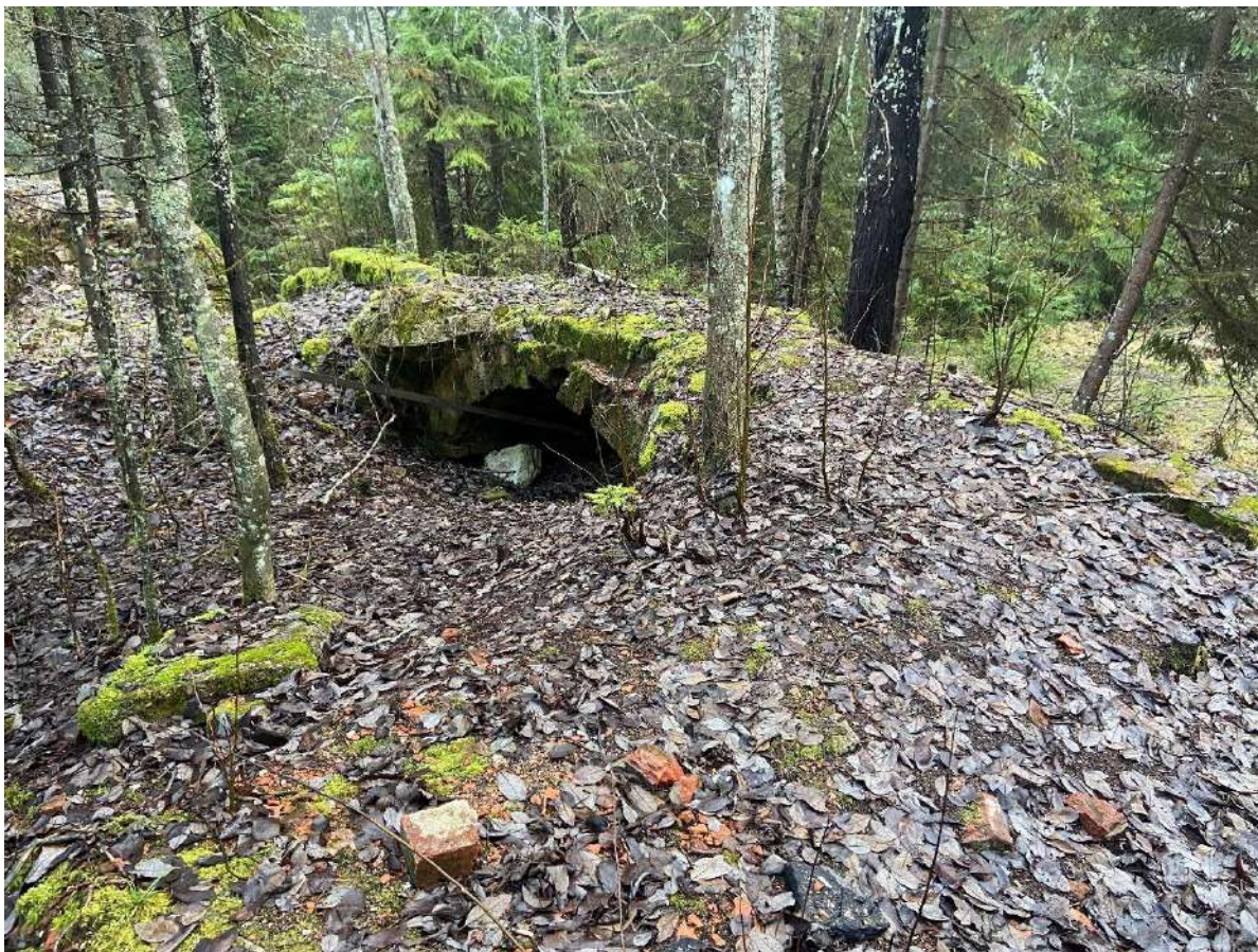
Фото 42. Вид на оконный проем, расположенный в цоколе.
