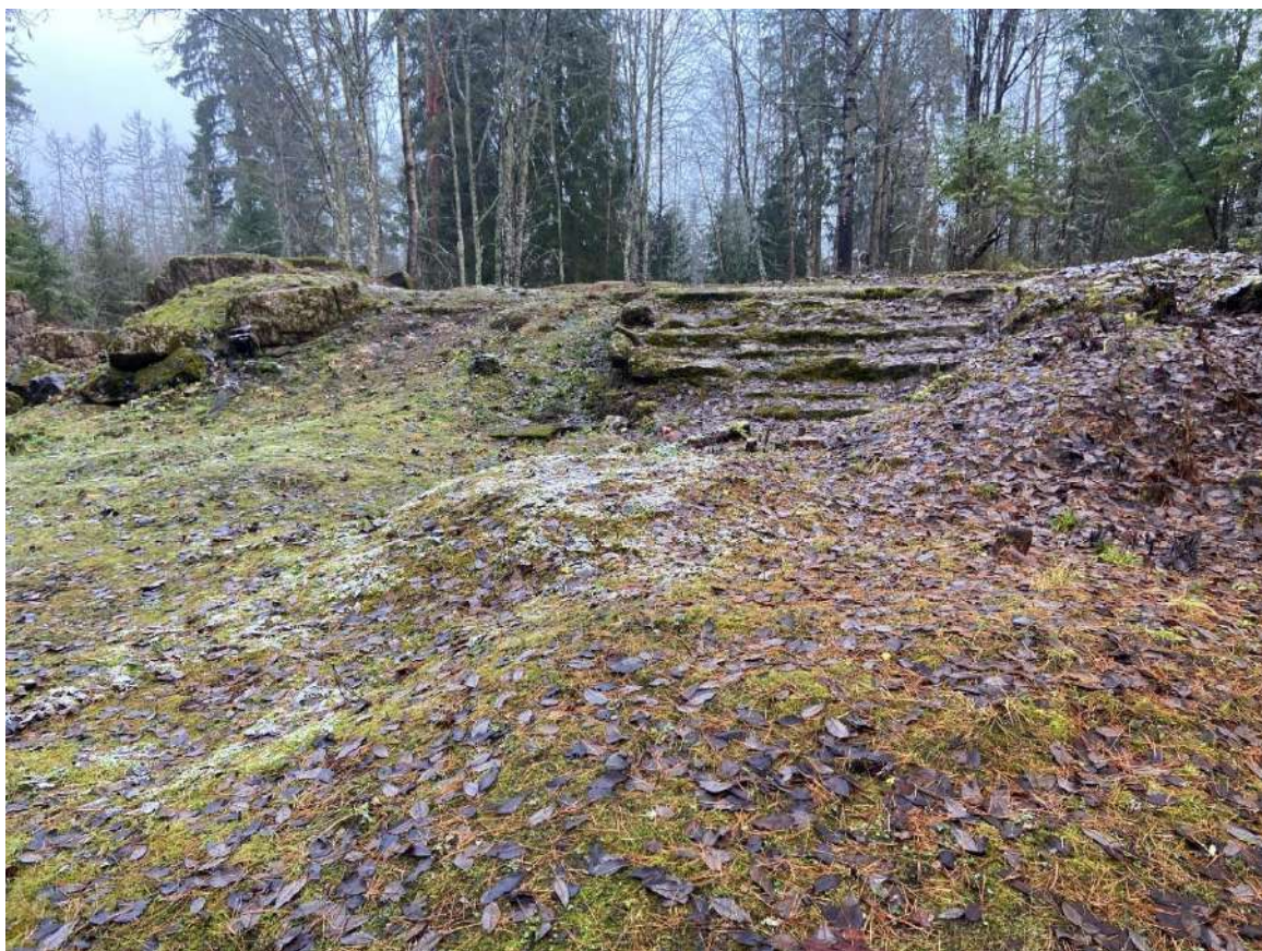
Фото 56. Фрагменты фундамента и цоколя. Вид на лестницу, ведущую к бывшему главному входу в дом.
