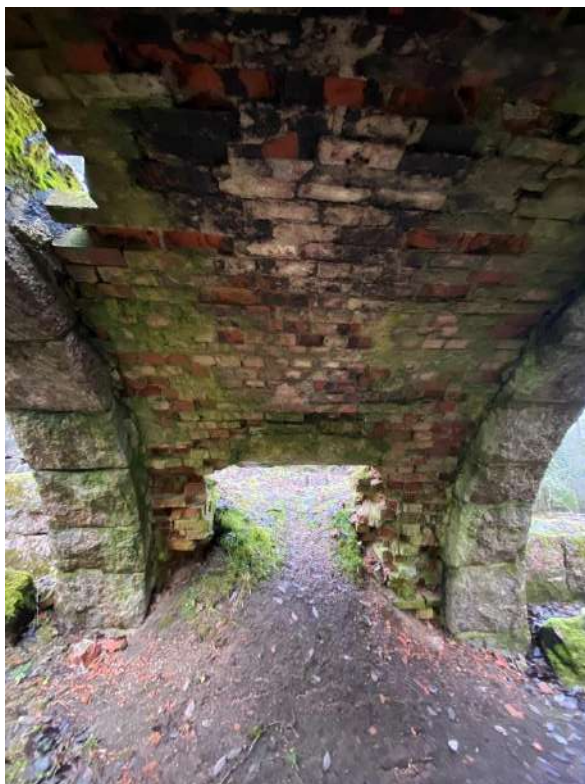
Фото 71. Вид на арочный проезд.
