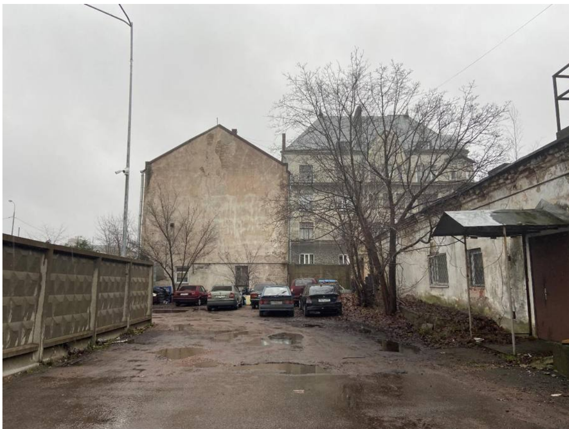
Фото 7. Вид на северо-западный фасад с Советской улицы.
