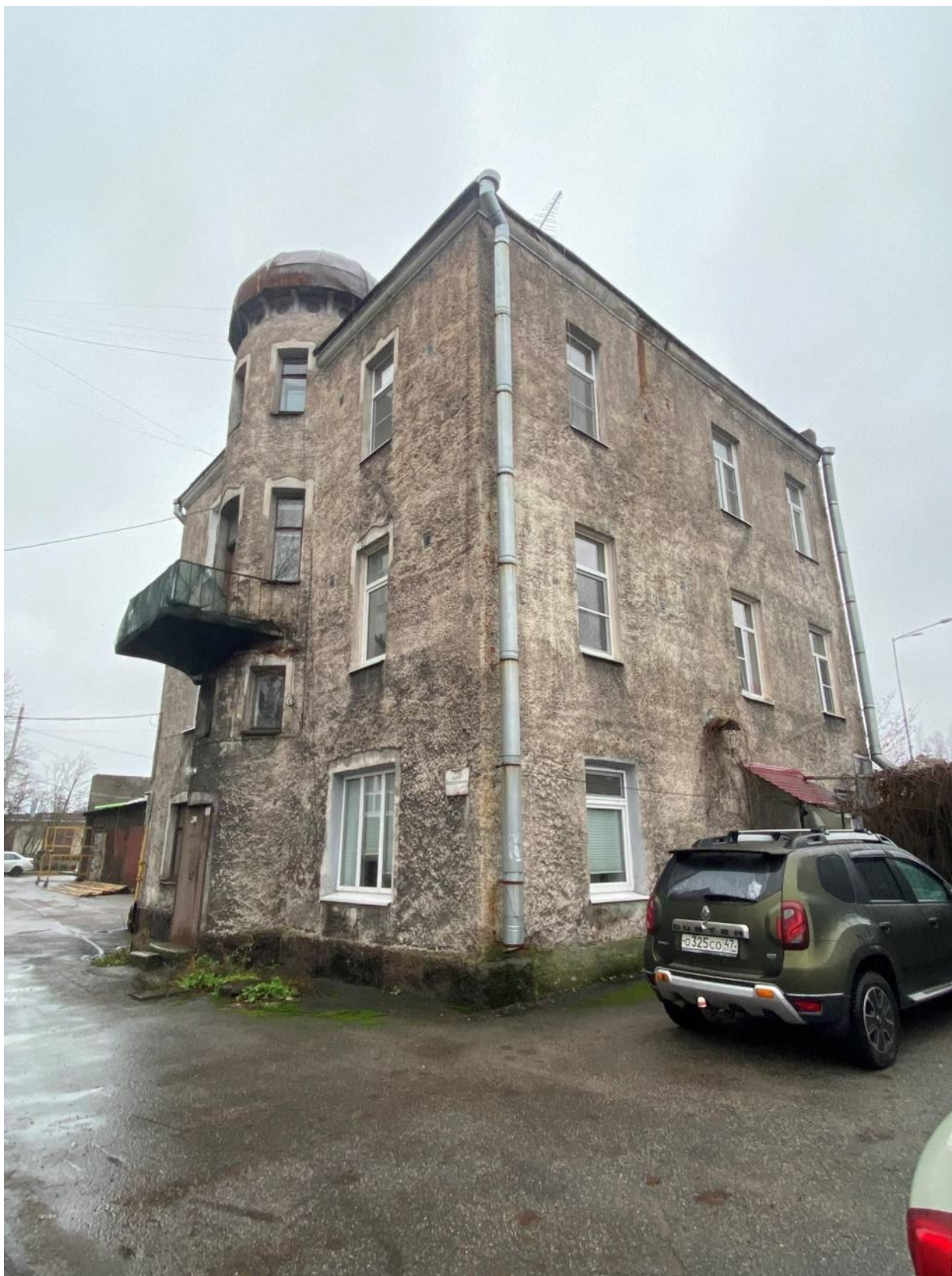
Фото 3. Вид на угол юго-восточного и северо-восточного фасадов.
