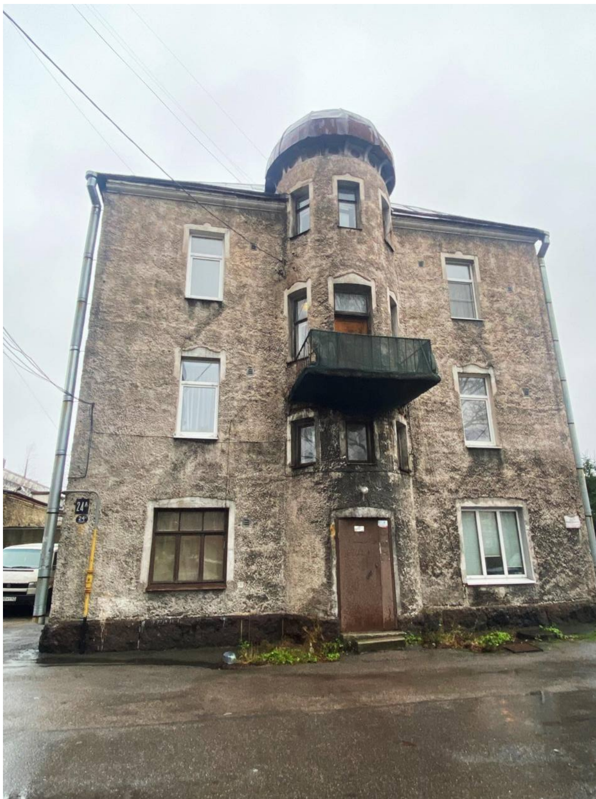
Фото 2. Вид на юго-восточный фасад.
