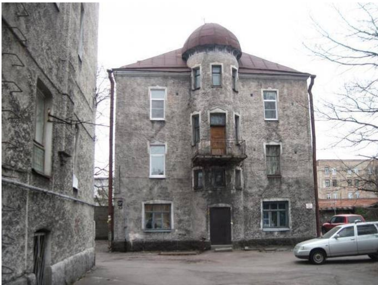
Илл. 21. Вид на дом № 24а по Морской набережной. Дата: 2012 г. Источник: wikimapia.org.
