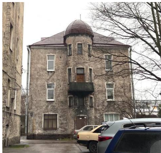
Лицевой фасад. Дата: 28.11.2025.
