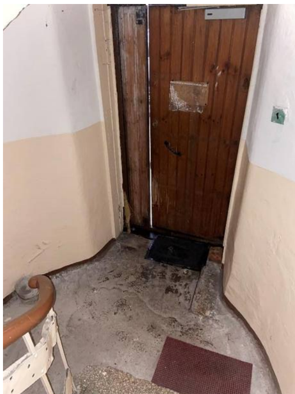
Фото 10. Вид на входную дверь.
