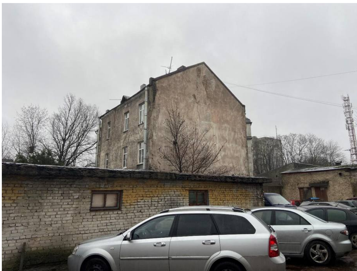
Фото 8. Вид на угол северо-западного и северо-восточного фасадов.
