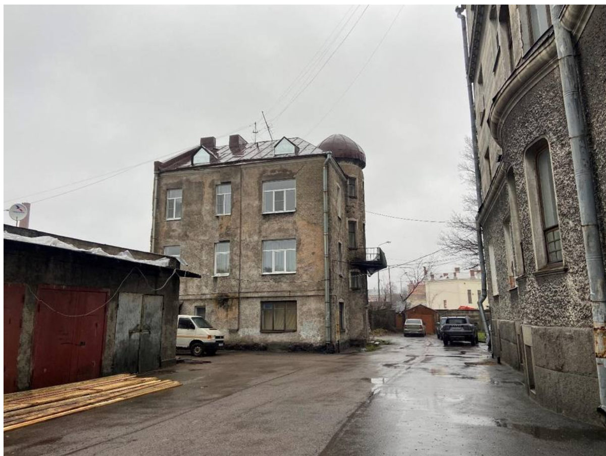
Фото 5. Вид на юго-западный фасад с Морской набережной.
