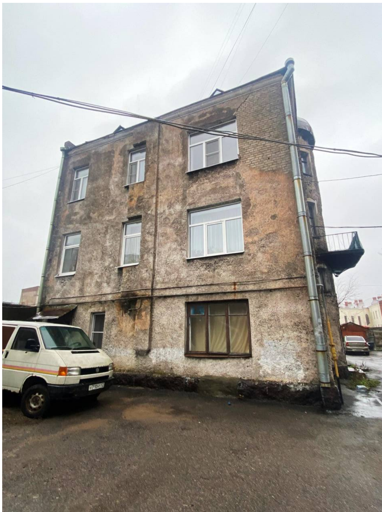
Фото 6. Вид на юго-западный фасад.
