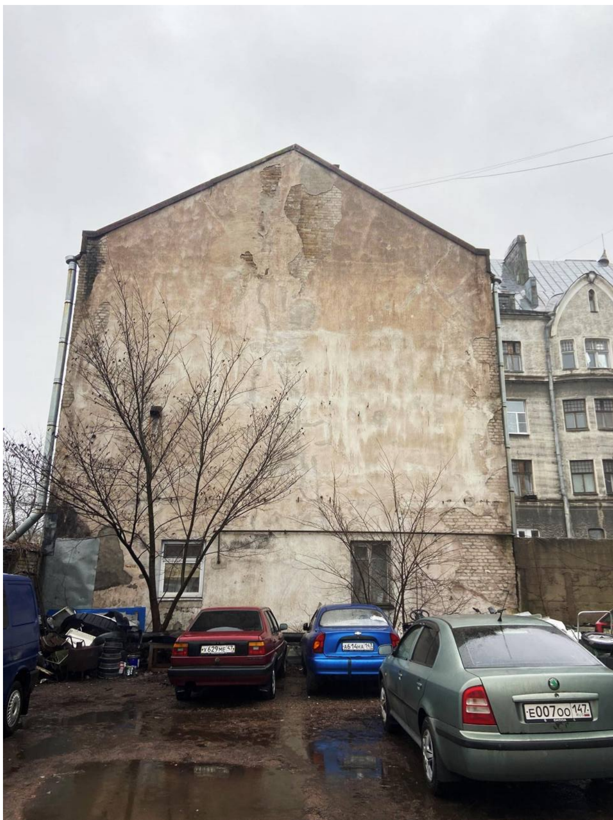
Фото 9. Вид на северо-западный фасад.
