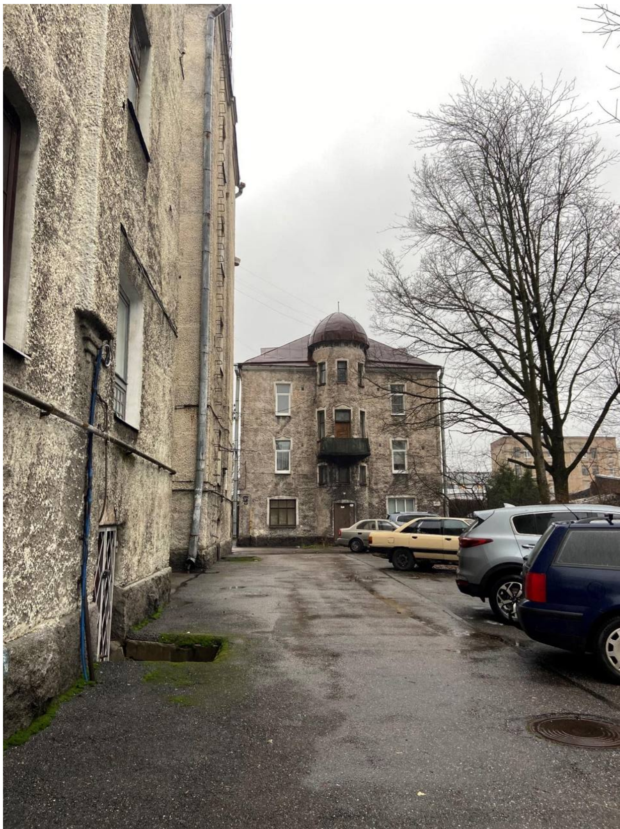
Фото 1. Вид на юго-восточный фасад с улицы Пушкина.
