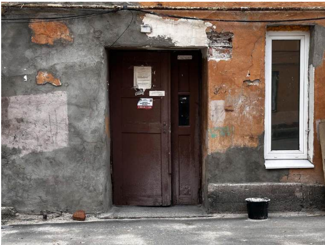
Фото 16. Фрагмент юго-восточного дворового фасада северо-западного крыла здания. Вход в жилую часть. Дата съемки: 29.06.2026 г. Автор съемки: Куваева Ю.П.
