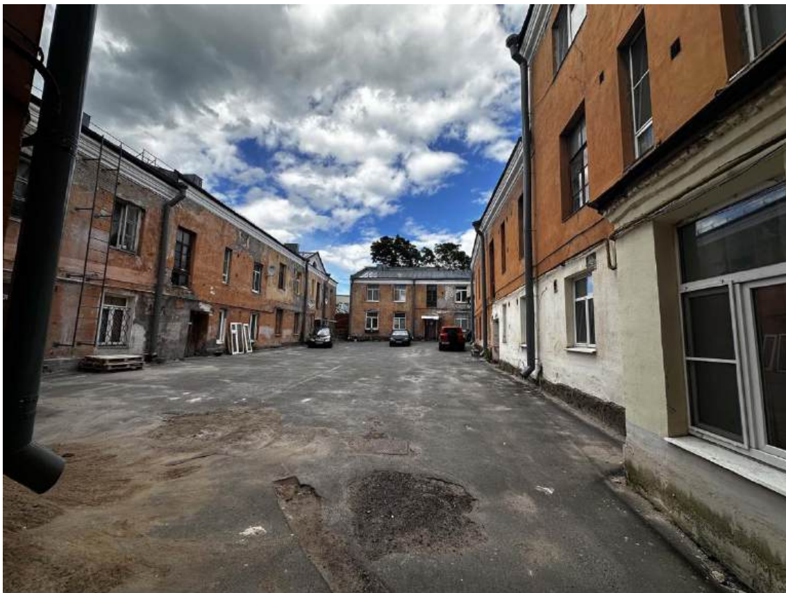
Фото 8. Общий вид дворовых фасадов здания с юго-запада. Дата съемки: 29.06.2026 г. Автор съемки: Куваева Ю.П.
