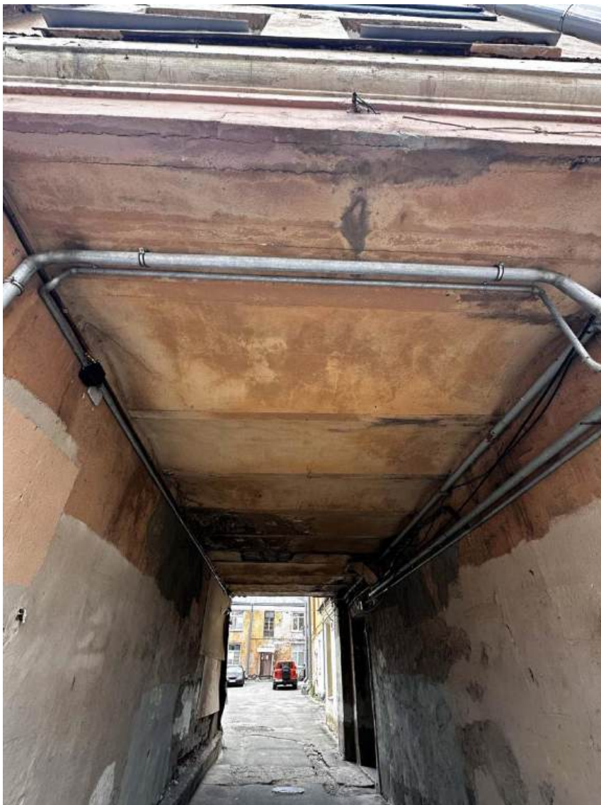
Фото 7. Сквозной арочный проезд. Перекрытие в виде кирпичных сводов «монье». Дата съемки: 29.06.2026 г. Автор съемки: Куваева Ю.П.
