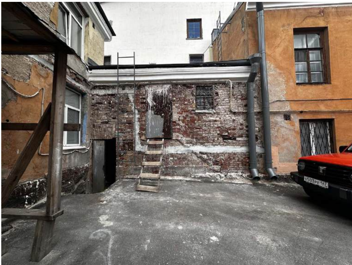
Фото 22. Общий вид северо-западного фасада пристройки к юго-восточному крылу здания. Фото с северо-запада. Дата съемки: 29.06.2026 г. Автор съемки: Куваева Ю.П.
