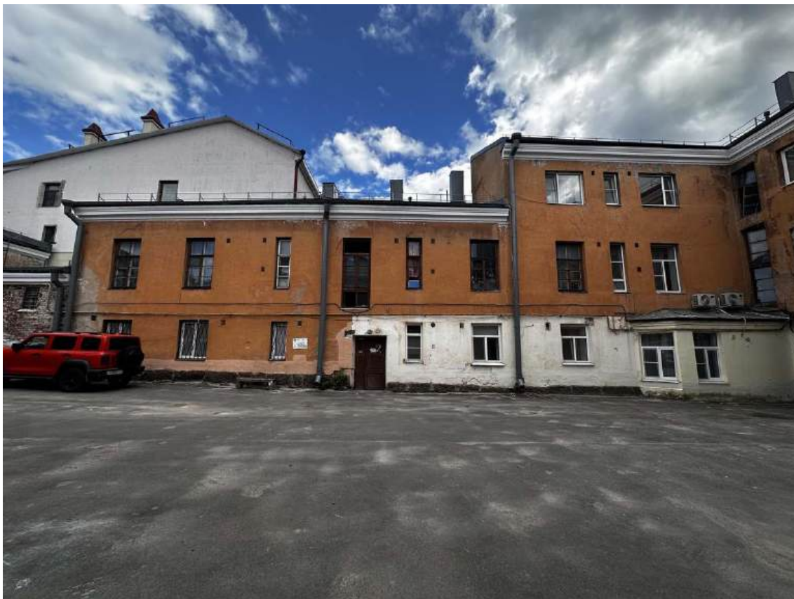
Фото 24. Общий вид северо-западного дворового фасада юго-восточного крыла здания. Дата съемки: 29.06.2026 г. Автор съемки: Куваева Ю.П.
