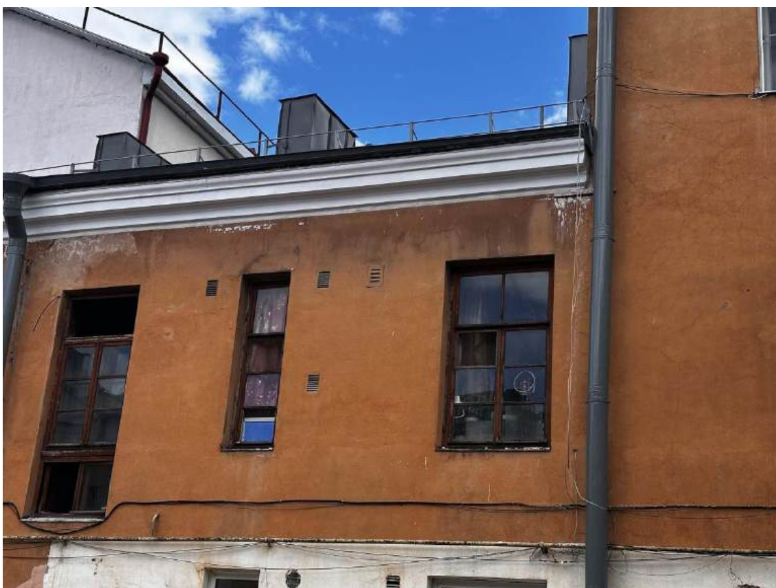
Фото 25. Фрагмент верхней правой части северо-западного дворового фасада юго-восточного крыла здания. Дата съемки: 29.06.2026 г. Автор съемки: Куваева Ю.П.
