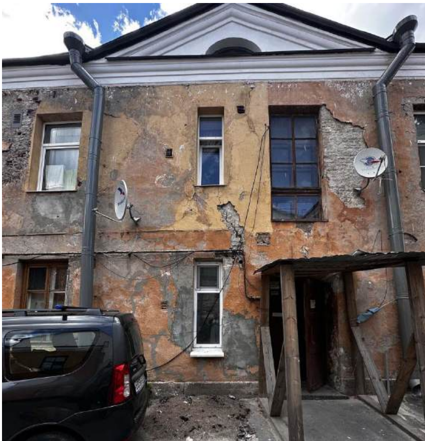
Фото 18. Фрагмент правой части юго-восточного дворового фасада северо-западного крыла здания. Дата съемки: 29.06.2026 г. Автор съемки: Куваева Ю.П.
