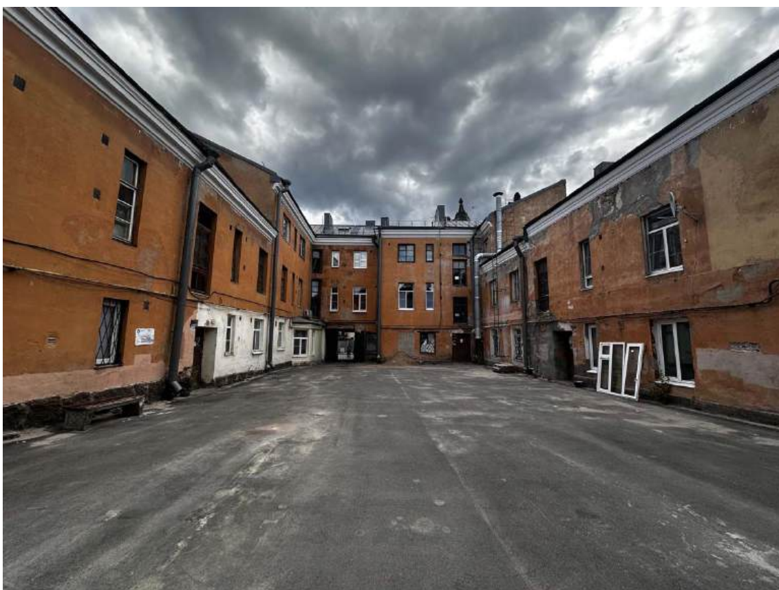
Фото 9. Общий вид дворовых фасадов здания с северо-востока. Дата съемки: 29.06.2026 г. Автор съемки: Куваева Ю.П.
