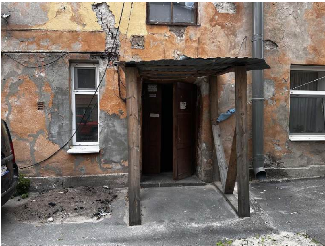
Фото 17. Фрагмент юго-восточного дворового фасада северо-западного крыла здания. Вход в жилую часть с правой стороны фасад. Дата съемки: 29.06.2026 г. Автор съемки: Куваева Ю.П.
