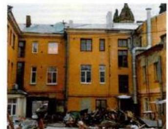
С-В дворовый фасад уличного корпуса
