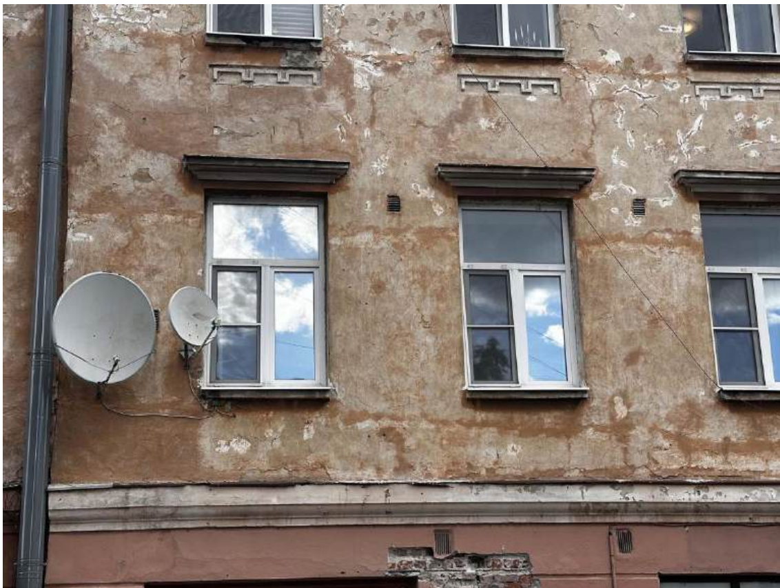
Фото 3. Фрагмент 2-го этажа лицевого юго-западного фасада здания. Дата съемки: 29.06.2026 г. Автор съемки: Куваева Ю.П.
