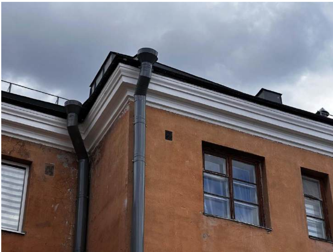
Фото 14. Фрагмент дворовых фасадов северо-западного крыла здания. Венчающие карнизы. Фото с юга. Дата съемки: 29.06.2026 г. Автор съемки: Куваева Ю.П.
