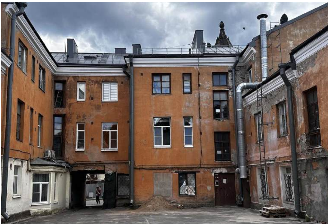
Фото 10. Северо-восточный дворовый фасад главного корпуса здания. Общий вид с северо-востока. Дата съемки: 29.06.2026 г. Автор съемки: Куваева Ю.П.
