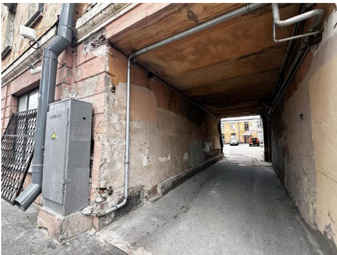
Фото 6. Сквозной арочный проезд. Фото с юга. Дата съемки: 29.06.2026 г. Автор съемки: Куваева Ю.П.
