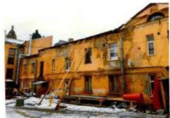
Ю-В фасад С-3 дворового крыла. Левая часть.
