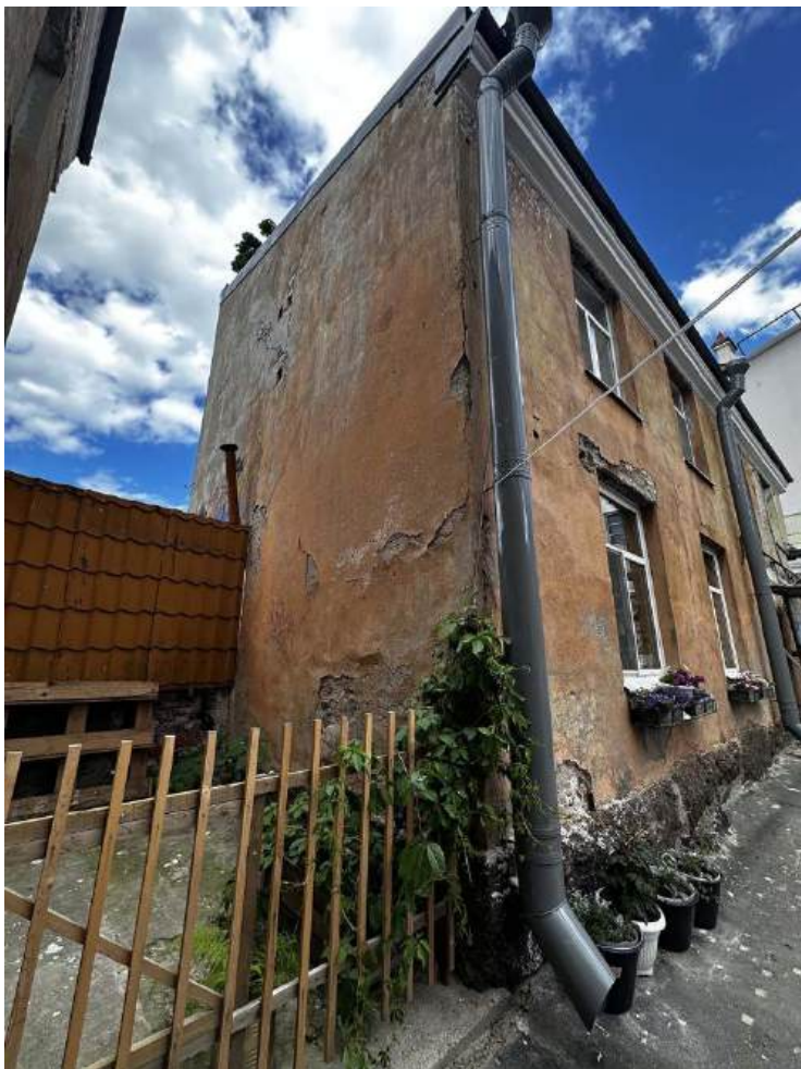
Фото 20. Общий вид северо-западного бокового фасада северо-восточного флигеля здания. Фото с запада. Дата съемки: 29.06.2026 г. Автор съемки: Куваева Ю.П.
