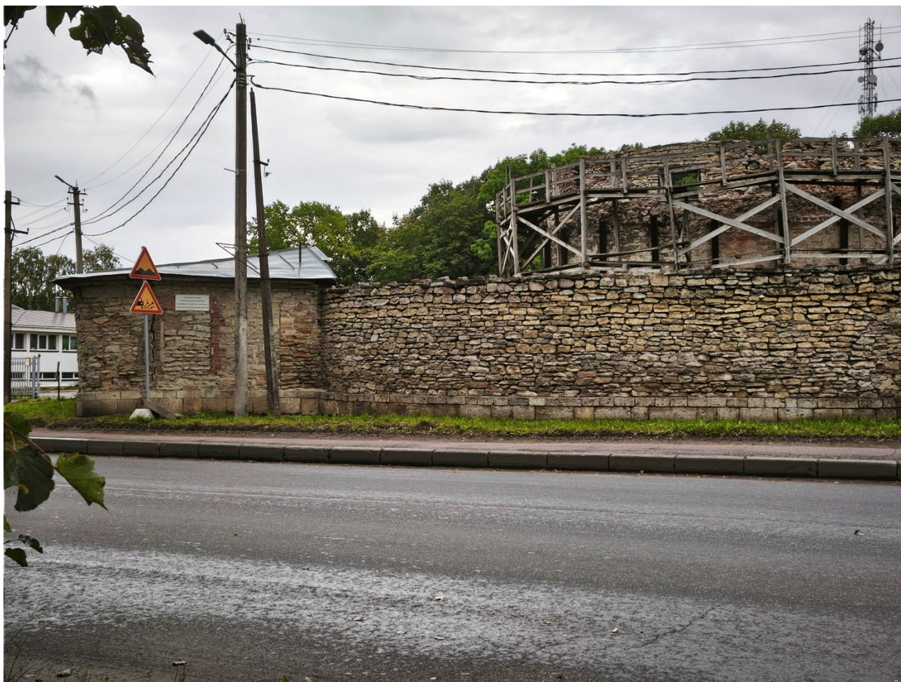
Фото 2. Вид проезжей части ул. Киевская напротив ОКН «Круглая Рига».
