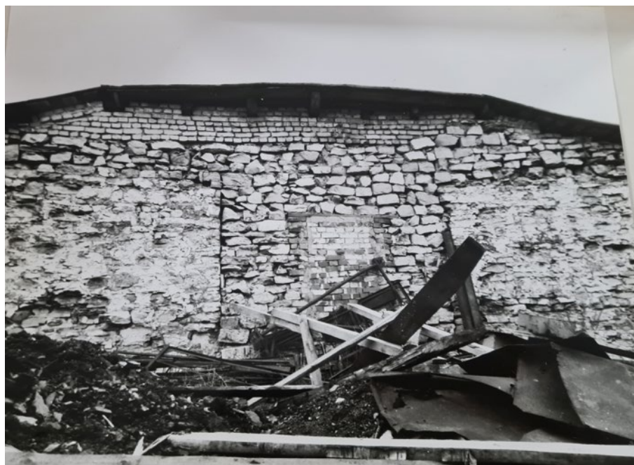
Рис. 84. Круглая рига. Фотофиксация 1988 года. Источник: Архив комитета по сохранению объектов культурного наследия Ленинградской области.
