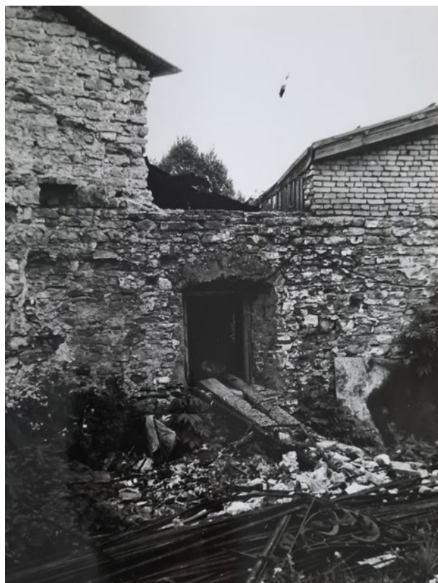
Рис. 87. Круглая рига. Фотофиксация 1988 года. Источник: Архив комитета по сохранению объектов культурного наследия Ленинградской области.
