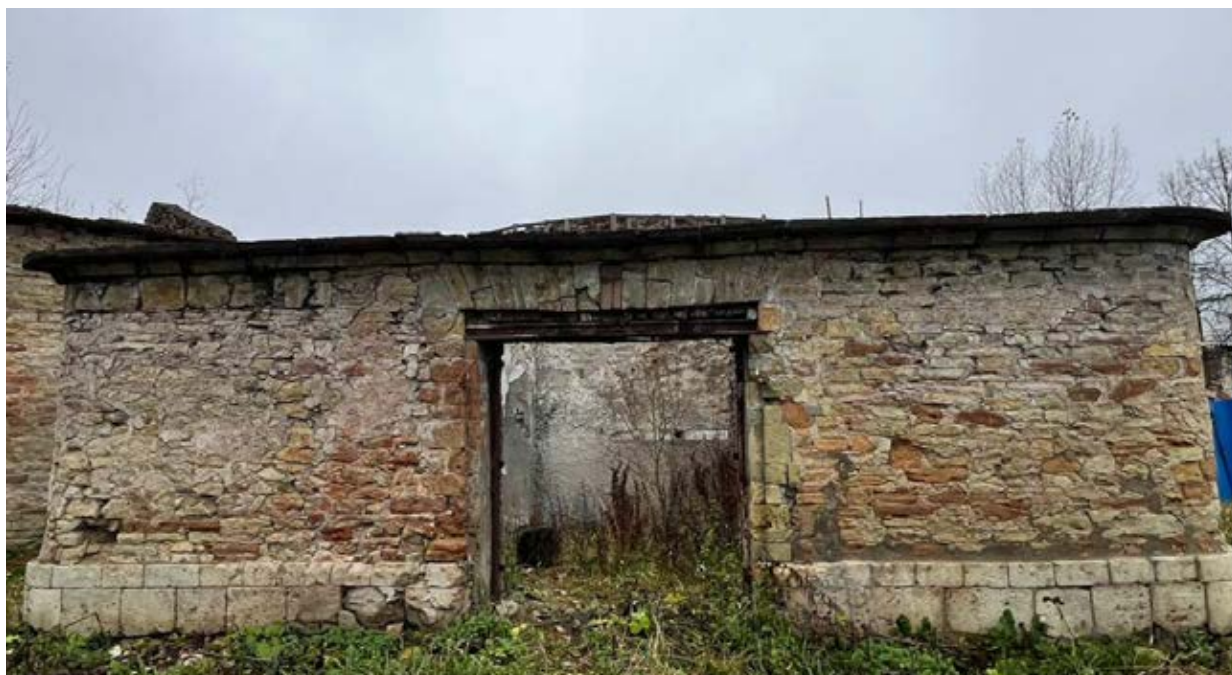
Фото Б.9 – Восточная пристройка
