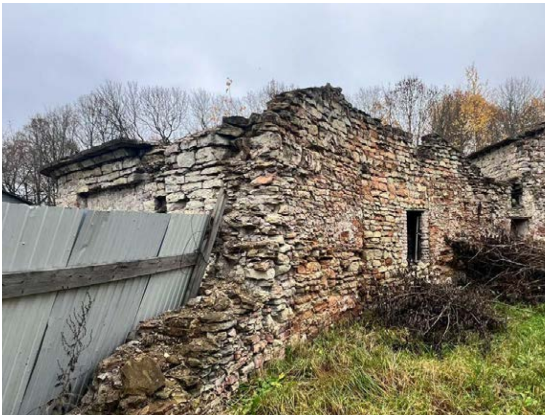
Фото Б.3 – Общий вид изнутри здания на восточную пристройку
