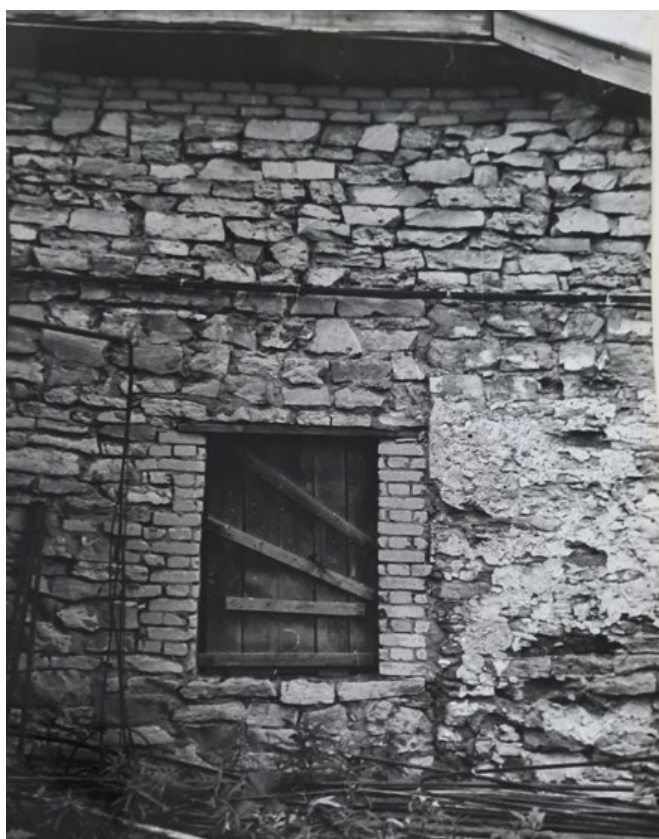
Рис. 85. Круглая рига. Фотофиксация 1988 года. Источник: Архив комитета по сохранению объектов культурного наследия Ленинградской области.
