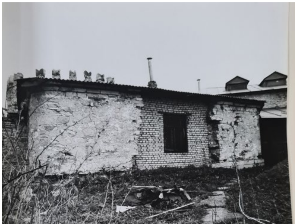
Рис. 66. Круглая рига. Фотофиксация 1988 года. Источник: Архив комитета по сохранению объектов культурного наследия Ленинградской области.
