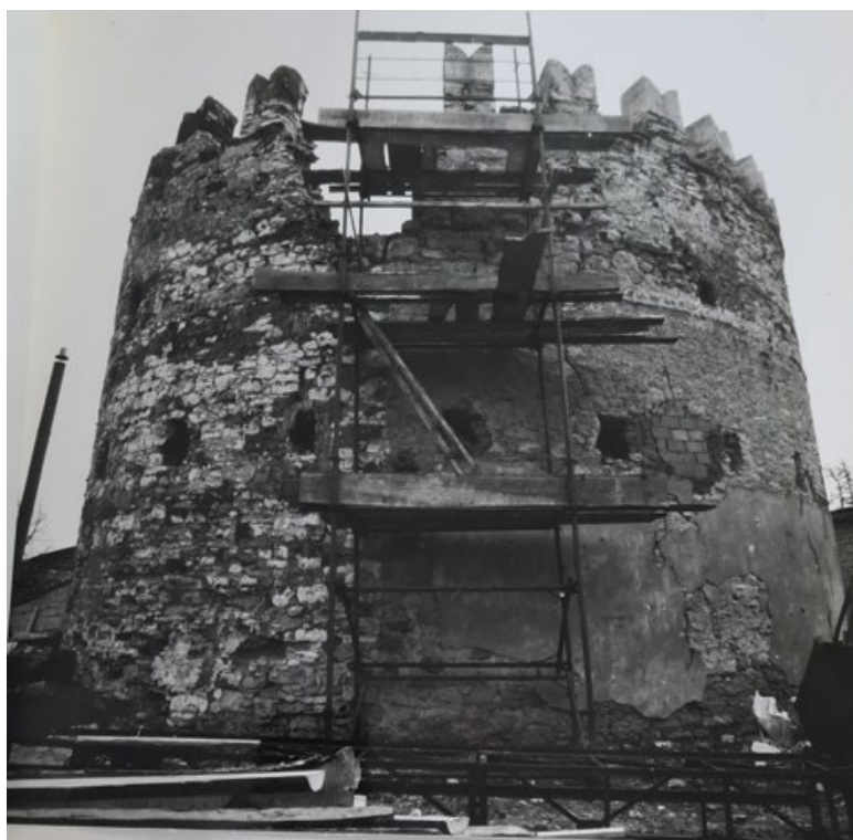
Рис. 89. Круглая рига. Фотофиксация 1988 года. Источник: Архив комитета по сохранению объектов культурного наследия Ленинградской области.
