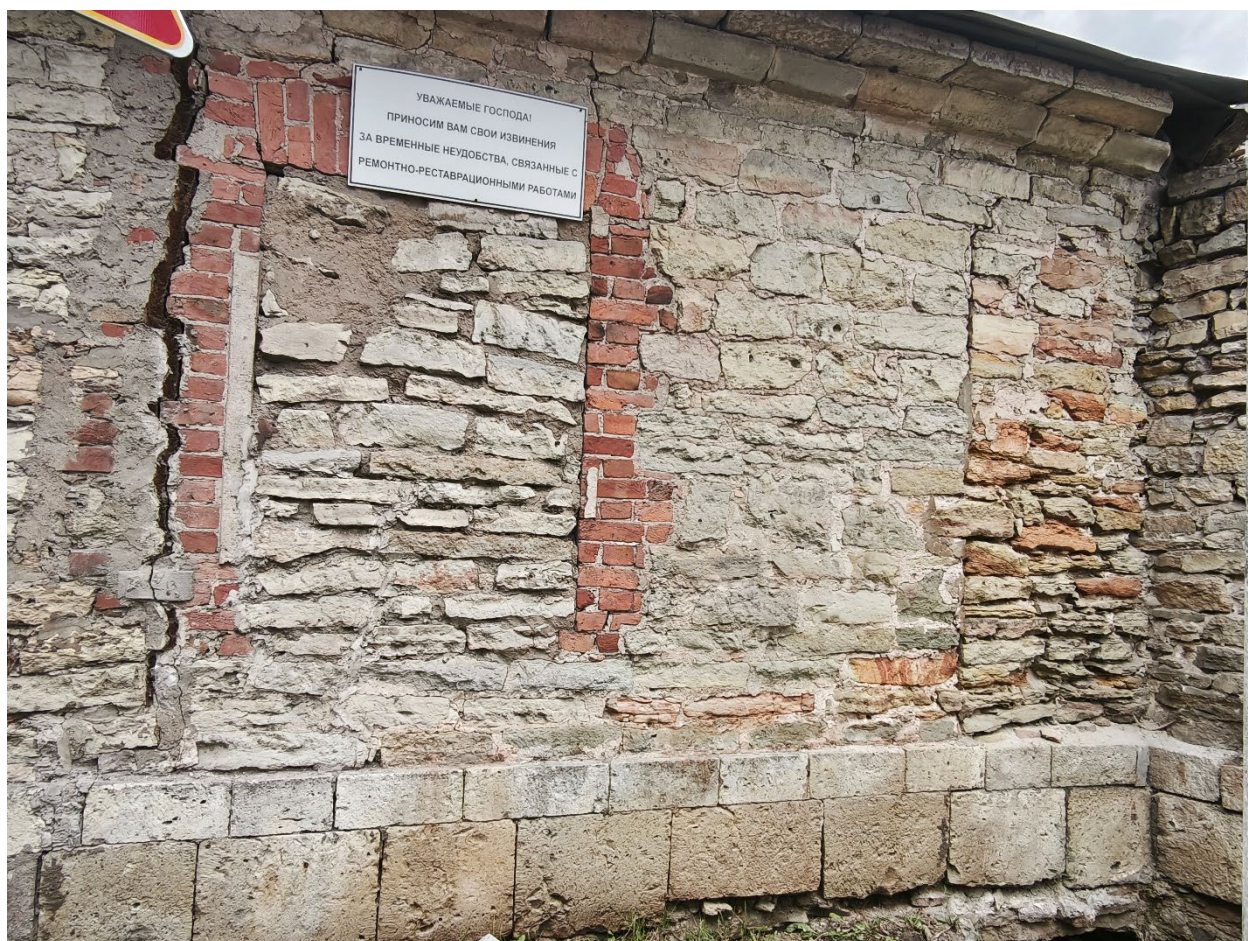
Фото 17. Фрагмент стены западного фасада ОКН «Старая Рига».
