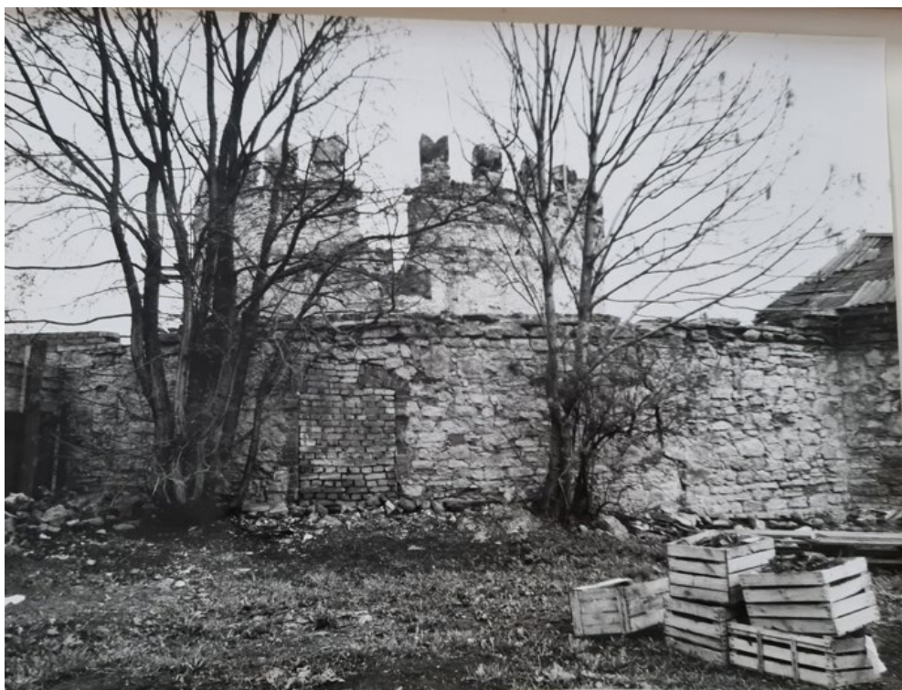
Рис. 63. Круглая рига. Фотофиксация 1988 года. Источник: Архив комитета по сохранению объектов культурного наследия Ленинградской области.
