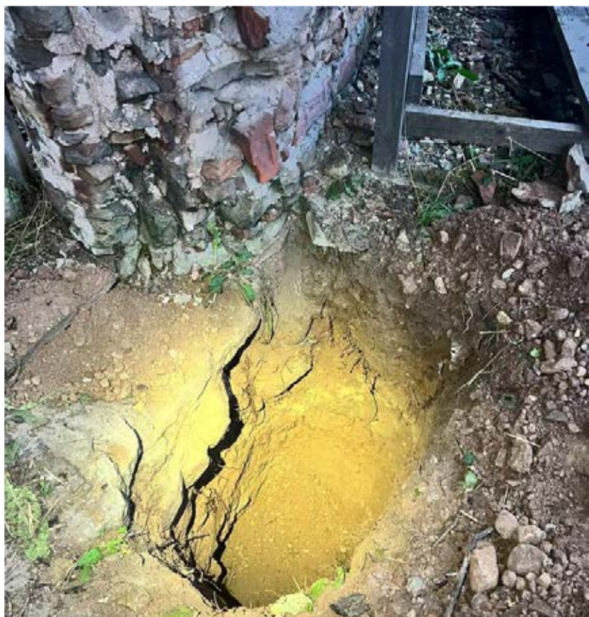
Фото Б.13 – Обицый вид шурфа
