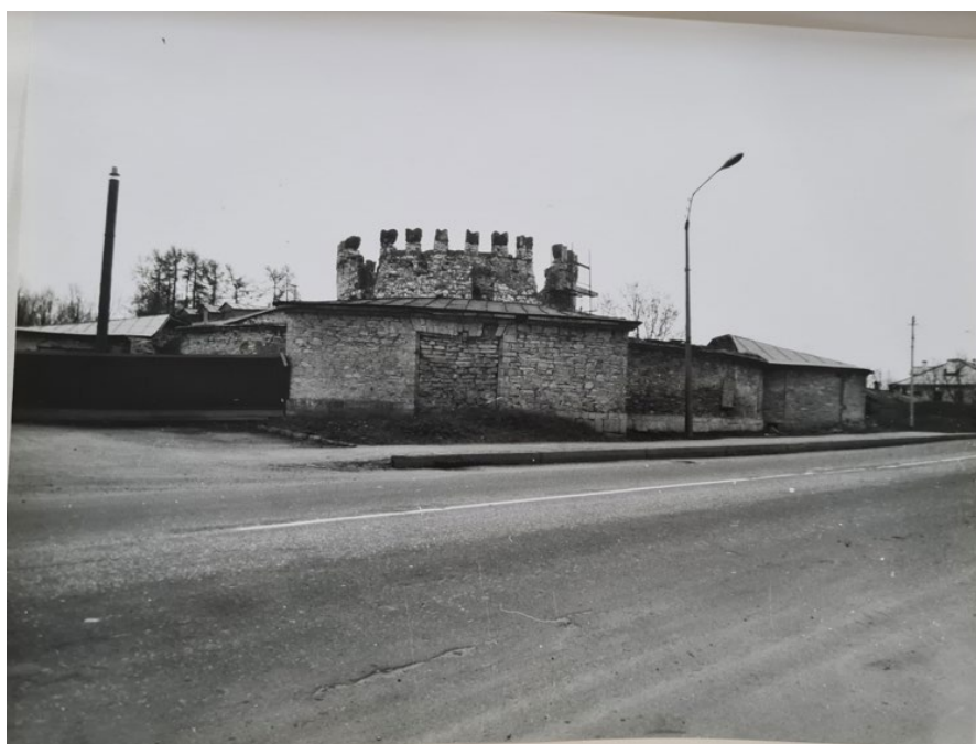
Рис. 62. Круглая рига. Фотофиксация 1988 года. Источник: Архив комитета по сохранению объектов культурного наследия Ленинградской области.
