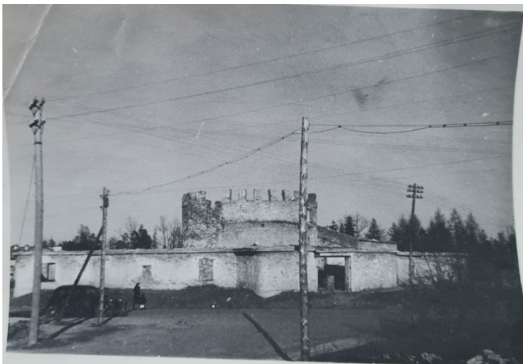
Рис. 44. Круглая рига. Фотофиксация 1948 года. Источник: Архив комитета по сохранению объектов культурного наследия Ленинградской области.
