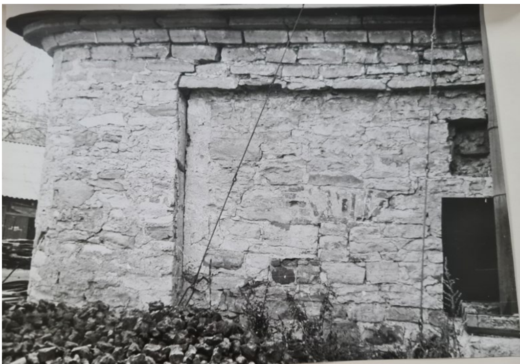
Рис. 74. Круглая рига. Фотофиксация 1988 года. Источник: Архив комитета по сохранению объектов культурного наследия Ленинградской области.
