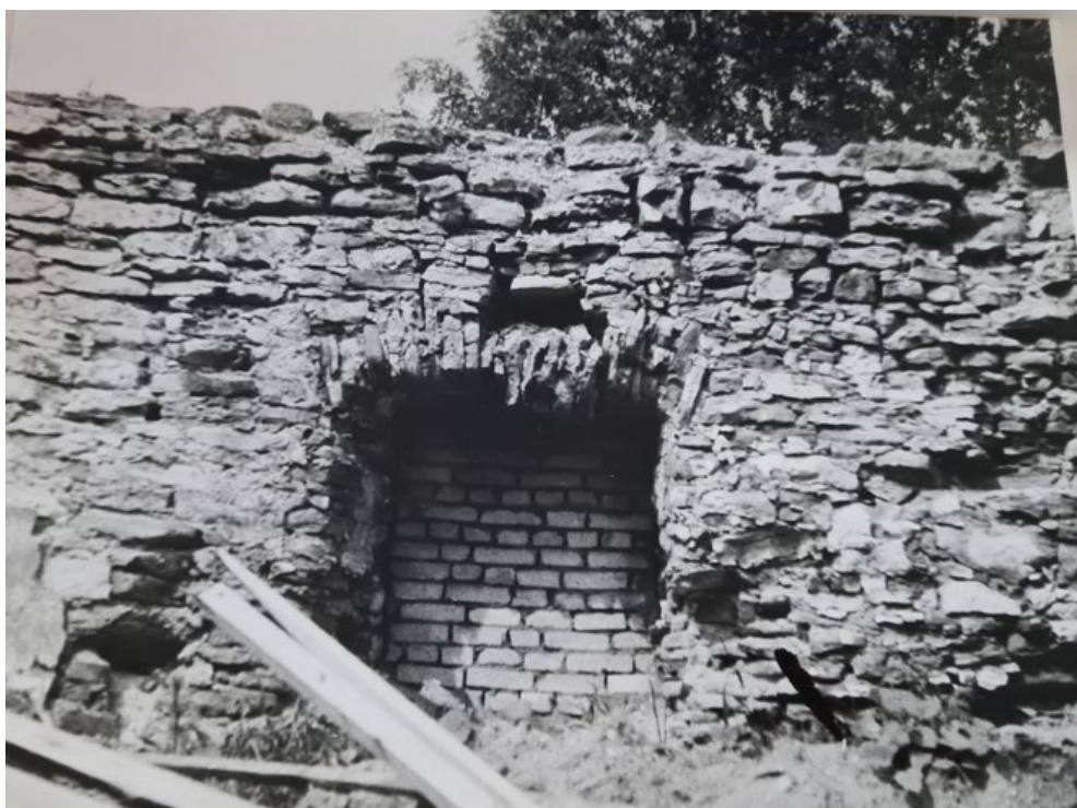
Рис. 83. Круглая рига. Фотофиксация 1988 года. Источник: Архив комитета по сохранению объектов культурного наследия Ленинградской области.
