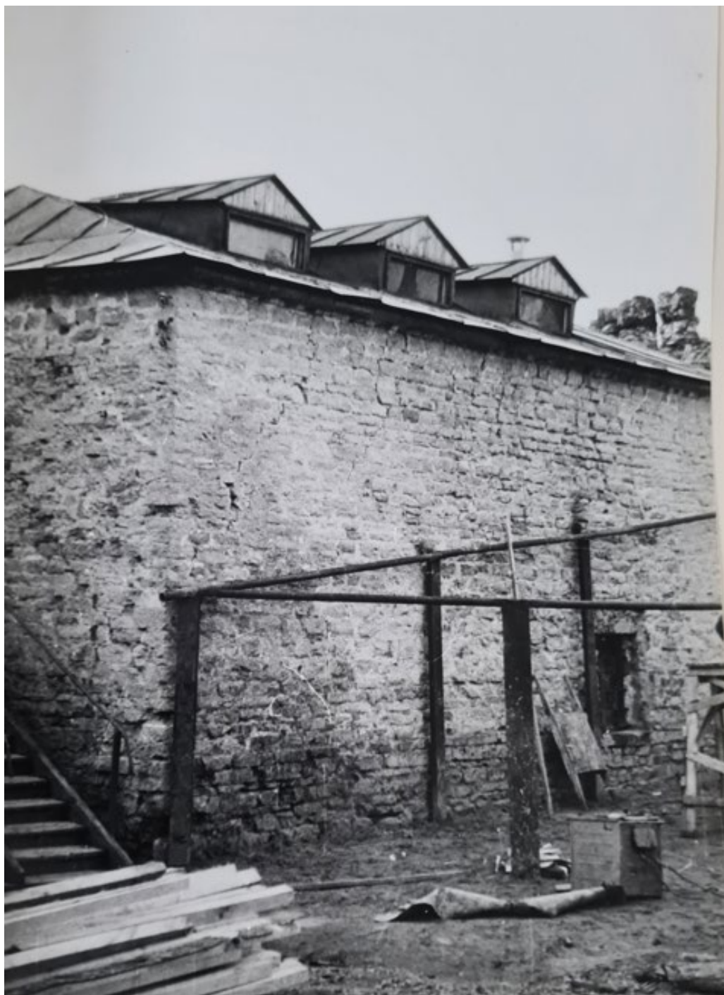
Рис. 75. Круглая рига. Фотофиксация 1988 года. Источник: Архив комитета по сохранению объектов культурного наследия Ленинградской области.
