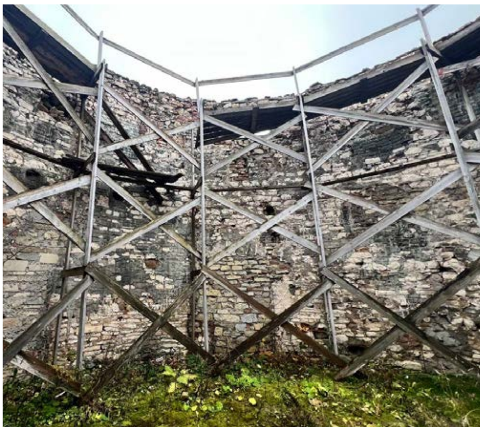
Фото Б.1 – Вид изнутри на внутреннюю стену
