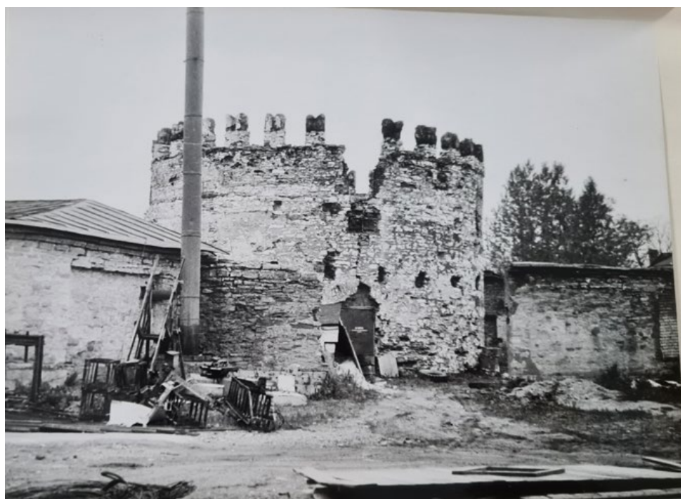
Рис. 64. Круглая рига. Фотофиксация 1988 года. Источник: Архив комитета по сохранению объектов культурного наследия Ленинградской области.
