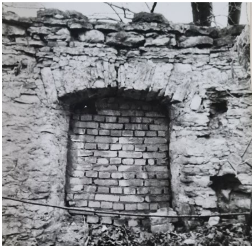
Рис. 80. Круглая рига. Фотофиксация 1988 года. Источник: Архив комитета по сохранению объектов культурного наследия Ленинградской области.
