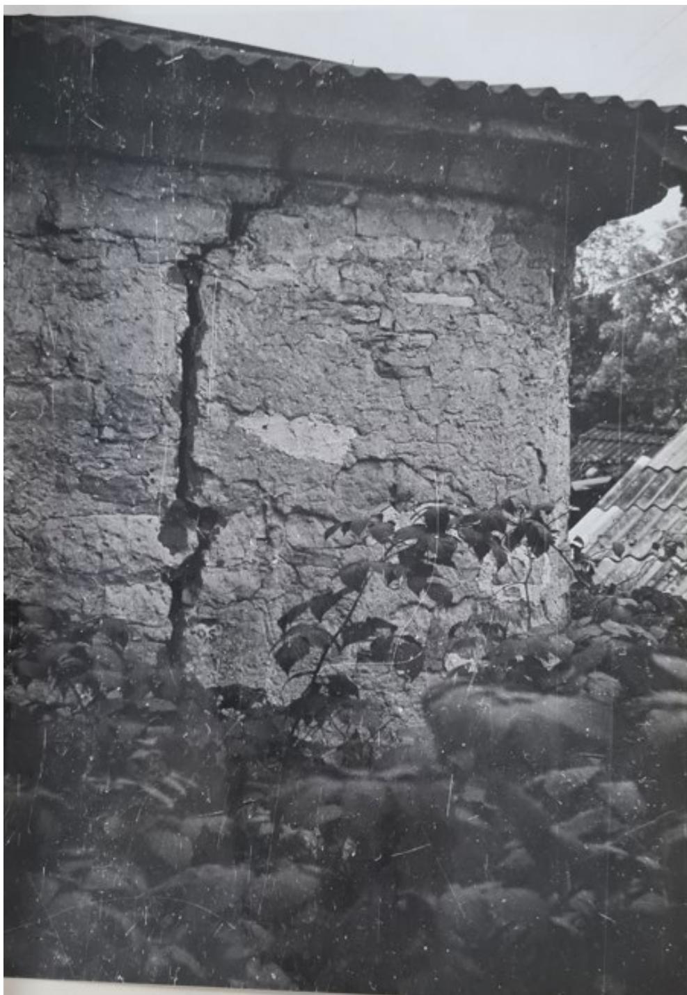
Рис. 68. Круглая рига. Фотофиксация 1988 года. Источник: Архив комитета по сохранению объектов культурного наследия Ленинградской области.
