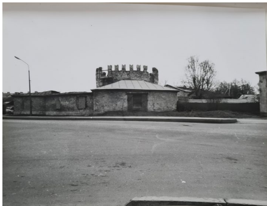
Рис. 61. Круглая рига. Фотофиксация 1988 года. Источник: Архив комитета по сохранению объектов культурного наследия Ленинградской области.
