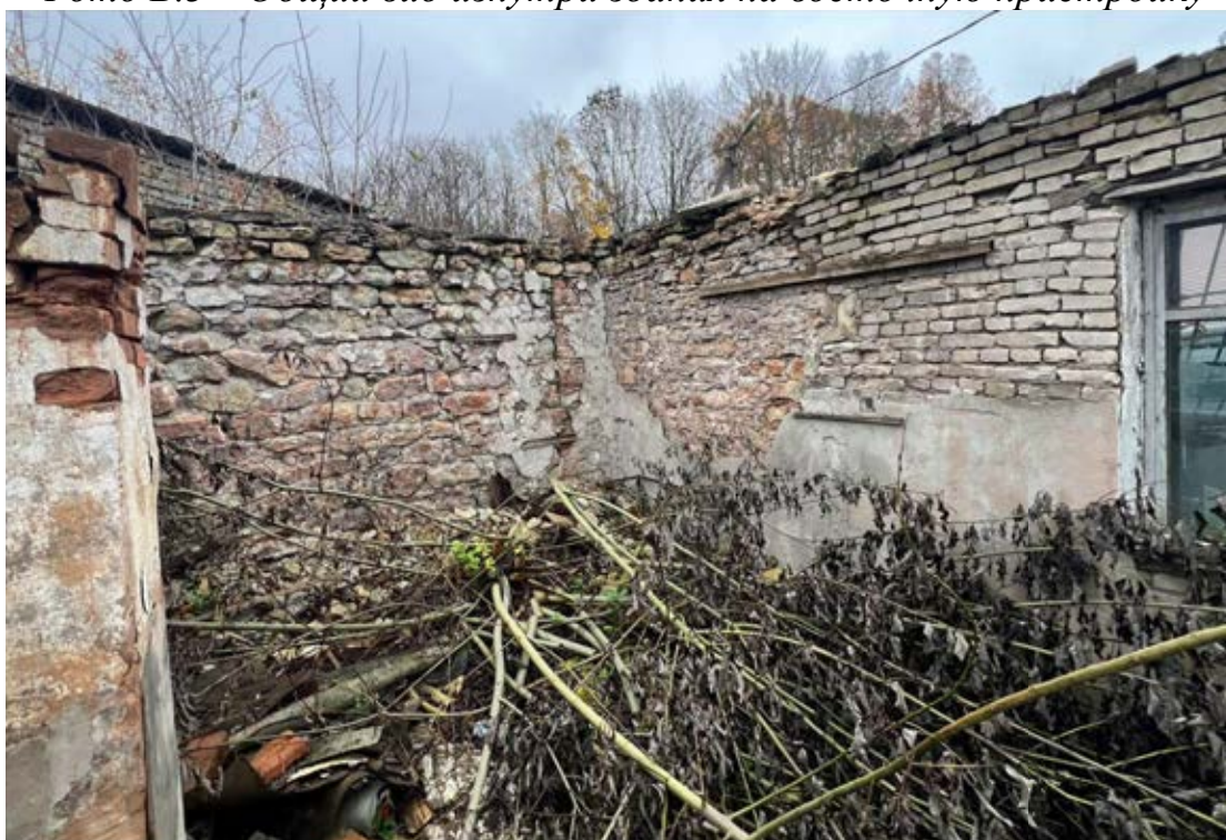
Фото Б.4 – Общий вид изнутри здания на южную пристройку
