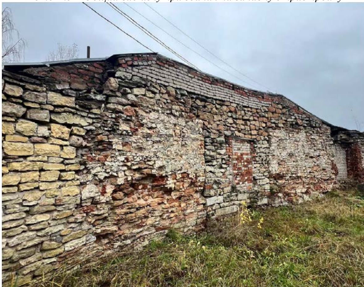
Фото Б.6 – Общий вид изнутри здания на северную пристройку
