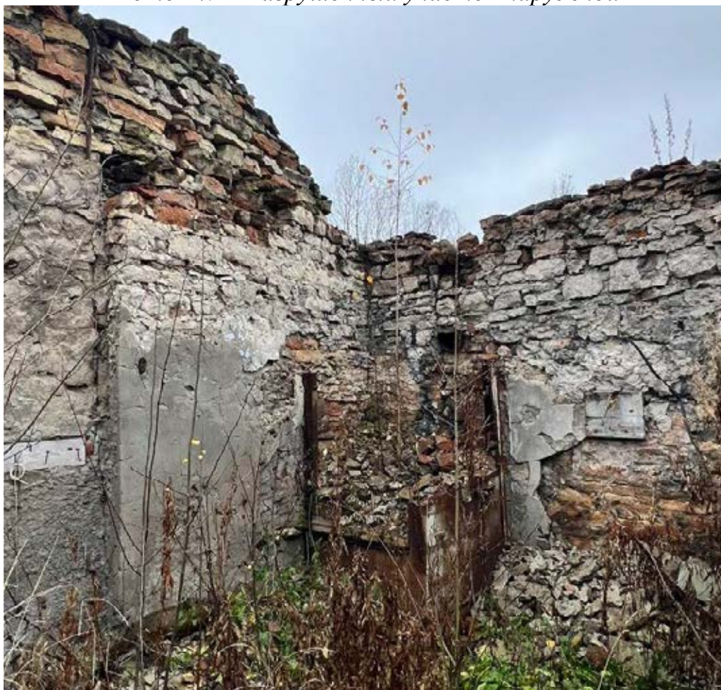
Фото Б.8 – Восточная пристройка
