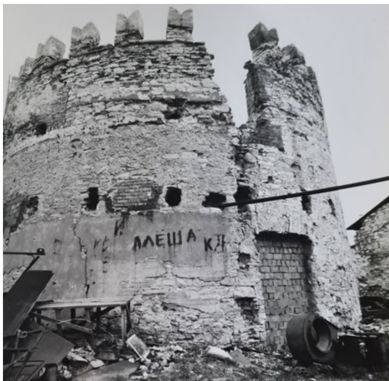
Рис. 88. Круглая рига. Фотофиксация 1988 года. Источник: Архив комитета по сохранению объектов культурного наследия Ленинградской области.
