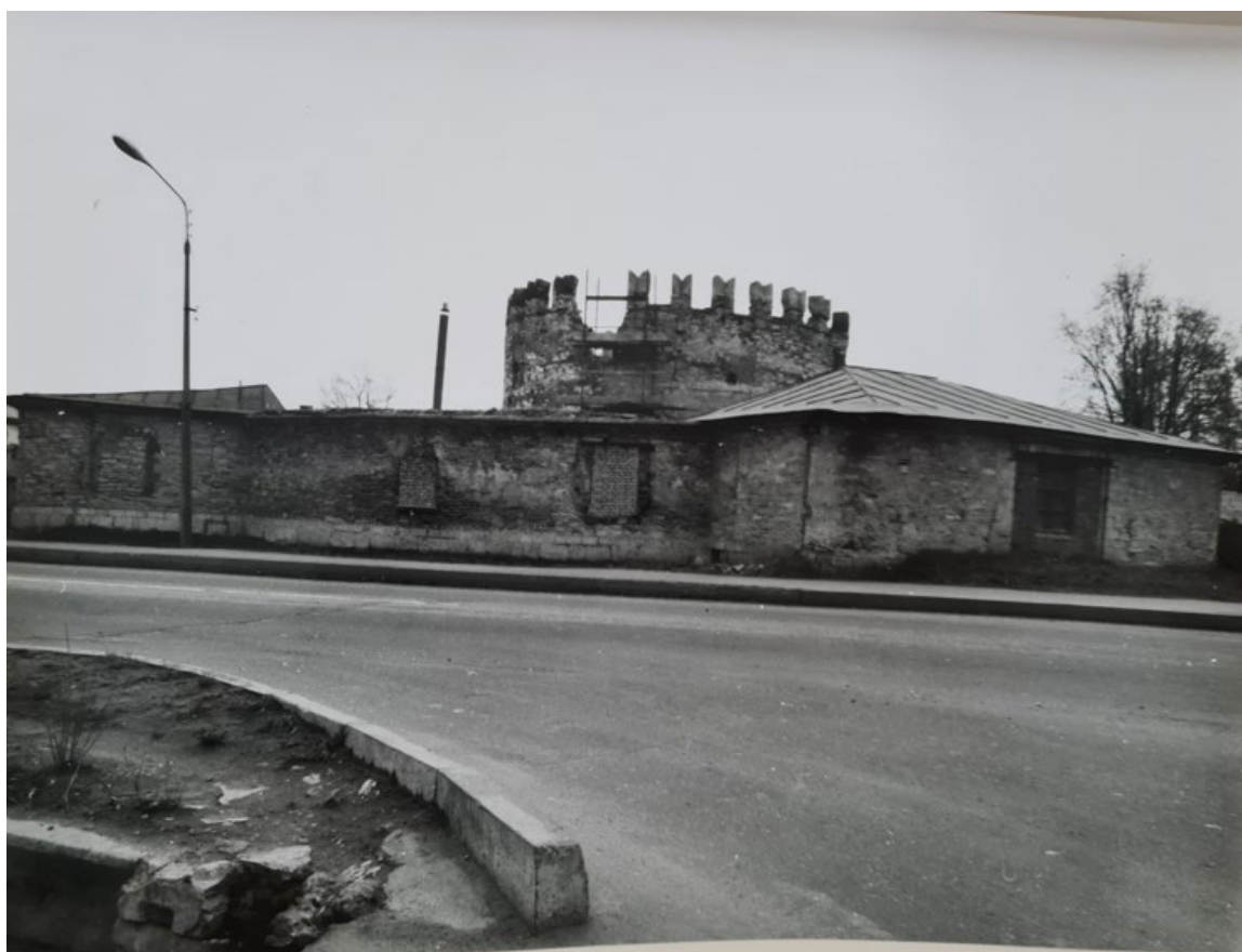
Рис. 60. Круглая рига. Фотофиксация 1988 года. Источник: Архив комитета по сохранению объектов культурного наследия Ленинградской области.
