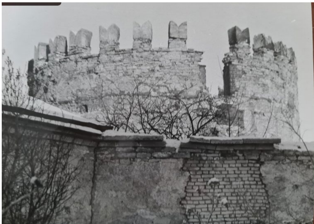
Рис. 51. Пересъемка с фотографии 1950-х годов, фрагмент фасада. Вид с юга. Источник: Архив комитета по сохранению объектов культурного наследия Ленинградской области.
