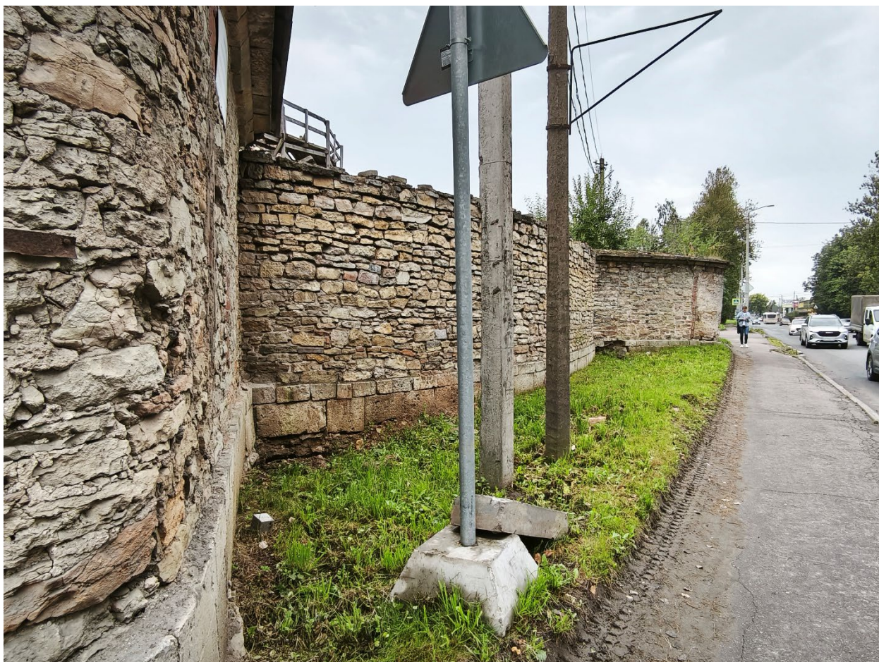
Фото 16. Западный фасад ОКН «Старая Рига».
