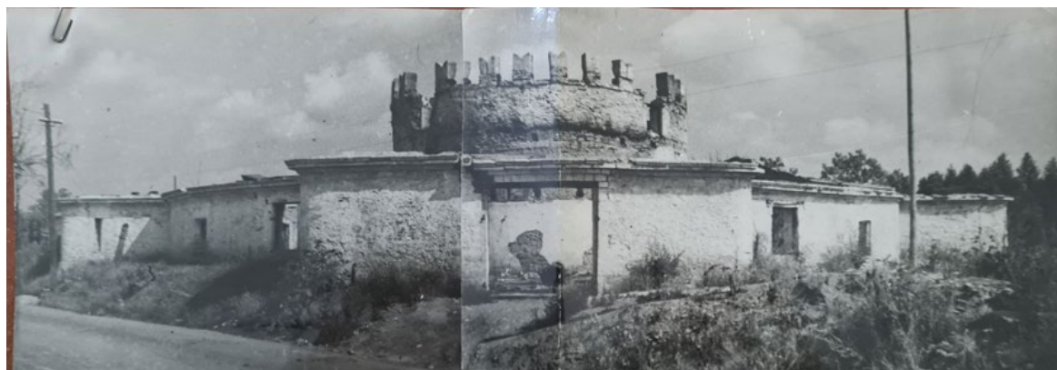
Рис. 43. Круглая рига. Фотофиксация 1948 года. Источник: Архив комитета по сохранению объектов культурного наследия Ленинградской области.
