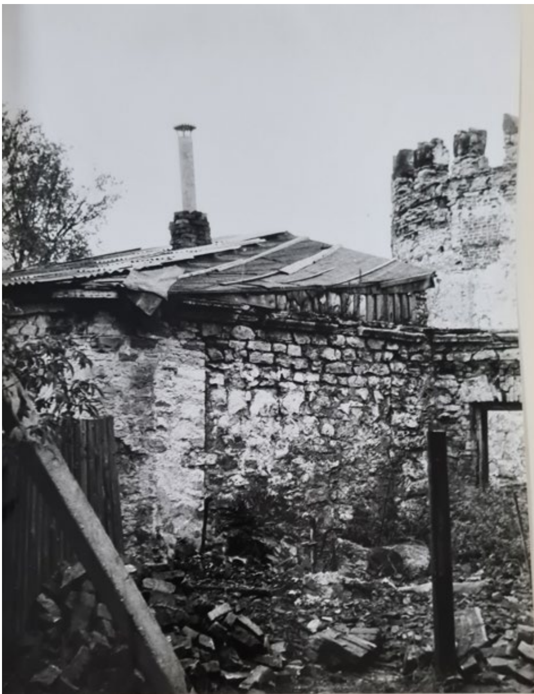
Рис. 65. Круглая рига. Фотофиксация 1988 года. Источник: Архив комитета по сохранению объектов культурного наследия Ленинградской области.
