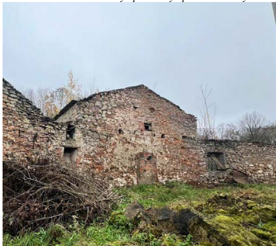
Фото Б.2 – Общий вид изнутри здания на юго-восточную пристройку
