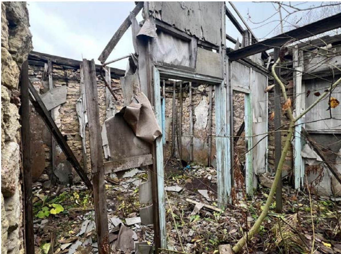
Фото Б.5 – Общий вид изнутри здания на западную пристройку
