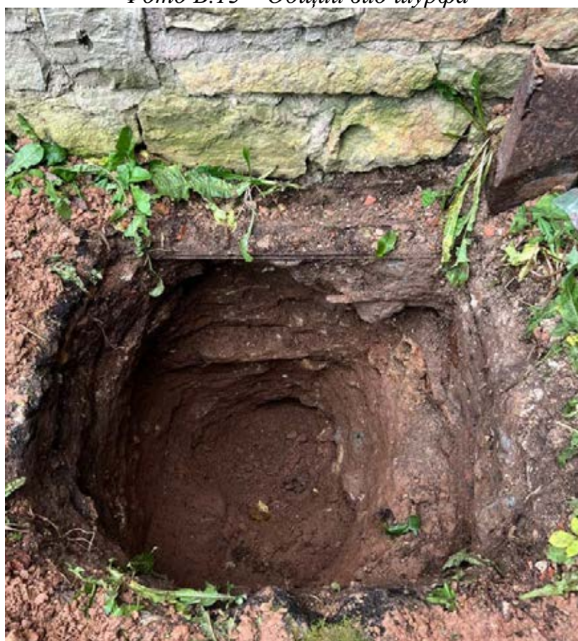
Фото Б.14 – Обицый вид шурфа
