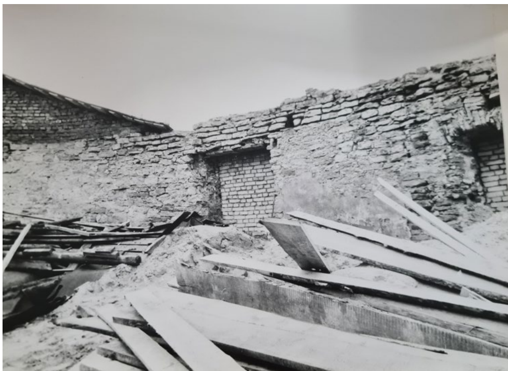
Рис. 82. Круглая рига. Фотофиксация 1988 года. Источник: Архив комитета по сохранению объектов культурного наследия Ленинградской области.
