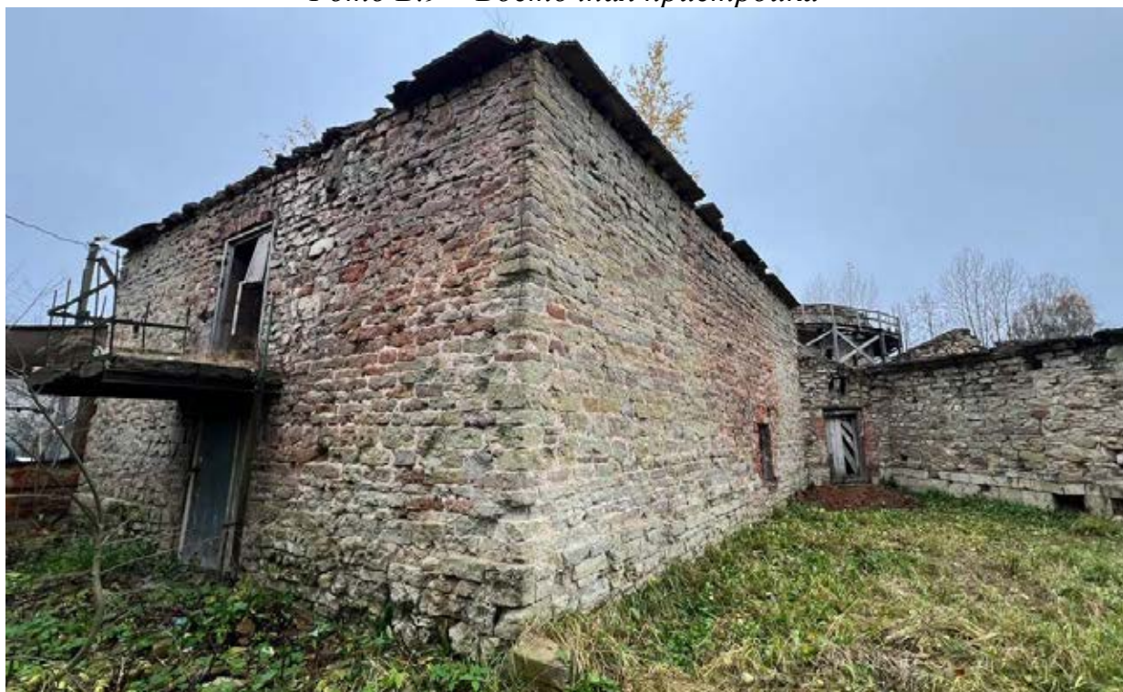
Фото Б.10 – Юго-восточная пристройка
