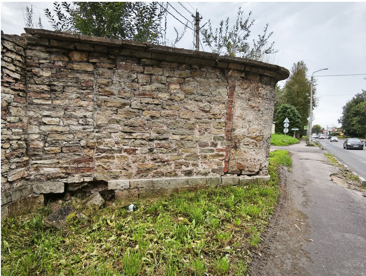
Фото 18. Фрагмент юго-западного фасада ОКН «Старая Рига», примыкающего к тротуару и проезжей части ул. Киевская.
