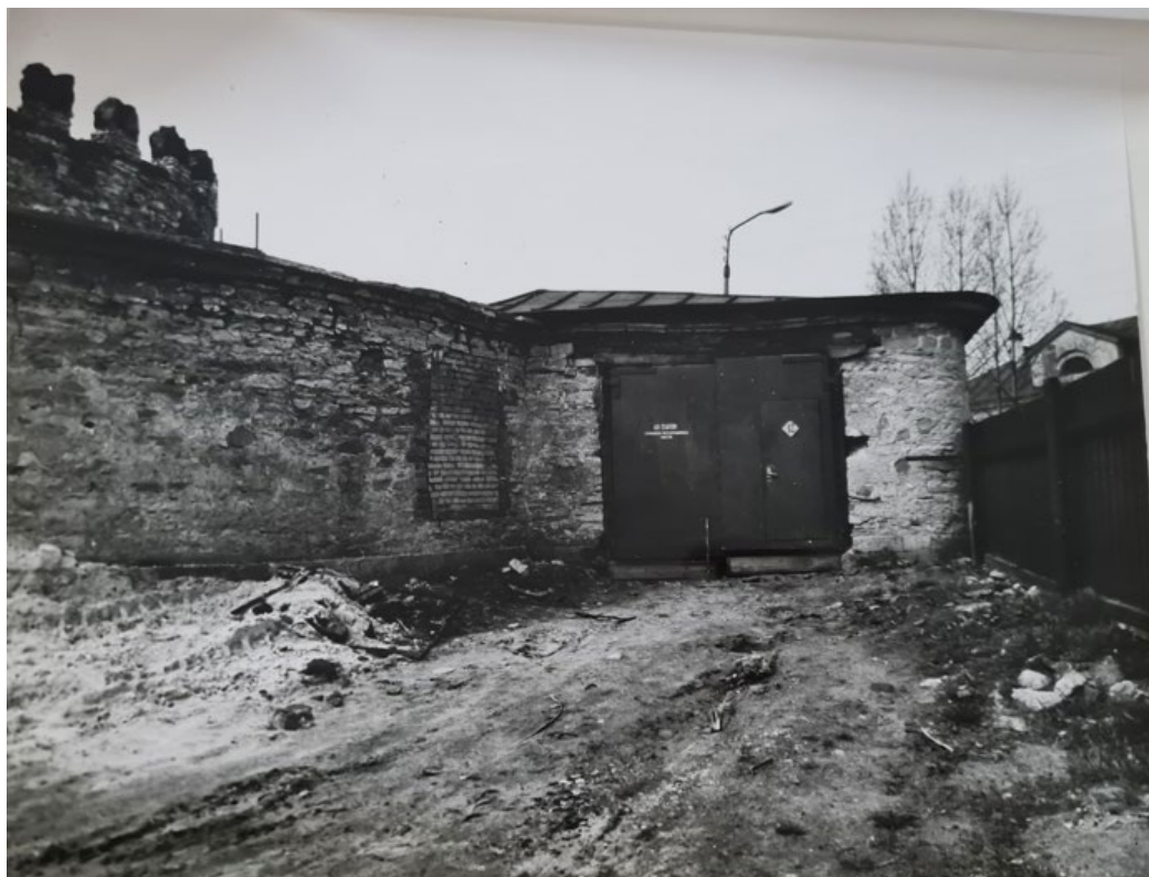
Рис. 73. Круглая рига. Фотофиксация 1988 года. Источник: Архив комитета по сохранению объектов культурного наследия Ленинградской области.
