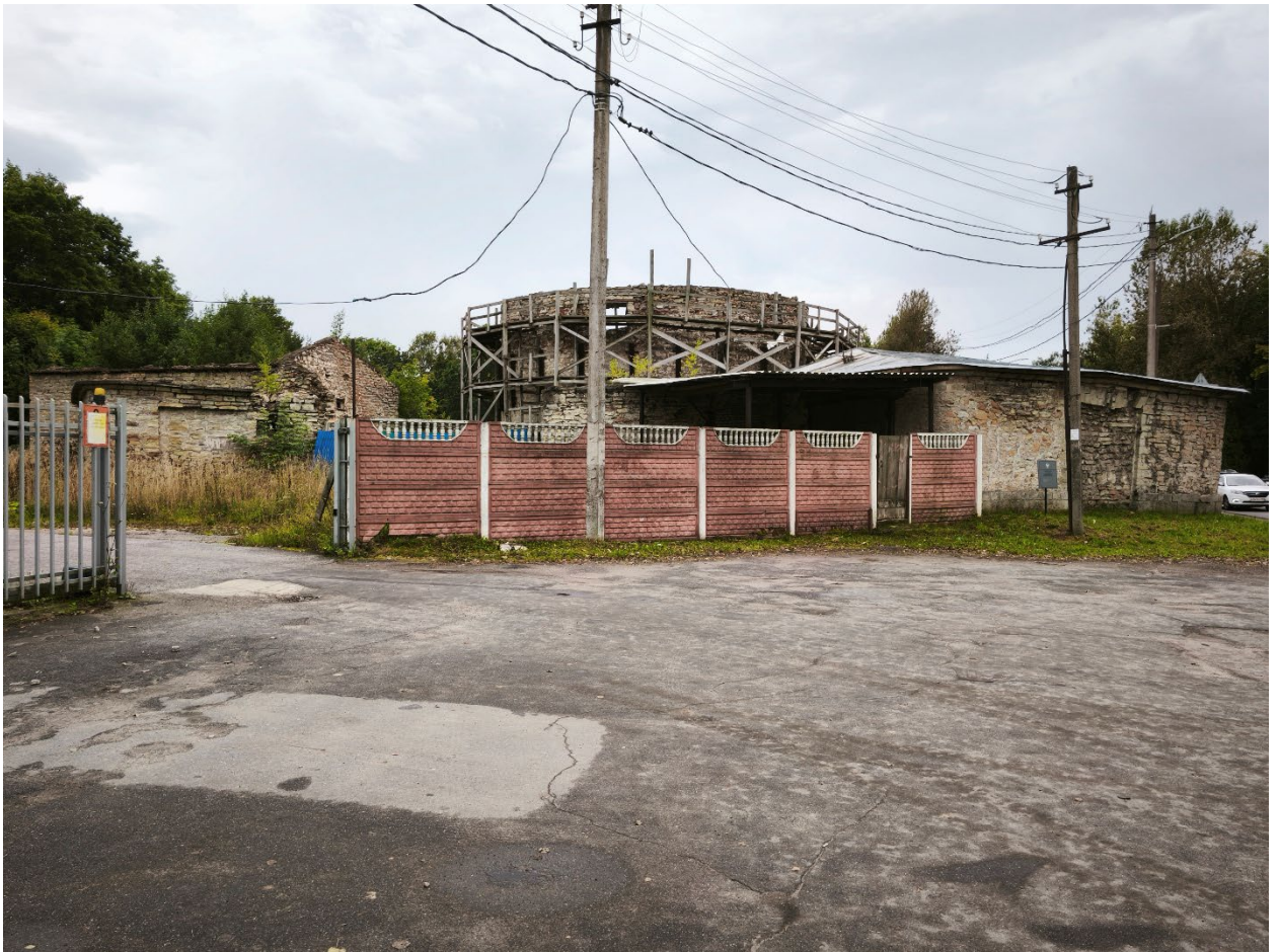
Фото 10. Общий вид на ОКН «Старая Рига» с севера.
