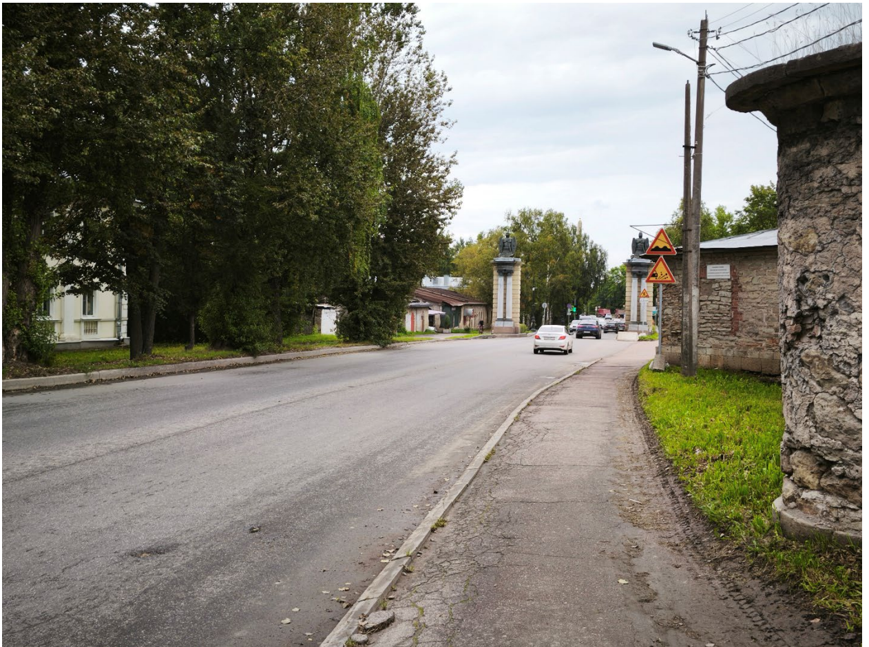
Фото 19. Вид тротуара и проезжей части ул. Киевская от юго-западного угла ОКН «Старая Рига».
