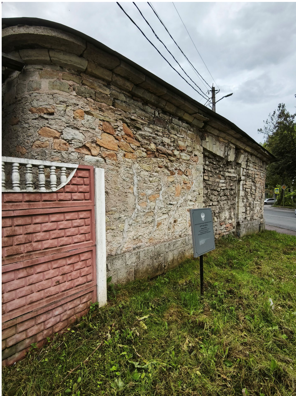
Фото 13. Северо-западный фасад ОКН «Старая Рига», выходящий к тротуару по ул. Киевская.
