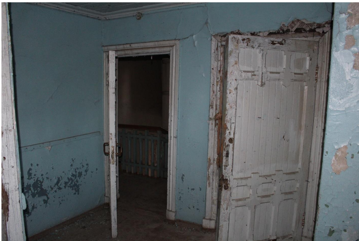
Фото 30. Вид на помещения 2-го этажа исследуемого объекта.
