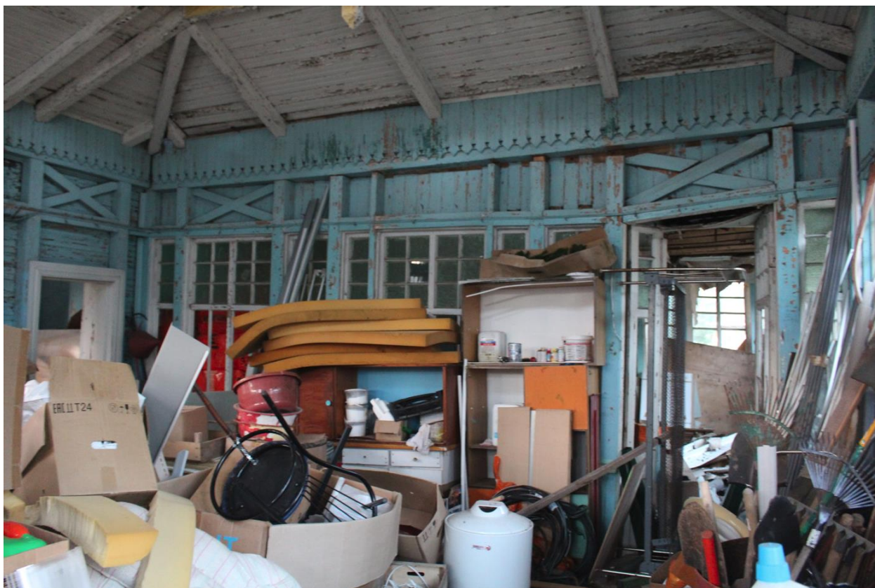
Фото 13. Вид на помещения 1-го этажа исследуемого объекта.
