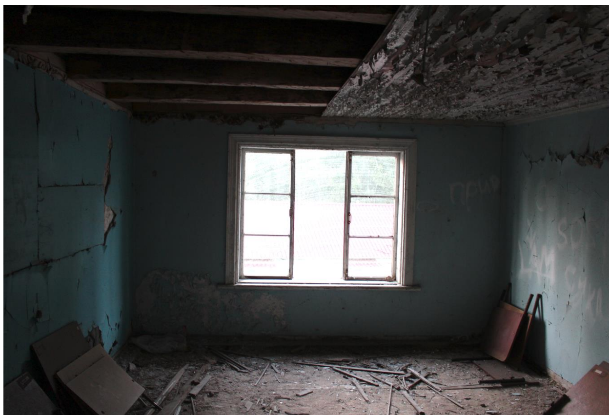
Фото 31. Вид на помещения 2-го этажа исследуемого объекта.
