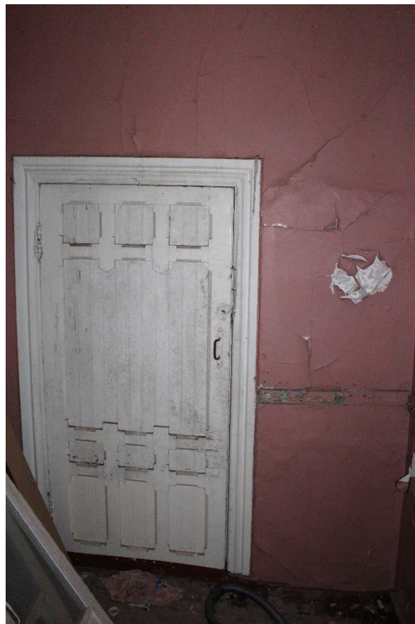
Фото 22. Вид на помещения 1-го этажа исследуемого объекта.
