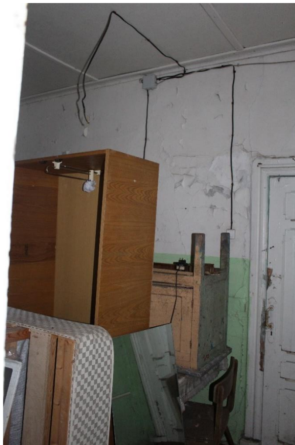
Фото 25. Вид на помещения 1-го этажа исследуемого объекта.
