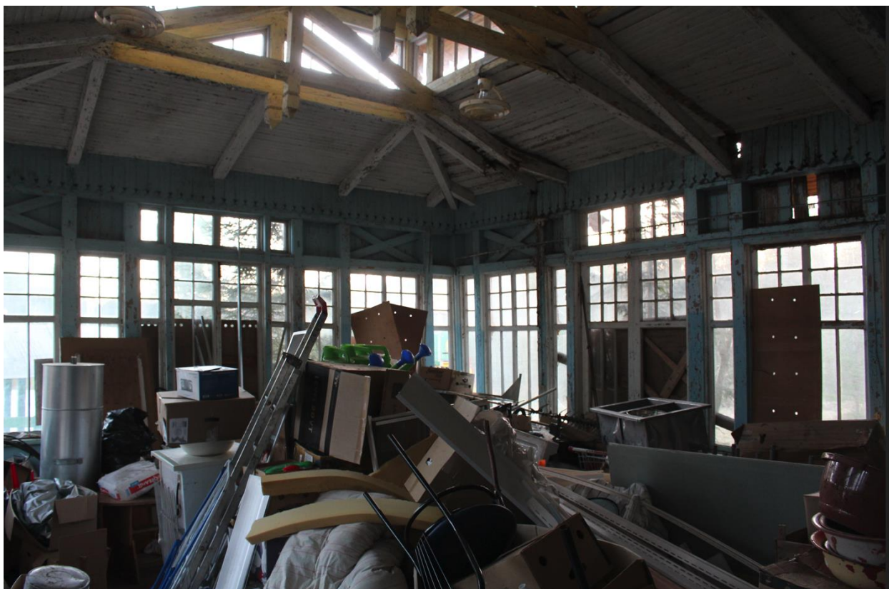
Фото 15. Вид на помещения 1-го этажа исследуемого объекта.
