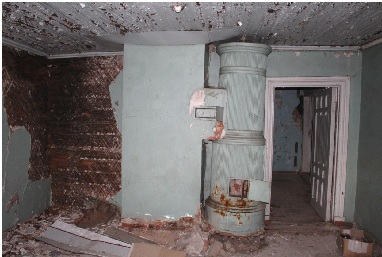
Фото 37. Вид на помещения 2-го этажа исследуемого объекта.
