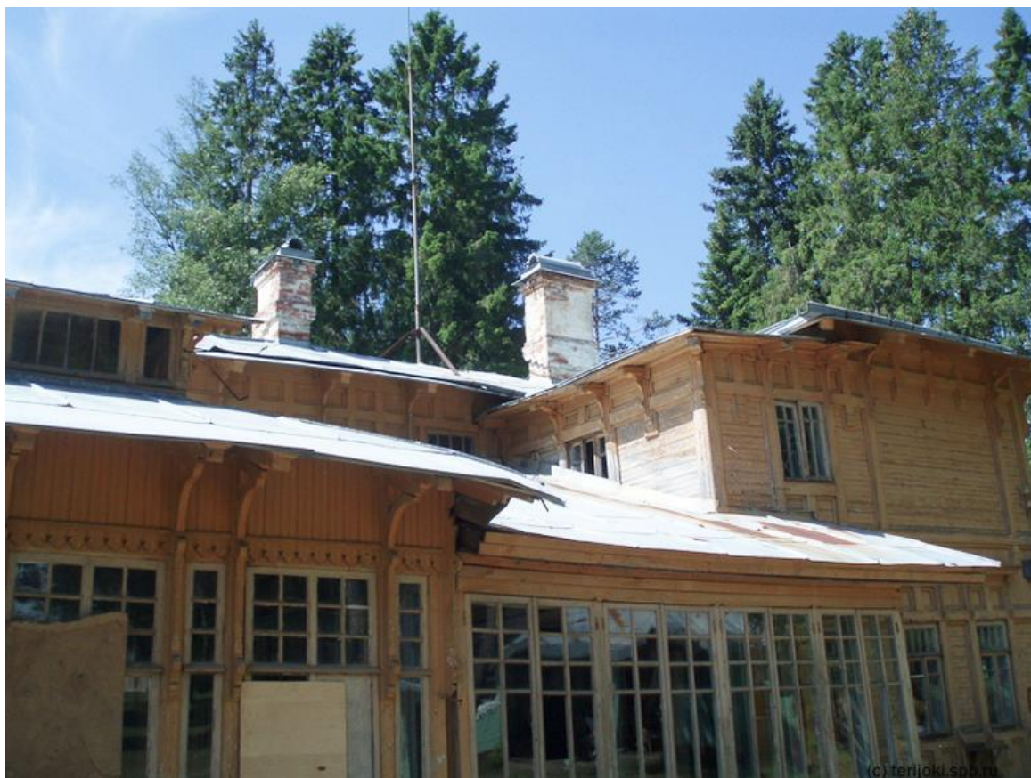
Илл. 11. Вид на исследуемый объект. Дата: 2010 г. Источник: https://terijoki.spb.ru .
