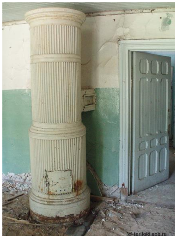
Илл. 24. Вид на исследуемый объект. Дата: 2010 г. Источник: https://terijoki.spb.ru .
