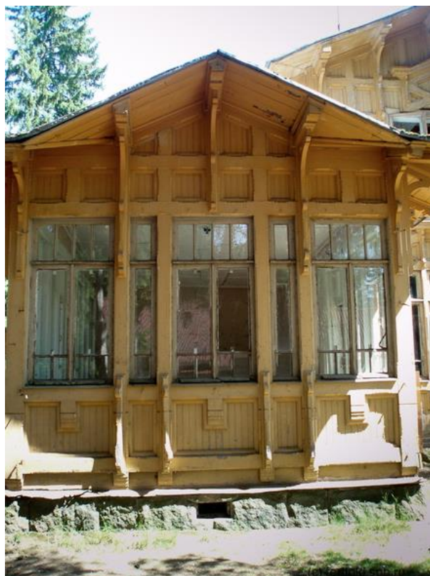
Илл. 17. Вид на исследуемый объект. Дата: 2010 г. Источник: https://terijoki.spb.ru .
