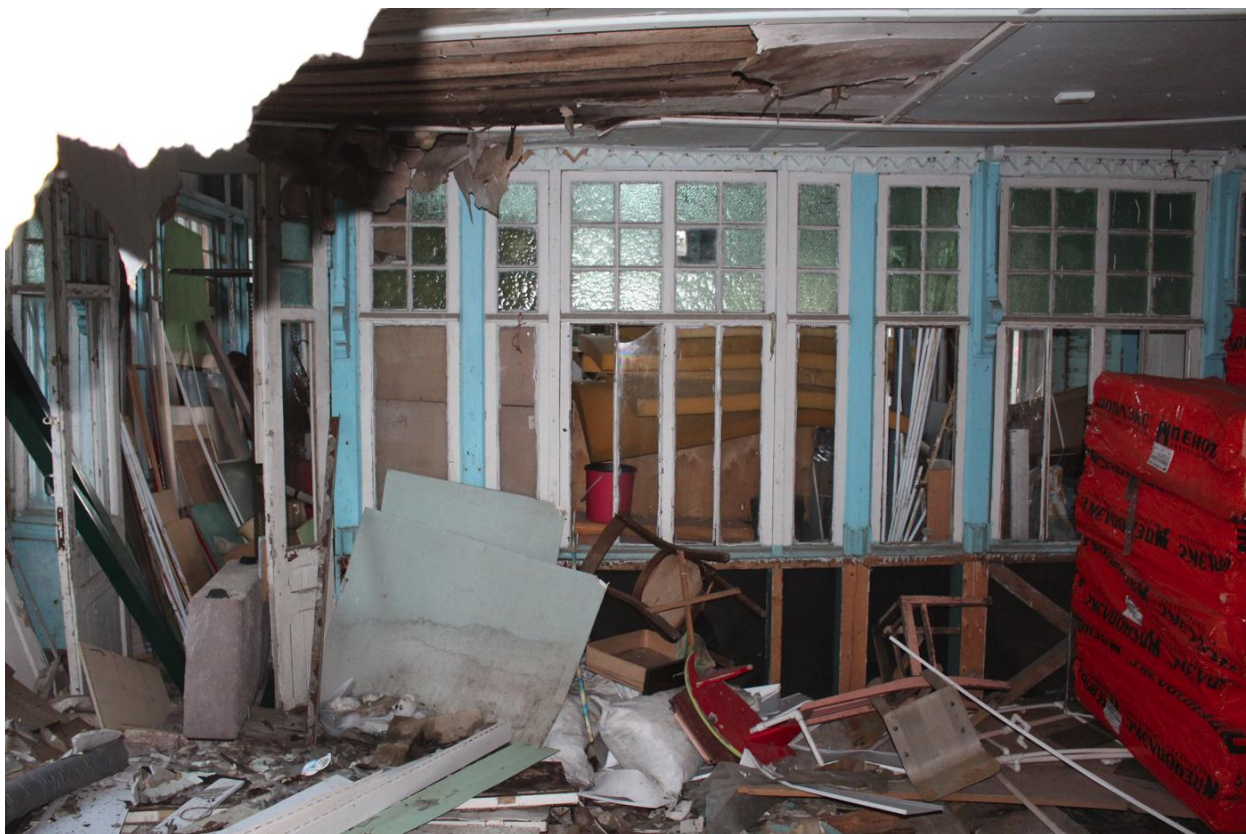
Фото 18. Вид на помещения 1-го этажа исследуемого объекта.
