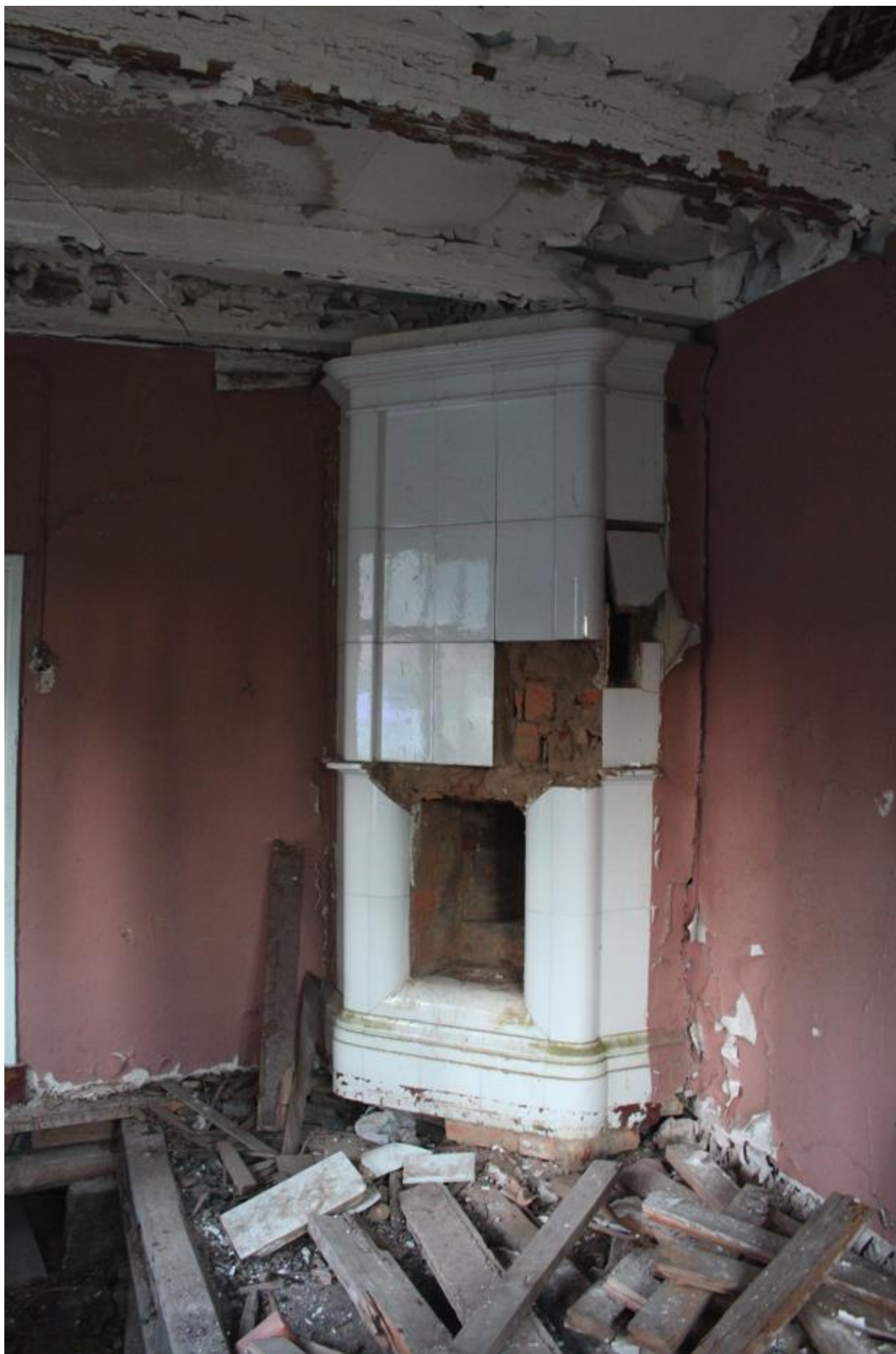
Фото 41. Вид на помещения 1-го этажа исследуемого объекта.
