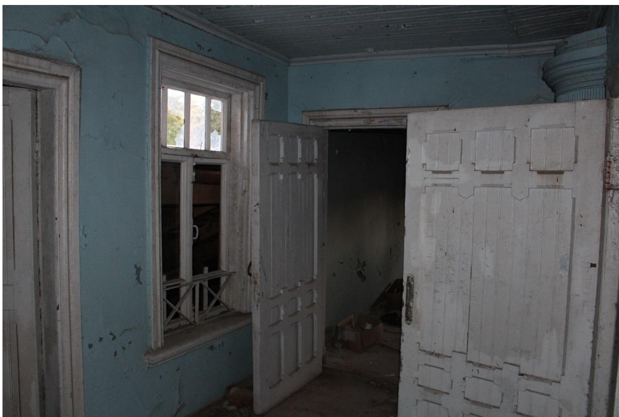
Фото 29. Вид на помещения 2-го этажа исследуемого объекта.
