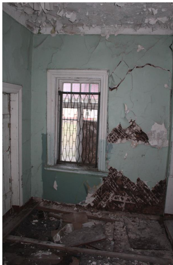
Фото 20. Вид на помещения 1-го этажа исследуемого объекта.
