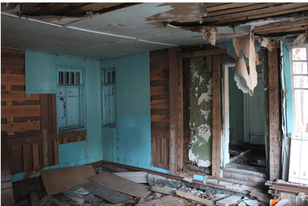
Фото 16. Вид на помещения 1-го этажа исследуемого объекта.
