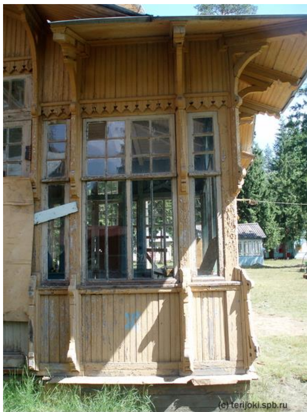
Илл. 16. Вид на исследуемый объект. Дата: 2010 г. Источник: https://terijoki.spb.ru .
