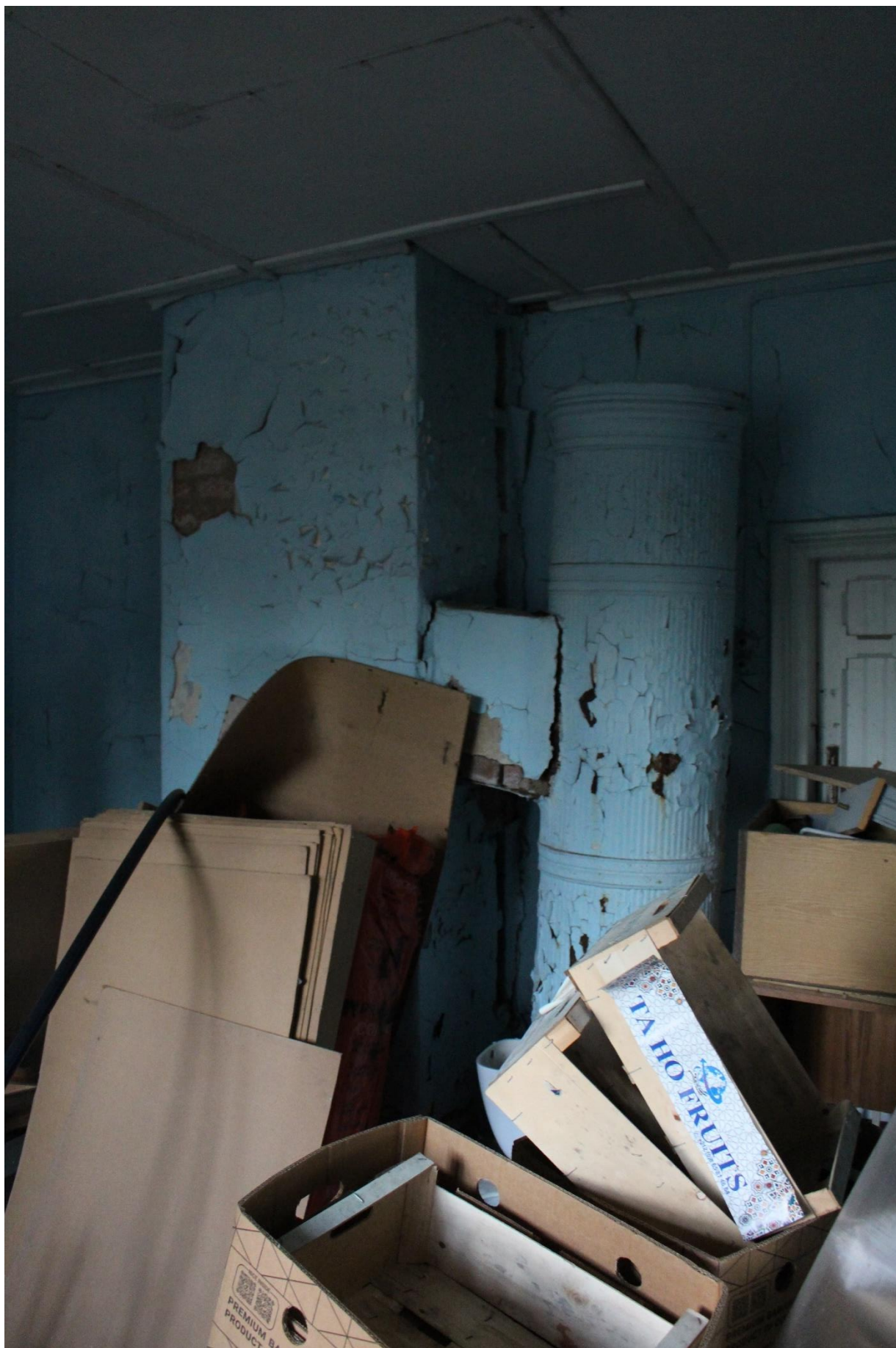
Фото 17. Вид на помещения 1-го этажа исследуемого объекта.
