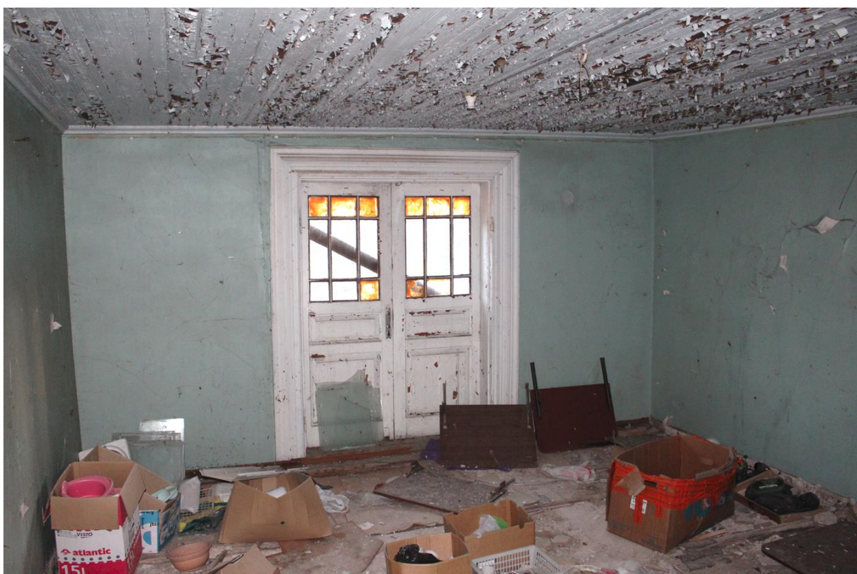
Фото 36. Вид на помещения 2-го этажа исследуемого объекта.
