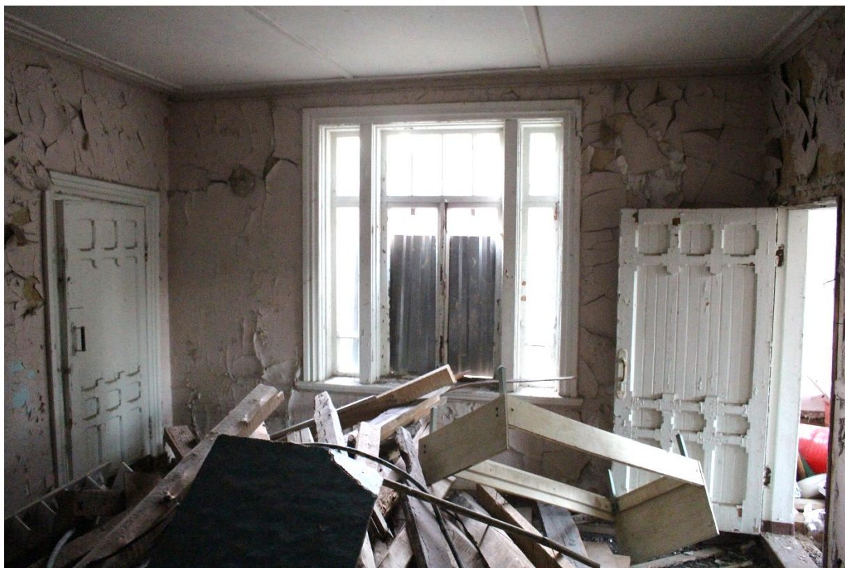
Фото 23. Вид на помещения 1-го этажа исследуемого объекта.
