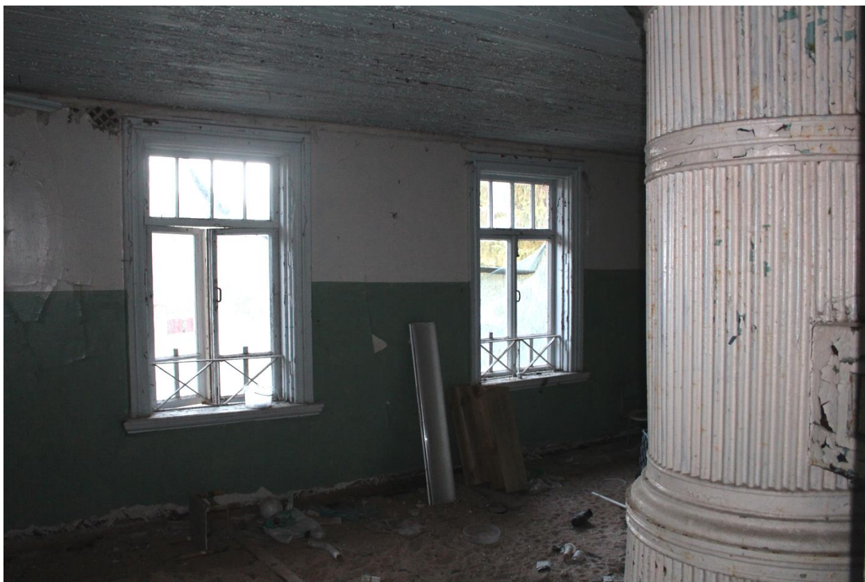
Фото 32. Вид на помещения 2-го этажа исследуемого объекта.
