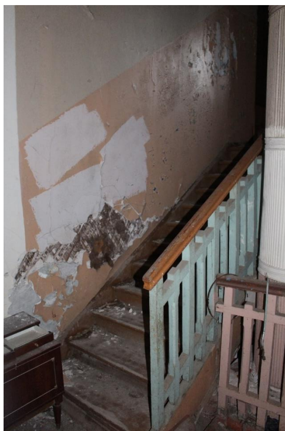
Фото 27. Вид на помещения 1-го этажа исследуемого объекта.
