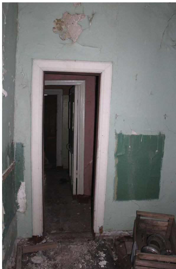
Фото 19. Вид на помещения 1-го этажа исследуемого объекта.
