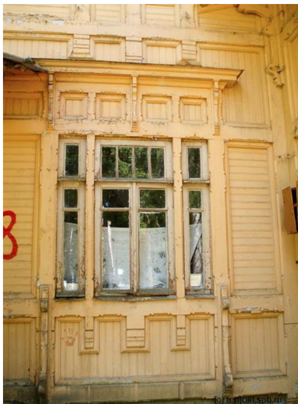
Илл. 19. Вид на исследуемый объект. Дата: 2010 г. Источник: https://terijoki.spb.ru .
