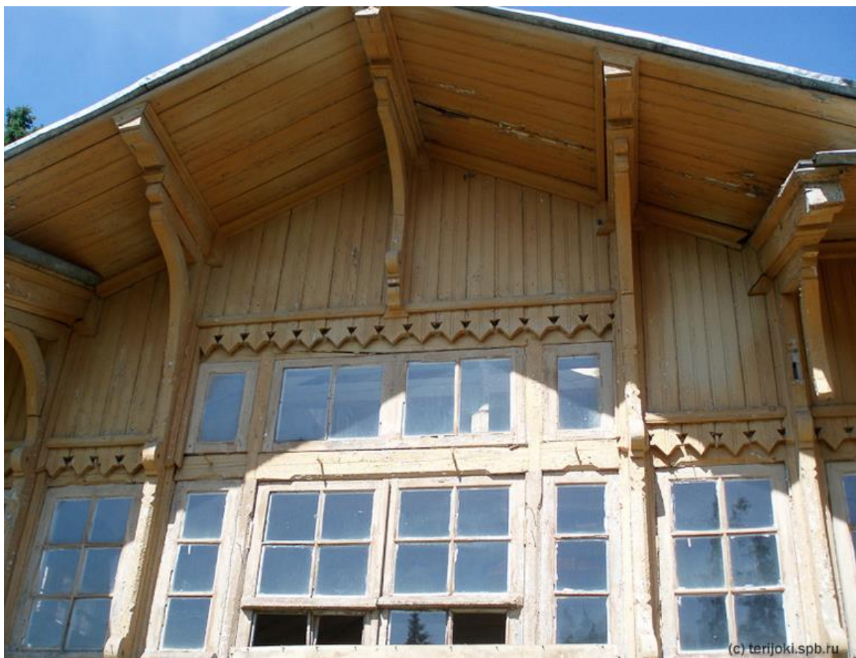
Илл. 15. Вид на исследуемый объект. Дата: 2010 г. Источник: https://terijoki.spb.ru .
