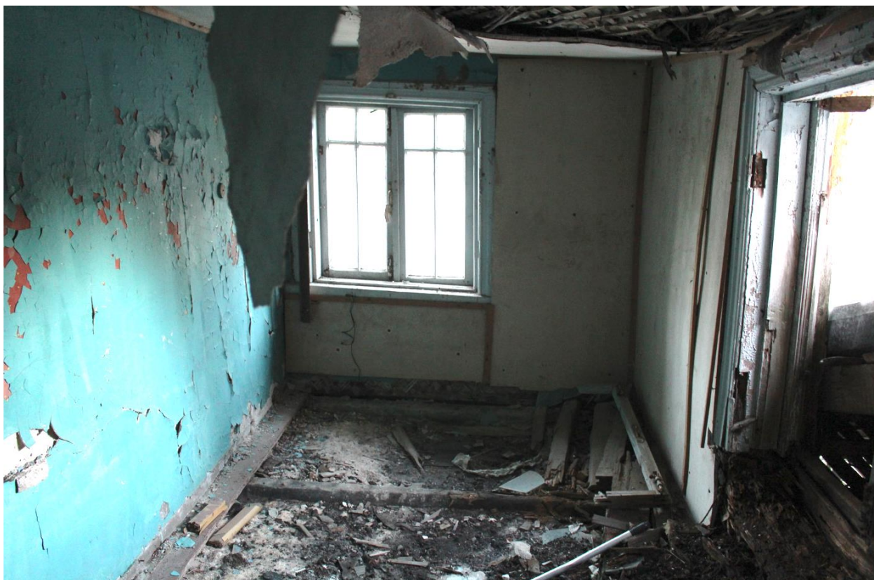
Фото 35. Вид на помещения 2-го этажа исследуемого объекта.
