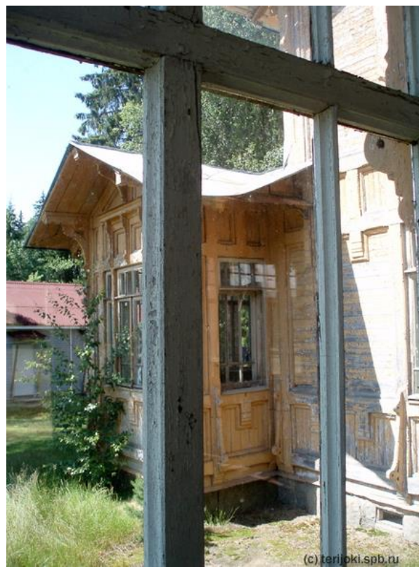
Илл. 20. Вид на исследуемый объект. Дата: 2010 г. Источник: https://terijoki.spb.ru .
