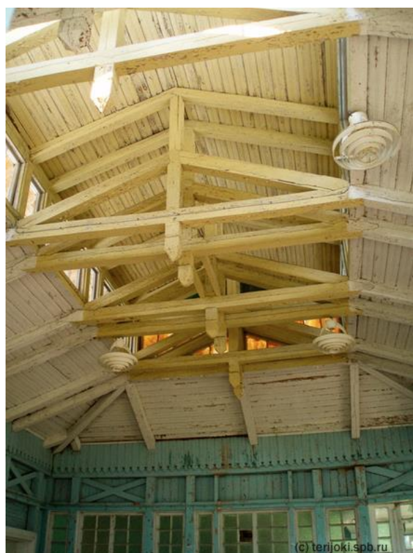
Илл. 21. Вид на исследуемый объект. Дата: 2010 г. Источник: https://terijoki.spb.ru .
