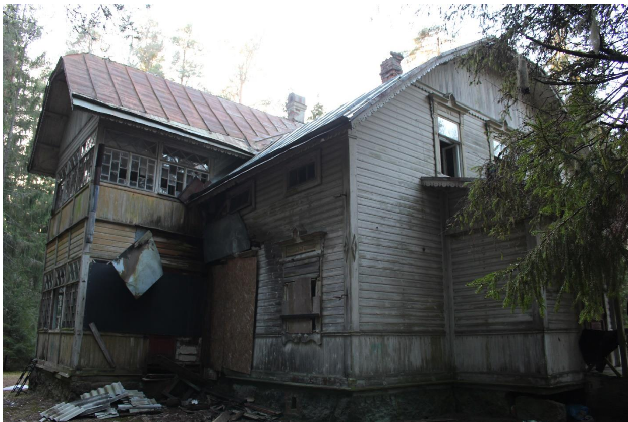
Фото 13. Вид на восточный фасад выявленного объекта культурного наследия «Усадьба Старк».
