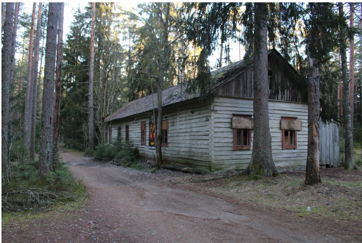
Фото 27. Вид на служебный корпус к западу от выявленного объекта культурного наследия «Усадьба Старк».
