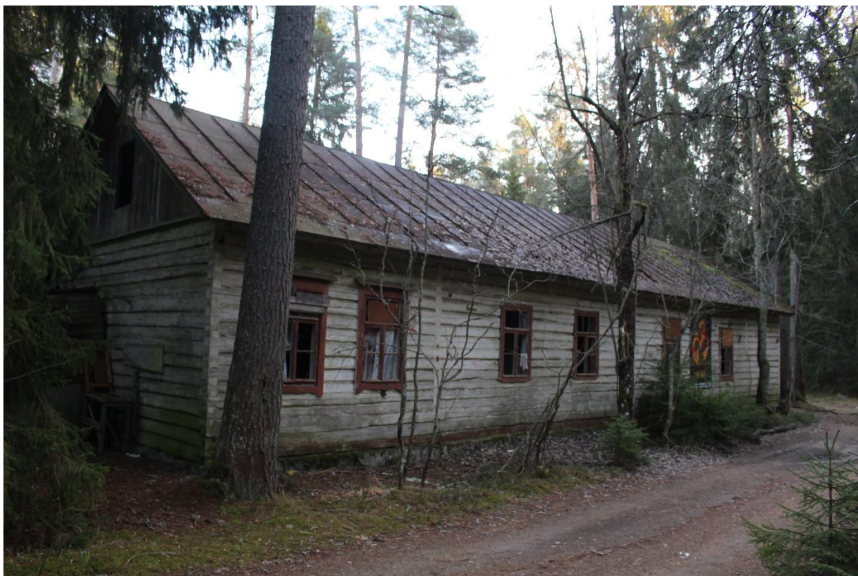
Фото 33. Вид на западный фасад служебного корпуса.
