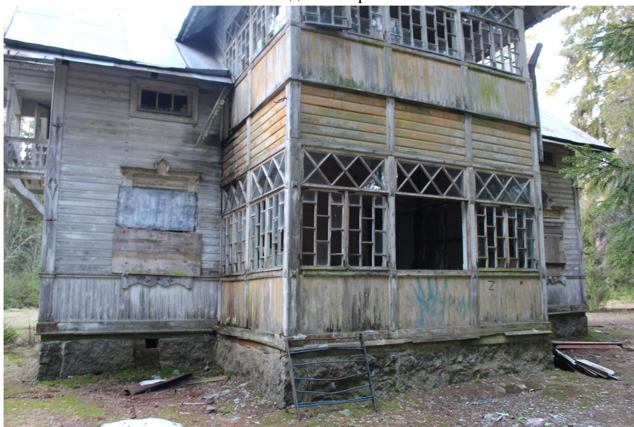
Фото 10. Вид на восточный фасад выявленного объекта культурного наследия «Усадьба Старк».
