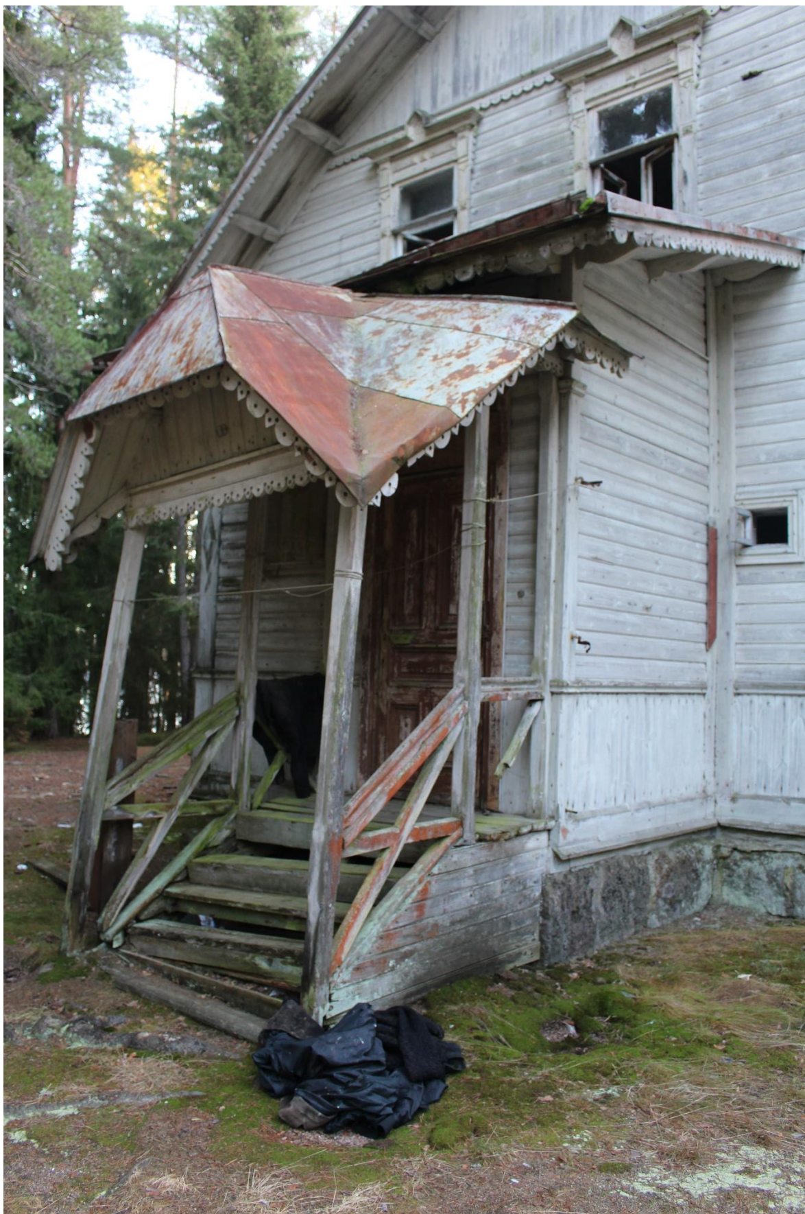
Фото 17. Вид на северный фасад выявленного объекта культурного наследия «Усадьба Старк».
