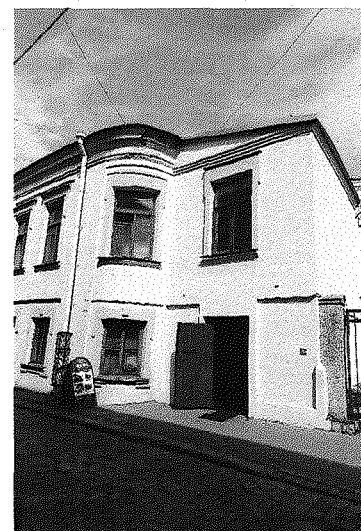
Западный угловой фасад (основной объем) и Ю-З фасад (одноэтажный объем)
