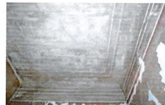
Профилированный карниз с паддугой (пом. 1.8 – 1.10)
