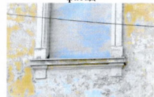
Подоконная тяга оконного проема 2-го этажа. С-В лицевой фасад
