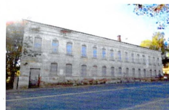
С-В лицевой фасад
