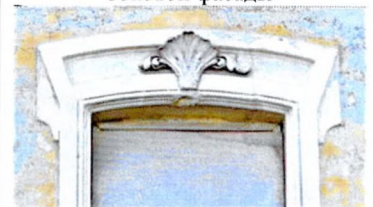
Сандрики проемов 2-го этажа (С-В и Ю-В боковой фасады)
