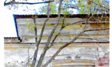
Венчающий карниз с фризами (Ю-В фасад, повышенная часть)
