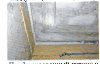
Профилированный карниз с паддугой (пом. 2.13)
