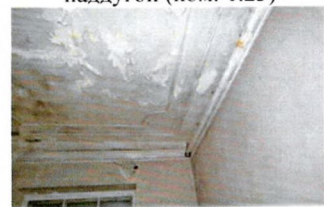
Профилированный карниз с паддугой (пом. 1.24, ЛК-1)
