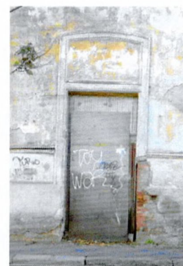
Обрамление уличного дверного проема (Ю-В фасад)
