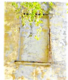
Оконный проем. Боковой С-З фасад
