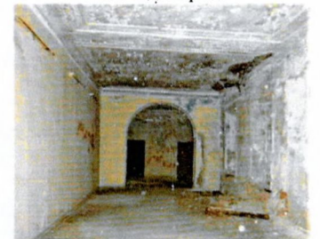
Арочный проем между пом. 2.12 и 2.13
