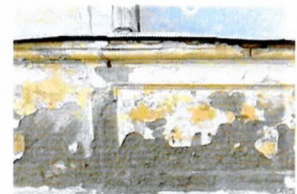
Единая подоконная тяга оконных проемов 1-го этажа. С-В лицевой фасад
