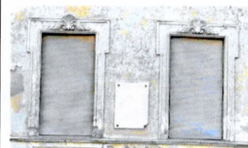
Обрамление проемов 1-го этажа. С-В лицевой и Ю-В боковой фасады
