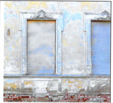
Подоконные филенки (1-ый этаж, С-В лицевой фасад)
