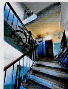
Лестница и перекрытие в Ю-3 крыле здания
