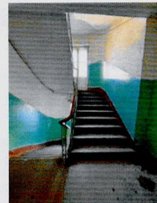
Лестница в Ю-3 крыле здания
