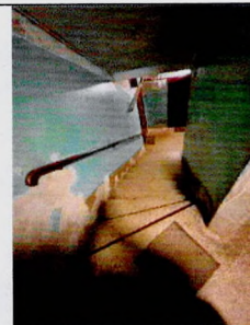
Нижний марш лестницы в подвал в Ю-3 крыле здания
