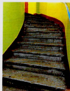
Лестница в С-3 крыле здания
