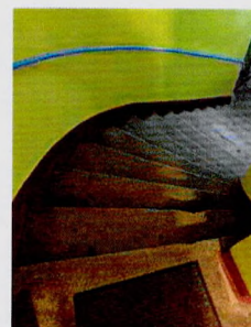
Нижний марш лестницы в С-3 крыле здания
