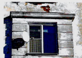
Венчающий карниз эркеров (уличные фасады)
