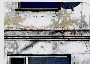
Фрагмент лицевого Ю-В фасада. Межэтажная тяга (между 1-ый и 2-ым этажами)
