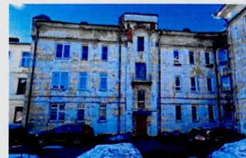
Дворовый С-В фасад Ю-3 крыла
