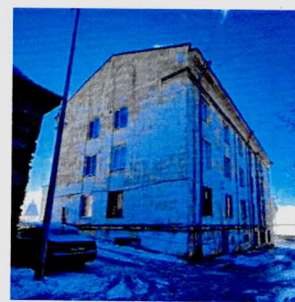
Торцевой С-В фасад С-З крыла
