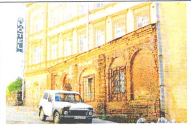
Уличный западный фасад одноэтажной пристройки
