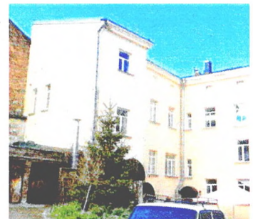
Дворовый фасад южного крыла Торца южного крыла
