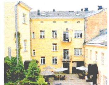
Дворовый фасад западного крыла
