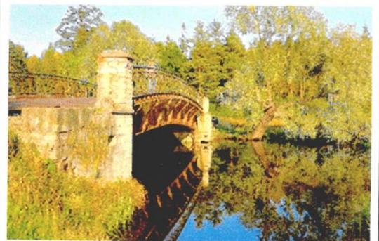
нижним и верхним поясами, опирающимся на кронштейны в виде гнутого уголка с заполнением - рисунок (три кольца); местоположение, габариты, конфигурация; материал (металл);
