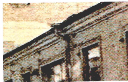
Фрагмент лицевого фасада. Венчающий карниз. Фото (копия) 1954 г.
