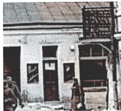
Фрагмент лицевого фасада. Венчающий карниз и рисунок расстекловки двери и витрины в средней части фасада. Фото (копия) 1944 г.
