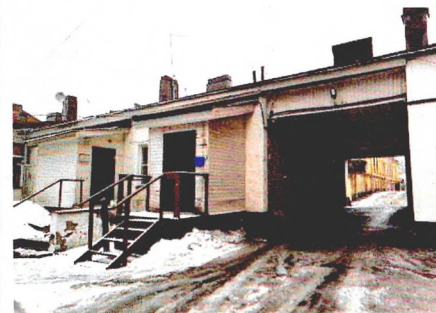
Левая часть дворового Ю-В фасада
