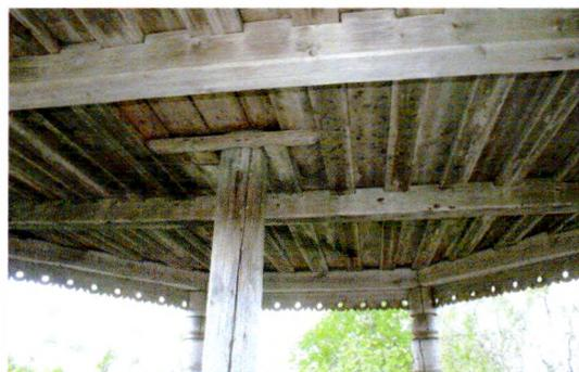
Бревенчатые конструкции плоских перекрытий ярусов колокольни и их высотные отметки.
