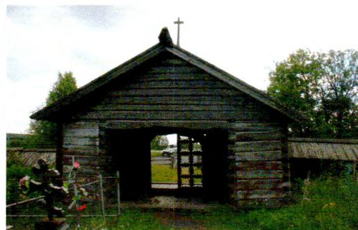
Конструкция, высотные отметки, габариты и материал кровли ворот – двускатная деревянная самцовая, крытая двумя слоями теса.
