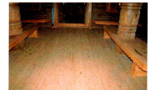
Балочная конструкция, формат, габариты и материал плоского перекрытия помещения трапезной – деревянная балочная конструкция перекрытия с укладкой досок «в косяк», поддерживаемая массивной центральной матицей, опирающейся на два резных бревенчатых столба с резными кронштейнами. Материал и формат заполнения потолков – деревянные доски, уложенные «в косяк» по несущим балкам.
