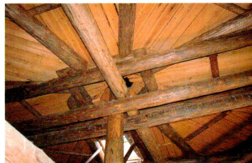
Конструкция, техника исполнения, материал и габариты полов ярусов колокольни – полубревна, уложенные по балкам на врубках в стены.
