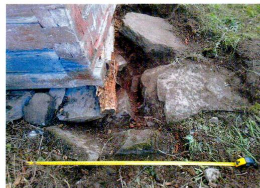
Бревенчатые рубленые стены, уложенные «в лапу». Местоположение, материал, габариты и высотные отметки.
