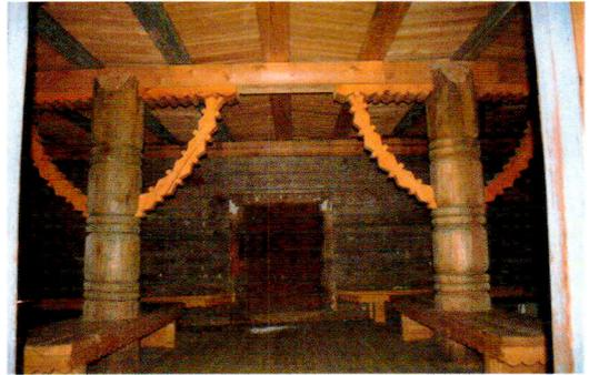
Техника исполнения, форма, габариты и материал столярных заполнений проемов внутренних стен церкви – деревянные двустворчатые резные ворота арочного типа и прямоугольные столярные заполнения окон аналогичного узора.
