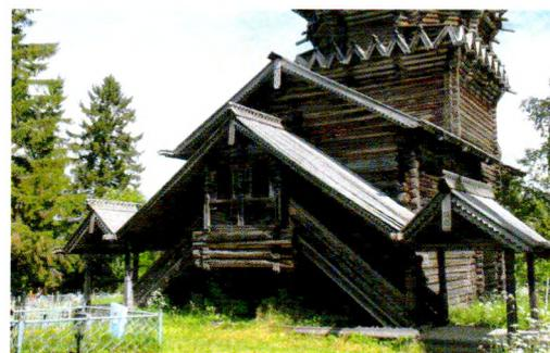
Местоположение, конфигурация, конструкция, габариты, материал и техника исполнения кровли алтарного прируба – деревянная декоративная самцовая кровля-бочка с горизонтально ориентированным тесовым покрытием и установленными поверх конька цилиндрическим барабаном и главкой с крестом.
