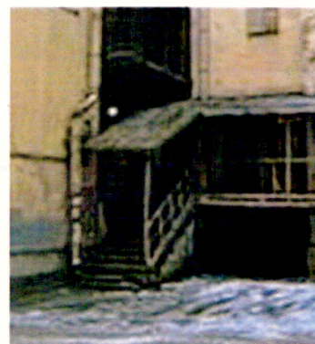
Дворовое бетонное крыльцо (южный угол)
