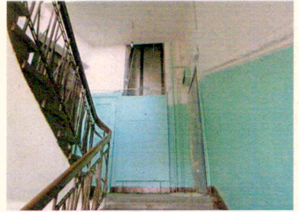
ЛК-4. Промежуточный этаж Гладкая штукатурка стен
