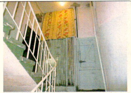
Металлическое ограждение ЛК-3
