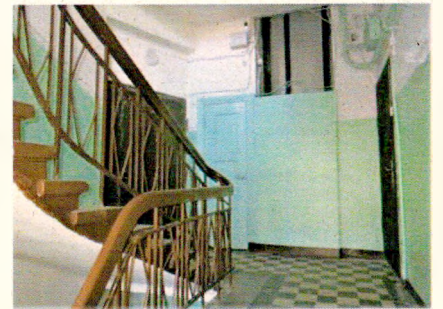
Металлическое ограждение ЛК-4
