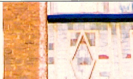
Оформление простенков проемов 3-го и 4-го этажей
