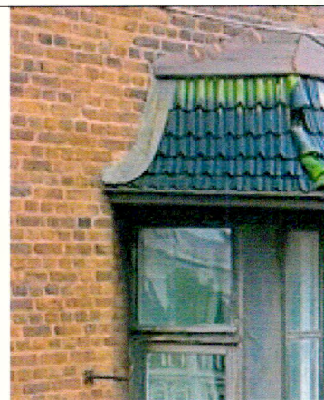
Балкон трехгранного эркера. Уличный Ю-3 фасад
