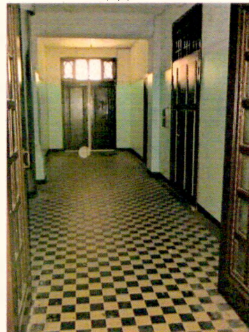
Покрытие пола керамической плиткой парадной ЛК-7
