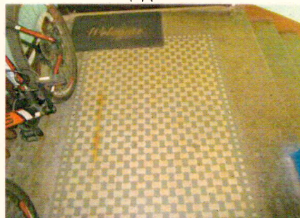
Покрытие пола лестничной площадки ЛК-7
