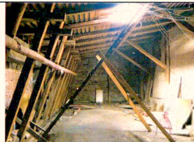
Чердак. Ю-З уличный корпус. Стропильная система
