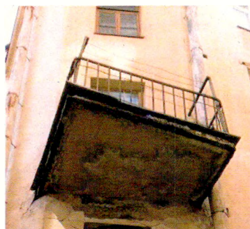
Балкон. Дворовый фасад
