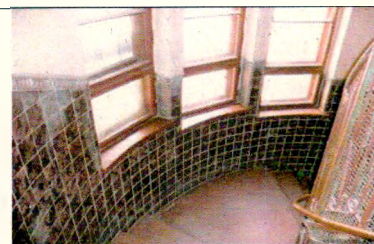
Облицовка стен декоративной керамической плиткой. Парадные лестницы
