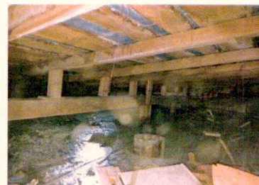
Чердак над мансардной частью здания. Стропильная система
