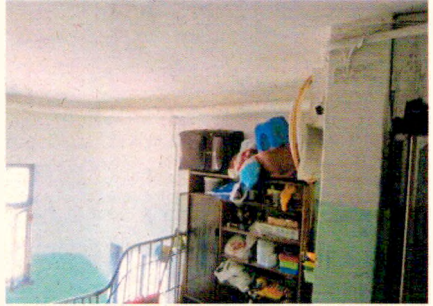
ЛК-6. Верхний этаж. Гладкая штукатурка стен и потолка
