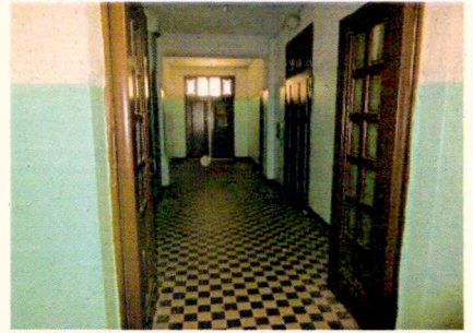
ЛК-7. Помещение 1-го этажа. Гладкая штукатурка стен
