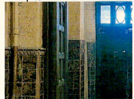
Покрытие керамической плиткой и мозаичное бетонное покрытие внутренних площадок парадного входа ЛК-1
