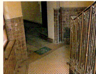
ЛК-1. 1-ый этаж. Облицовка стен керамической плиткой
