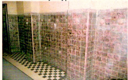
Облицовка стен декоративной керамической плиткой. Парадные лестницы
