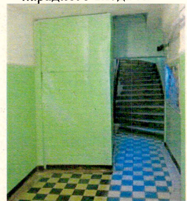
Покрытие пола парадной ЛК-4
