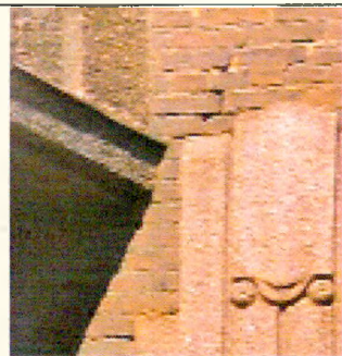
Фрагмент пилона. Ю-З фасад
