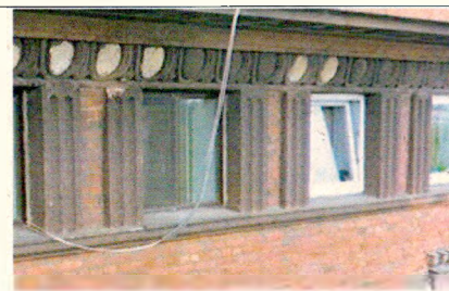
Оконные проемы 6-го яруса (мансардного этажа). Уличный С-3 фасад
