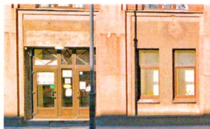
Оконные проемы. 1-ый этаж. Уличный Ю-3 фасад
