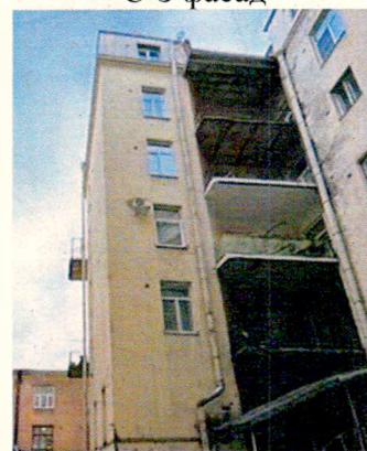
Балконы. Центральный дворовый ризалит. С-З фасад
