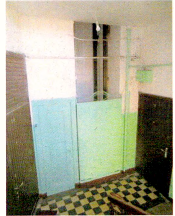
ЛК-4. Лифтовая шахта
