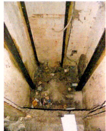
ЛК-6. Лифтовая шахта. Нижняя часть
