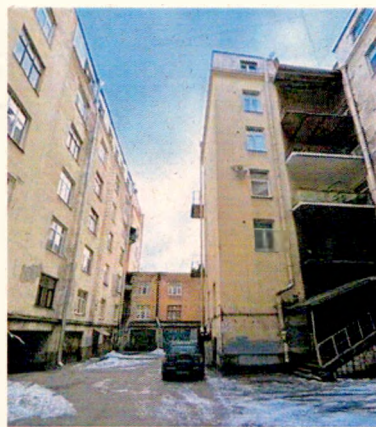
Дворовые фасады. Ю-В часть здания
