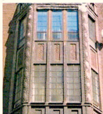
Декор простенков проемов и углов трехгранного эркера. Уличный Ю-3 фасад
