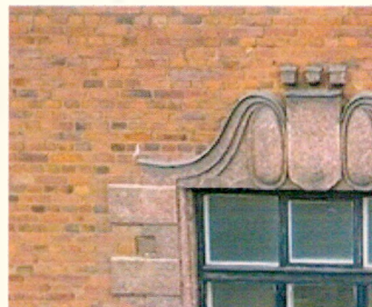
Оконный проем. 5-ый этаж. Уличные фасады
