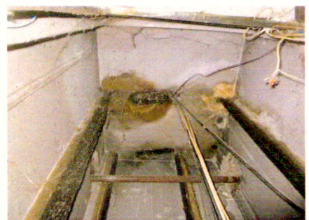
ЛК-6. Лифтовая шахта. Верхняя часть
