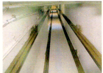
ЛК-4. Лифтовая шахта
