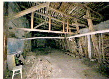
Чердак. Ю-В часть Ю-З уличного корпуса. Стропильная система
