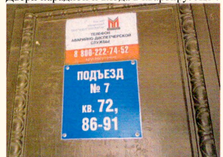
Фрагмент двери парадной. ЛК-7
