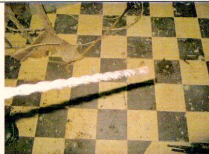
Покрытие лестничных площадок ЛК-4
