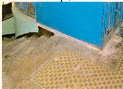
Покрытие пола лестничной площадки ЛК-7
