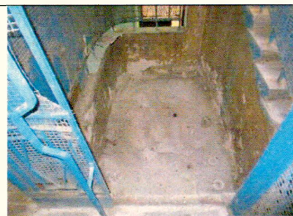
ЛК-7. Лифтовая шахта. Нижняя часть
