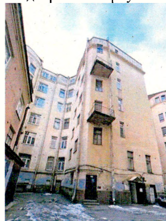
Дворовые фасады Ю-В части уличного Ю-З корпуса
