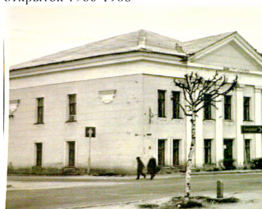
Рис.6. Вид на фрагмент юго-западного и северо-восточного фасада. Набор открыток 1960-1968
