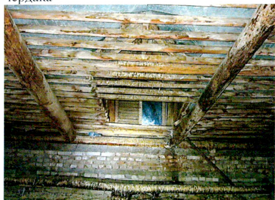
Вид из помещения чердака на конструкции
