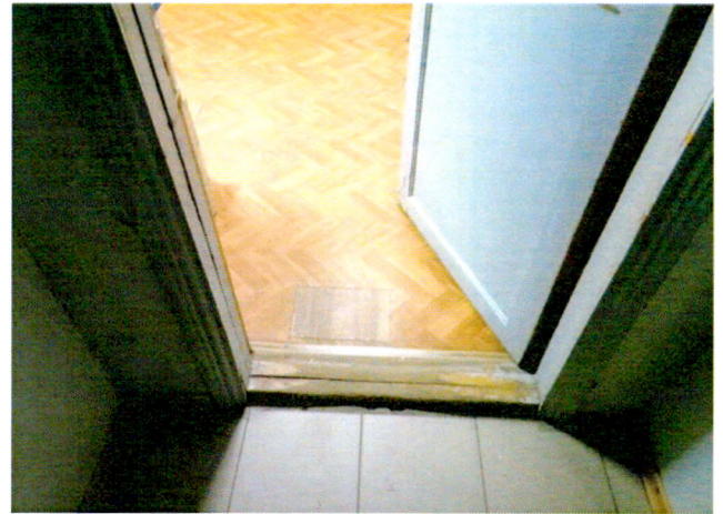
Вид на дверное заполнение и наличник пом. 16
