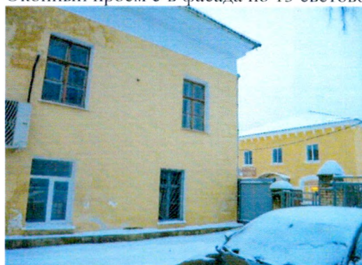
Оконные проемы с-в фасада по 11-13 световым осям
