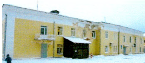
Северо-восточный фасад. Фото 2023г.
