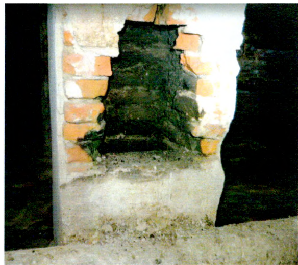
Вид на дымовой канал из помещения чердака
