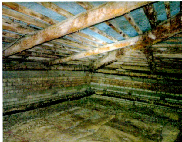
Вид из помещения чердака
