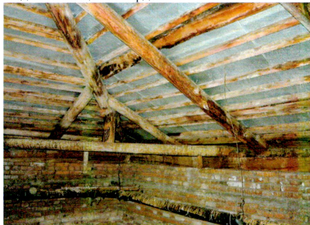
Вид из помещения чердака
