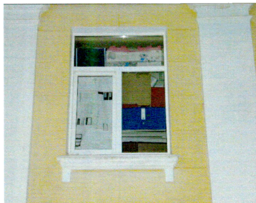
Оконный проем 2-го этажа. Ю-з фасад
