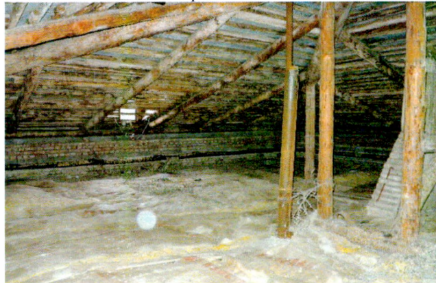
Вид из помещения чердака
