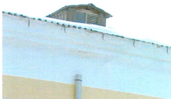
Вид со стороны юго северо-восточного фасада
