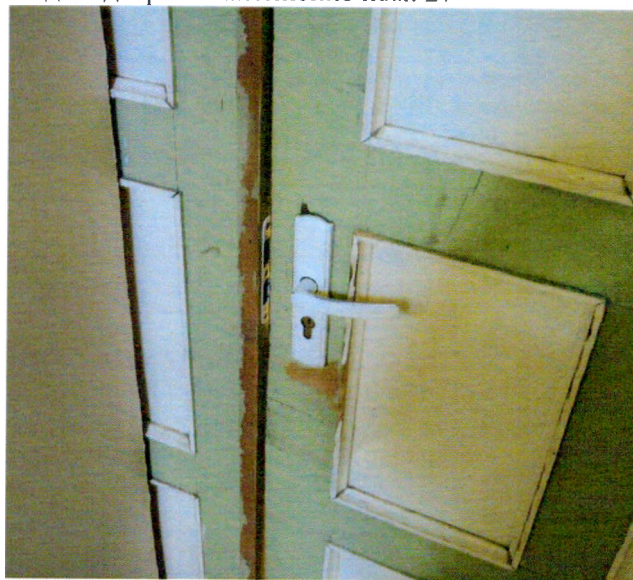
Вид на дверное заполнение пом. 27
