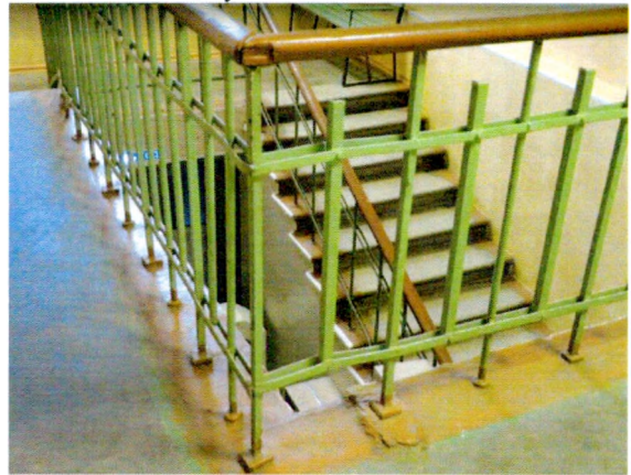
Вид на лестницу Л1 со 2-го этажа
