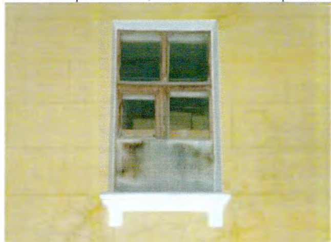
Оконный проем по 2 световой оси с-з фасада
