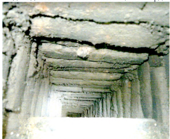
Вид на дымовой канал из помещения чердака
