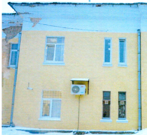
Оконные проемы с-в фасада 5-8 световым осям
