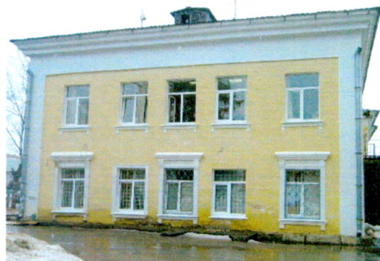
Оконные проемы 1, 2 этажа по 1-5 осям. Ю-в фасад
