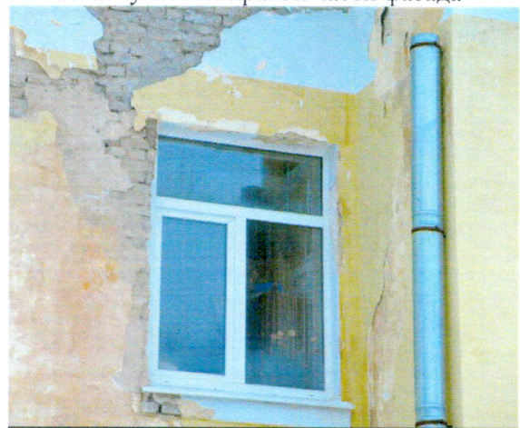
Подоконная тяга с-в фасада
