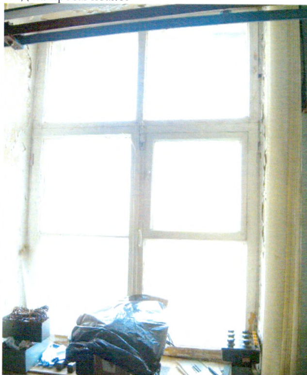
Оконный проем, пом. 29 2-ого этажа
