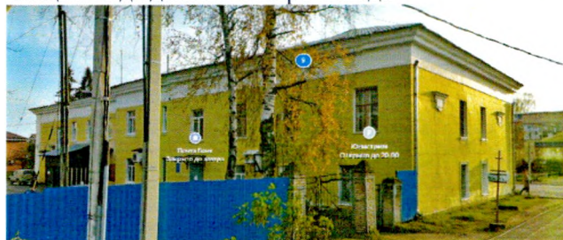
Общий вид здания с северо-востока
