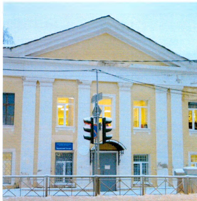
Фронтон с пилястрами и капителями дорического ордера, имитирующие портик ю-з фасада
