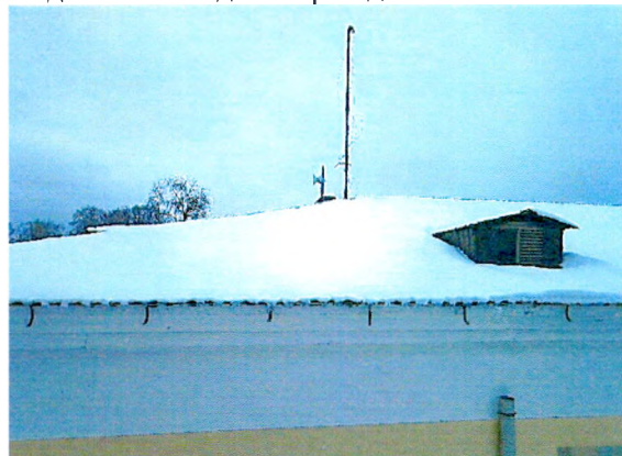
Вид с северо-восточного фасада
