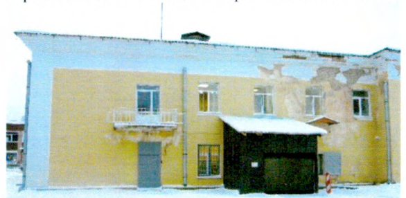
Северо-восточный фасад. Фото 2023г.
