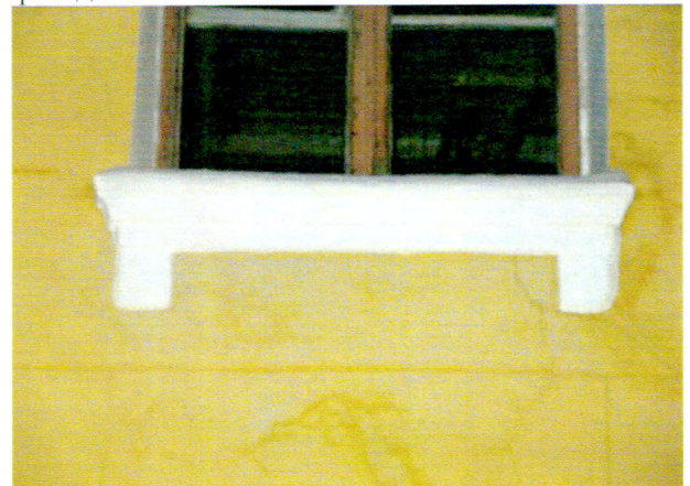
Подоконные тяги с кронштейнами с-з фасада
