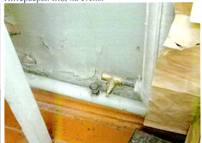
Вид на покрытие пола пом.15
