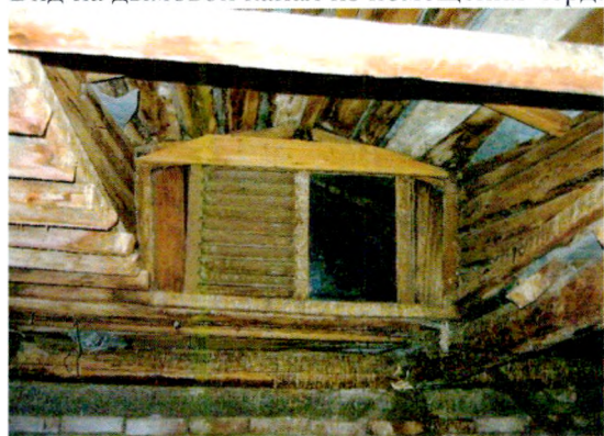
Конструкции слухового окна из помещения чердака
