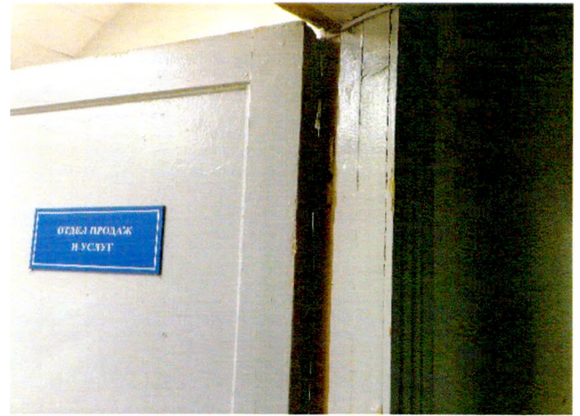
Вид на дверное заполнение и наличник пом. 16
