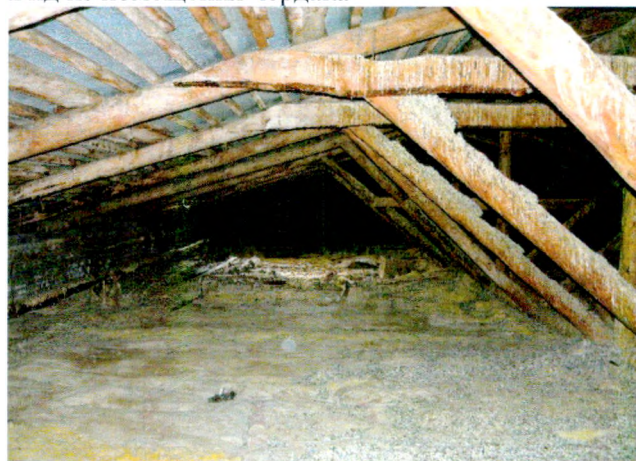
Вид из помещения чердака
