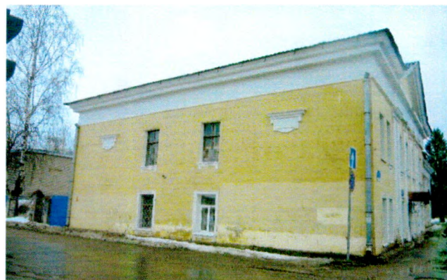
Общий вид здания с северо-запада
