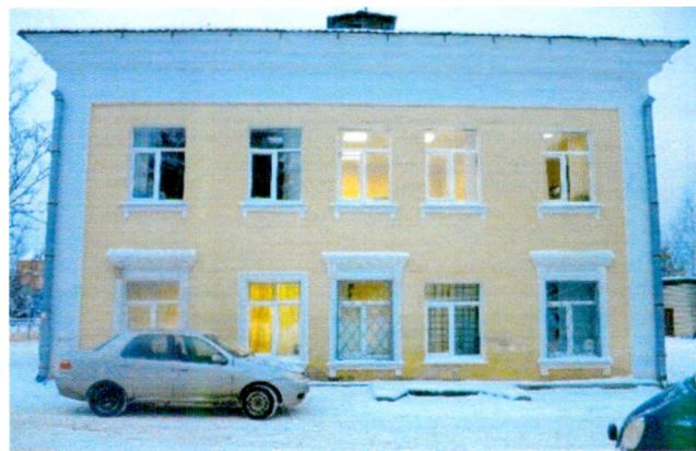
Юго-восточный фасад. Фото 2023г.
