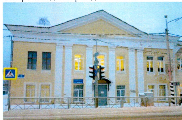
Фрагмент юго-западного фасада. Фото 2023г.
