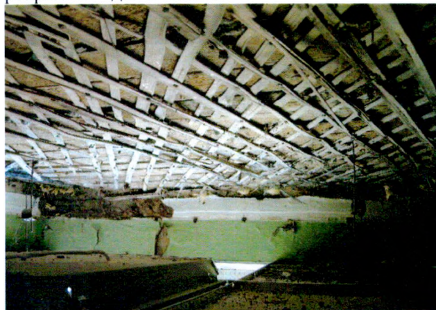
Перекрытие над 2-м этажем
