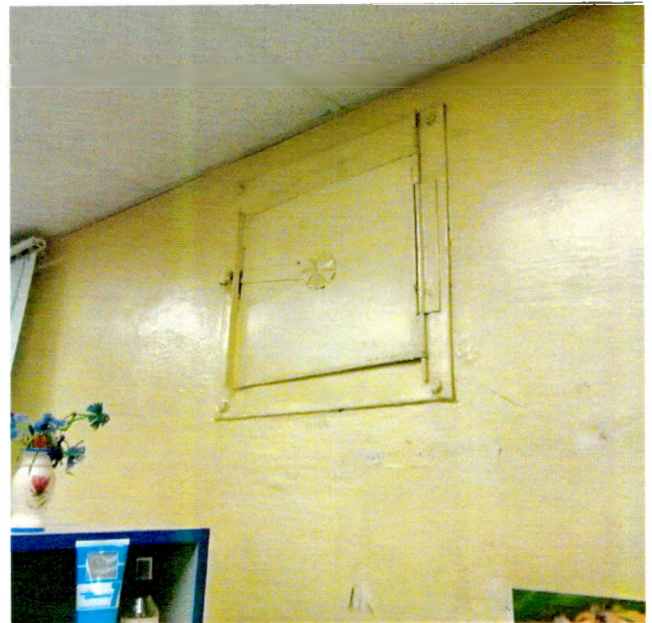
Вид на исторический сейф в пом.35
