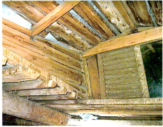
Вид из помещения чердака. Конструкции слухового окна
