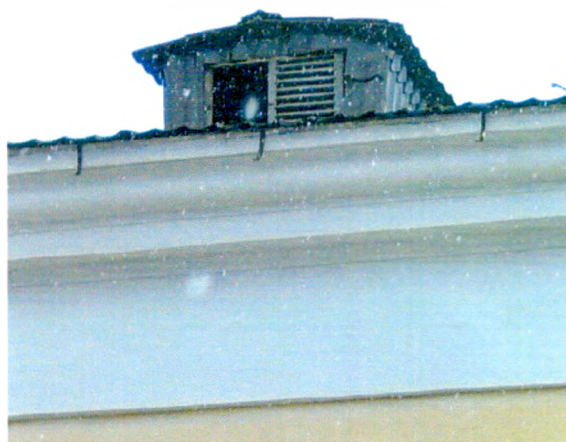
Вид со стороны юго-восточного фасада
