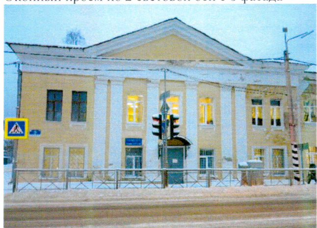
Ризалит в левой части ю-з фасада
