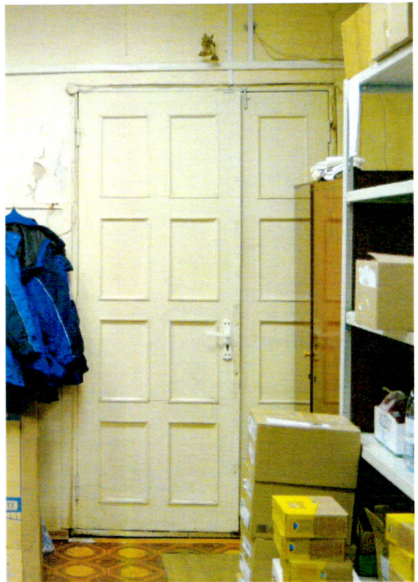
Вид на дверное заполнение пом. 27
