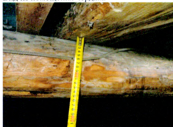
Вид из помещения чердака
