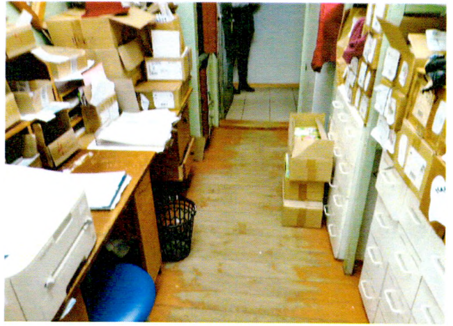
Вид на покрытие пола пом. 15
