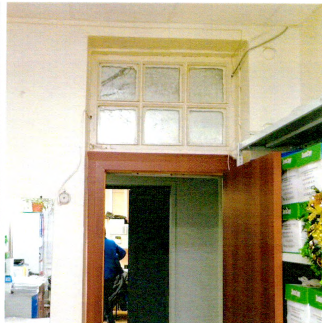
Вид на проем пом.19
