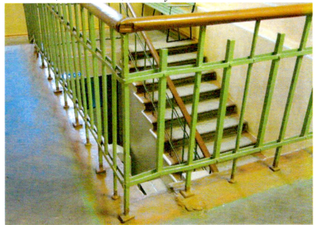
Лестница ЛК 1. Вид на мателлическое ограждение
