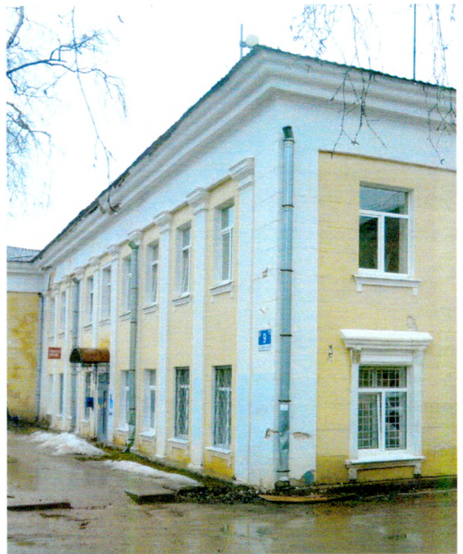
Пилястры в правой части фасада, рустованная лопатка в угловой правой части ю-в фасада
