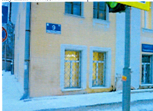
Фрагмент юго-западного фасада. Фото 2023г.
