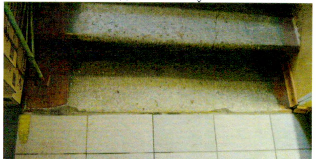
Лестница ЛК 1. Вид на ступени. Основание ступени скрыто поздним покрытием пола
