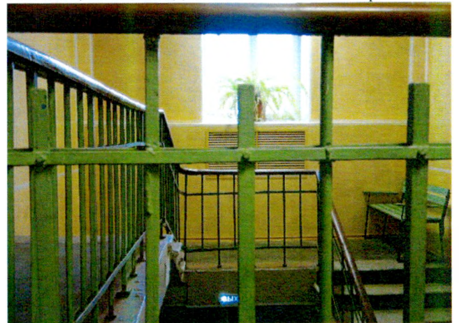
Лестница ЛК 1. Вид на ограждение
