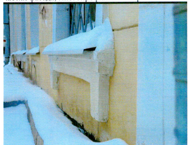
Подоконные тяги с кронштейнами ю-в фасада
