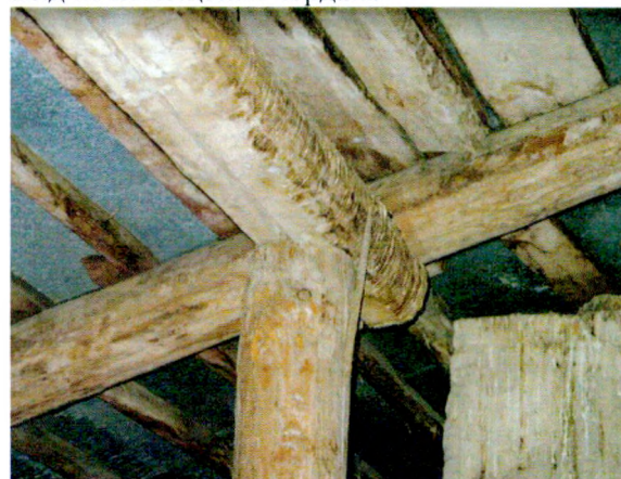
Вид из помещения чердака
