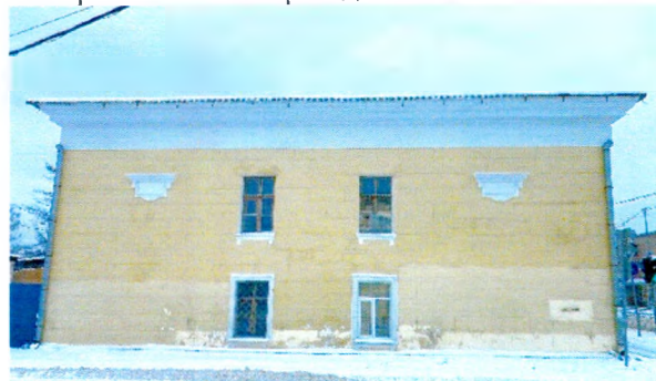
Северо-западный фасад. Фото 2023г.
