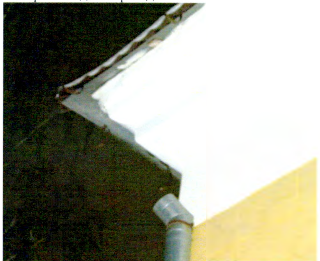
Многопрофильный карниз со значительным выносом с-з фасада
