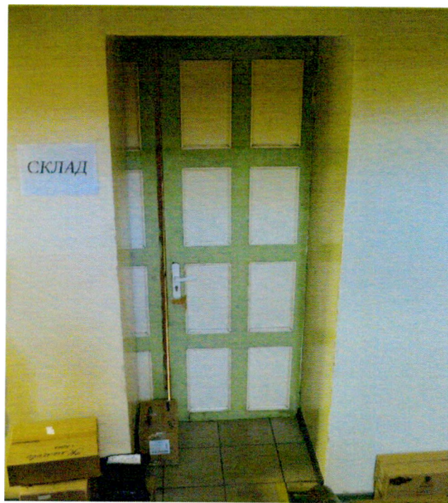
Вид на дверное заполнение пом. 27
