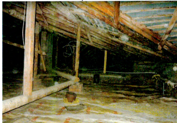
Вид из помещения чердака
