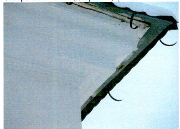
Многопрофильный карниз со значительным выносом с-в фасада
