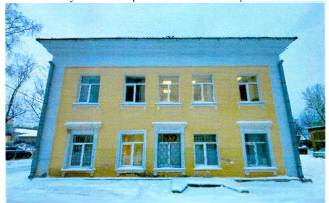
Ю-в фасад. Рустованные лопатки в угловых частях фасада, многопрофильный карниз
