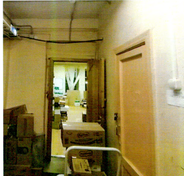
Вид на наличник дверного проема пом.35
