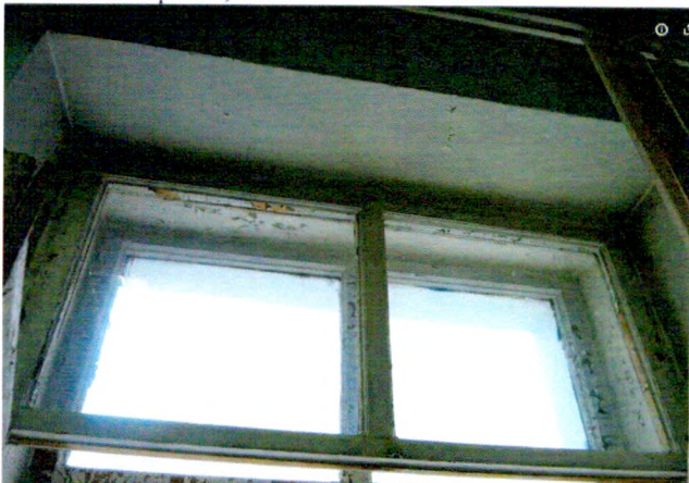
Оконный проем, пом. 30 2-ого этажа
