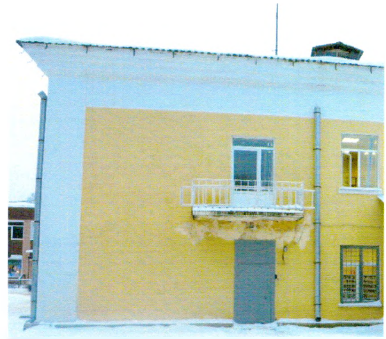
Лопатка в угловой правой части фасада
