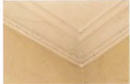
Потолочная галтель (пом. 2.1)
