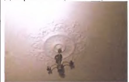
Лепной плафон (пом. 1.8)
