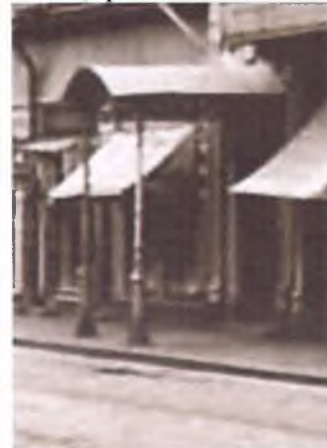
Фрагмент Ю-3 фасада, металлический навес, 1930-е гг.
