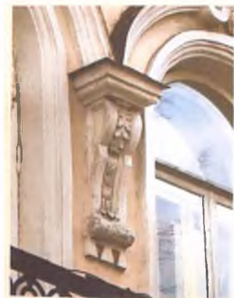
Консоль сандриков проемов Ю-3 фасада, 2-ой ярус (фото 2006 г.)
