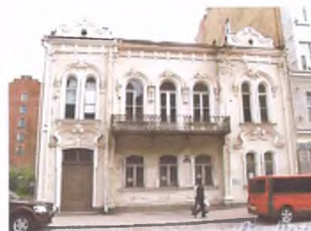
Ю-З лицевой фасад (фото 2018 г.)
