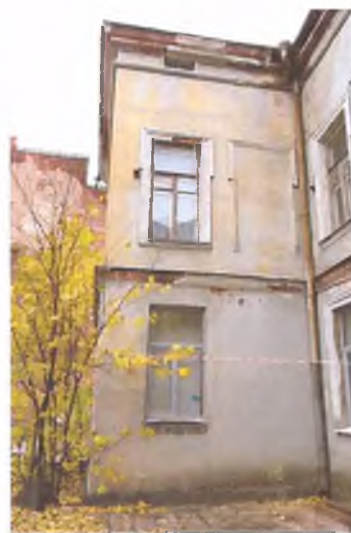
Дворовой Ю-З фасад дворового крыла
