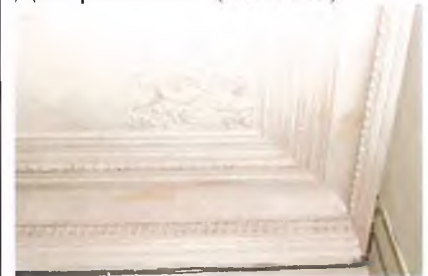
Декор потолка (пом. 2.10)
