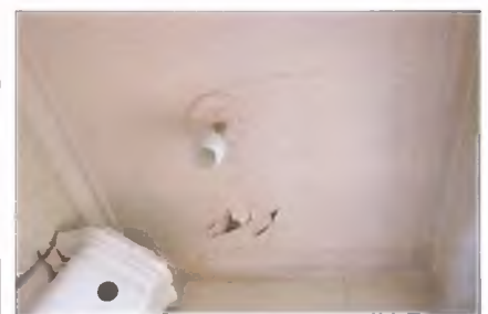
Плоское перекрытие (пом. 2.1)
