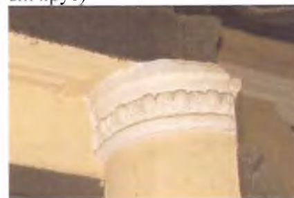
Капитель полуколонны (пом. 1.1, 1-ый ярус)
