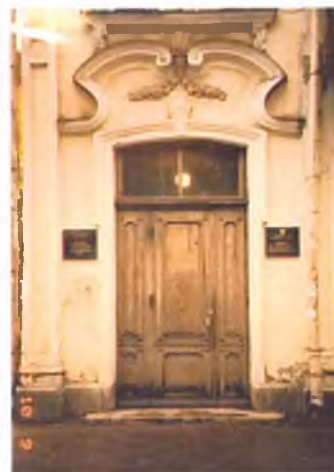
Входной проем, его оформление (Ю-З лицевой фасад), фото 2003 г.
