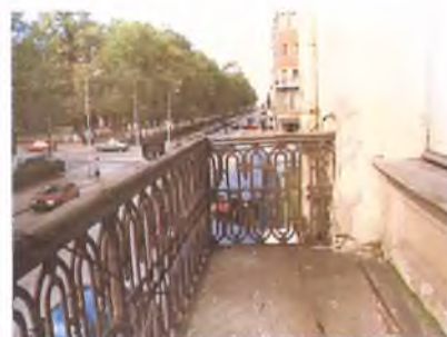
Балкон (Ю-З лицевой фасад)
