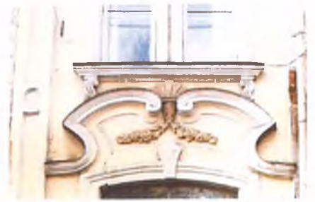
Фигурный сандрик проемов 1-го яруса, подоконная тяга проемов 2-го яруса (Ю-3 лицевой фасад) Фото 2006 г.
