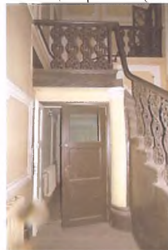
Опорная полуколонна (пом. 1.1, 1-ый ярус)
