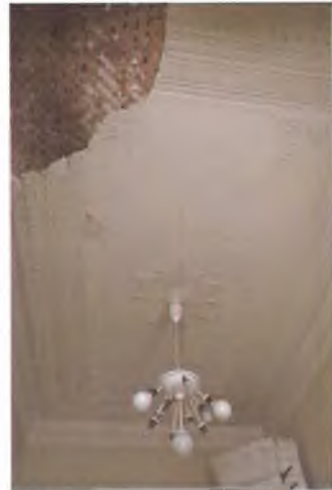
Плоское перекрытие (пом. 2.5)
