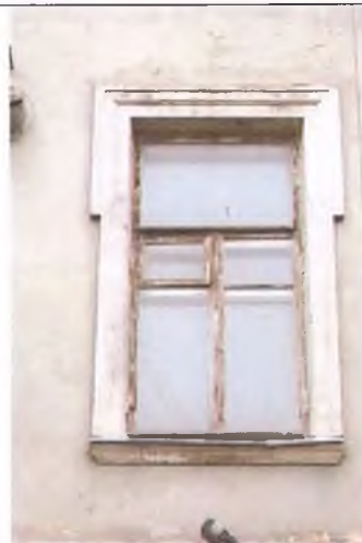
Оконный проем, его оформление (дворовые фасады)
