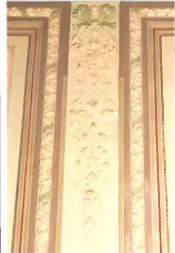
Лепной декор простенка между филенками (пом. 2.4, фрагмент)
