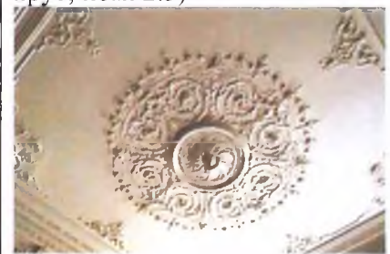
Лепной плафон (пом. 2.4)
