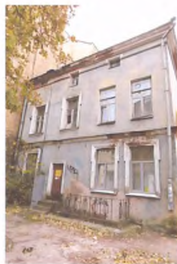
Дворовой С-В фасад дворового крыла
