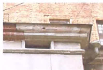
Венчающий карниз (дворовые фасады)
