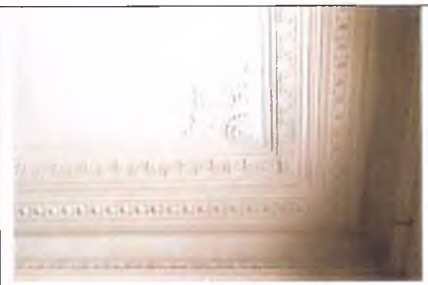
Декор потолка (пом. 2.5)
