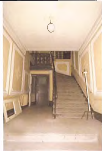
Плоское перекрытие (пом. 1.1)
