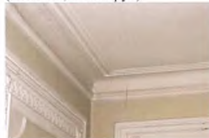
Потолочная галтель (пом. 1.2)
