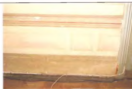
Оформление парапета (пом. 2.4, нижняя часть стен)
