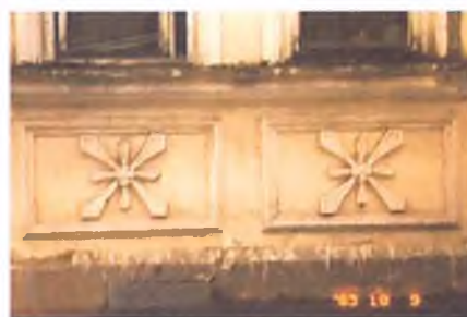
Подоконные филенки (Ю-3 фасад, ризалит, 1-ый ярус), фото 2003 г.
