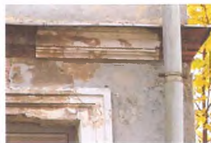
Межэтажный карниз (дворовые фасады)
