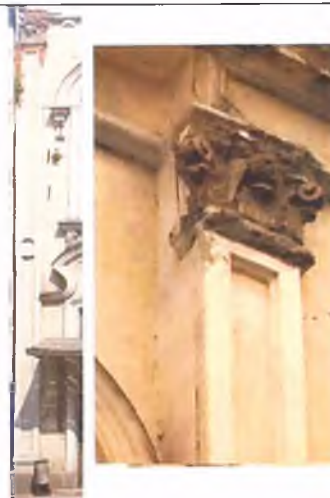
Пилястра и ее капитель (Ю-3 лицевой фасад), фото 2003 г.
