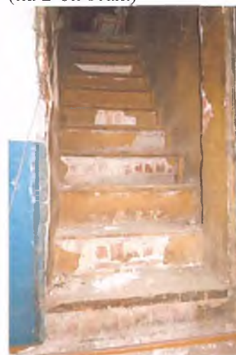
Лестница кирпичная (на чердак)
