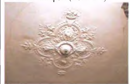
Лепной плафон (пом. 2.6)
