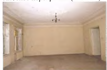
Плоское перекрытие (пом. 1.8)
