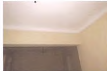
Поточная галтель (пом. 1.9, пом. 2.3, 2.7, 2.11, 2.12)
