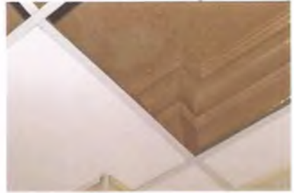
Потолочная галтель (пом. 1.13)
