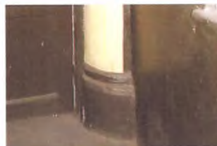
База полуколонны (пом. 1.1, 1-ый ярус)
