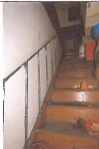
Лестница металлическая (на 2-ой этаж)
