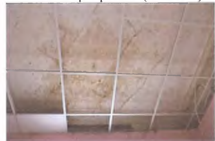
Плоское перекрытие (пом. 1.13)
