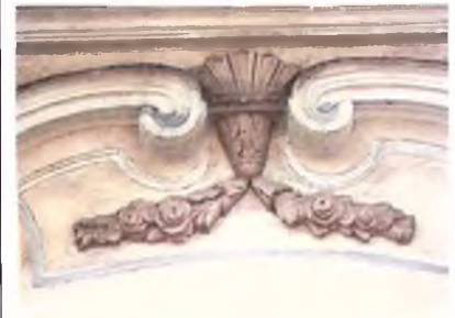
Фрагмент центральной части сандрика проемов (Ю-3 фасад, 1-ый ярус), фото 2006 г.
