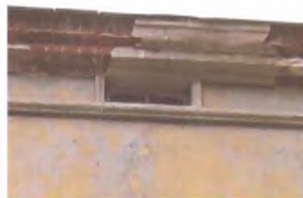
Оконный проем (фриз, дворовые фасады)
