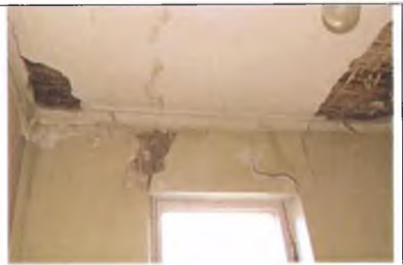
Плоское перекрытие (пом. 2.3)
