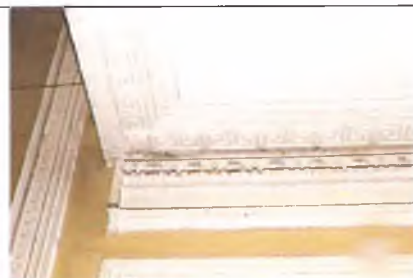
Лепные галтель и пояс потолка (пом. 1.1, 1-ый ярус)
