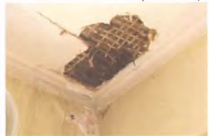
Потолочная галтель (пом. 2.6, 2.13)
