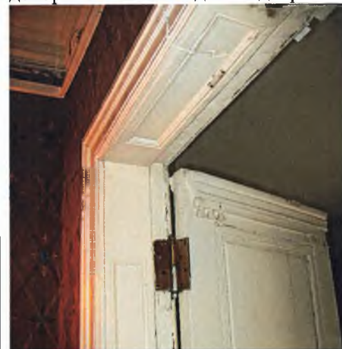
обработка дверных откосов
