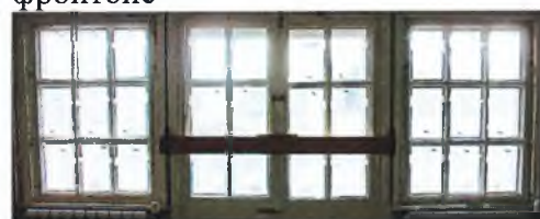
оконные проемы мезонина
