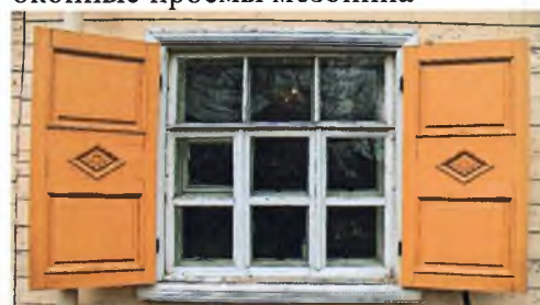
ставни на окнах дворового фасада
