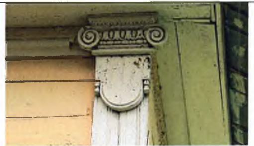
капитель ионического ордера пилястры мезонина
