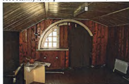
мезонин, северо-восточное помещение
