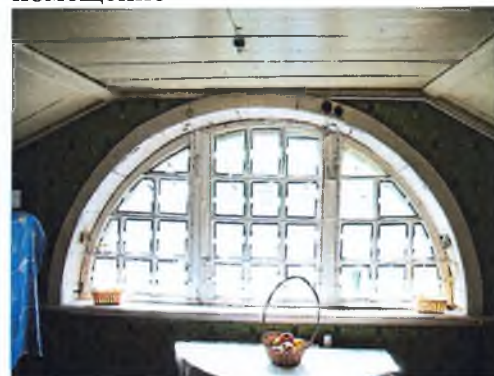
мезонин, юго-западное помещение
