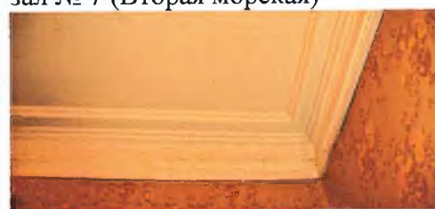
тянутый карниз по периметру
