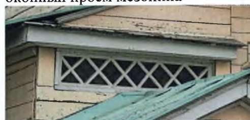
оконный проем над входом Вх1
