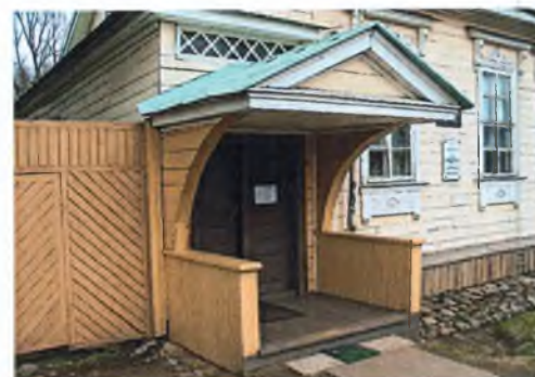
козырек над проемом Вх 1
