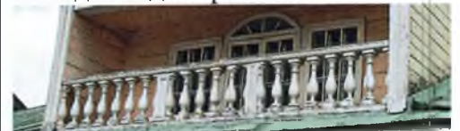
дверной проем выхода из мезонина
