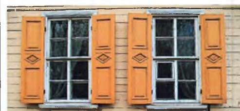
оконные проемы дворового фасада
