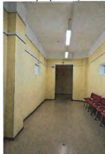
Плоское перекрытие (пом. 2.8)
