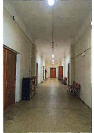
Плоское перекрытие (пом. 3.8)
