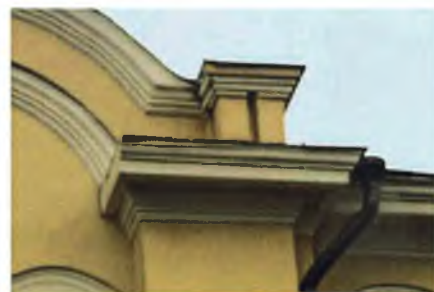
Уличный Ю-В фасад. Пинакли лопаток центральной части ризалита
