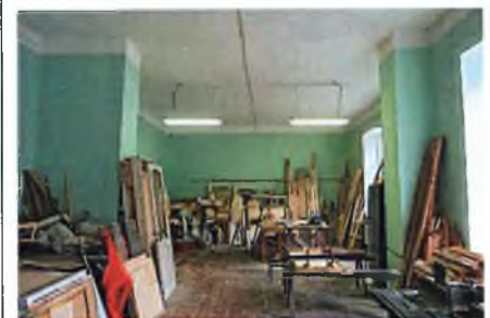
Опорные столбы (пом. 1.7)
