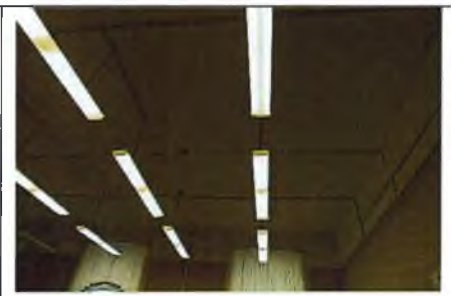
Плоское перекрытие ( пом. 2.12)
