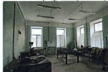
Плоское перекрытие (пом. 1.13)
