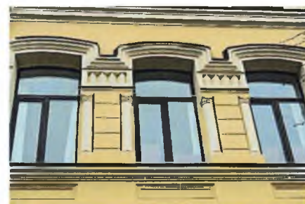
Уличный Ю-В фасад. Проемы 2-го этажа боковых частей фасада
