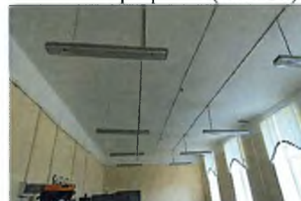
Плоское перекрытие (пом. 2.14).
