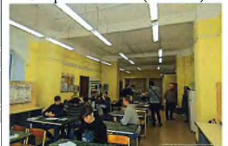
Опорные столбы (пом. 2.9)
