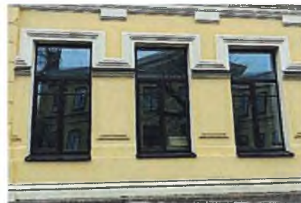
Уличный Ю-В фасад. Проемы 1-го этажа боковых частей фасада
