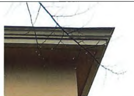
Венчающий карниз. Дворовые фасады
