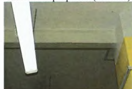
Плоское перекрытие (пом. 2.9)
