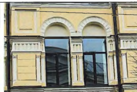
Уличный Ю-В фасад. Проемы 2-го этажа центрального ризалита
