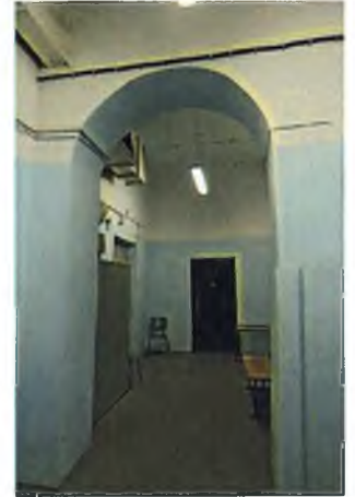
Арочный проем (пом. 1.8)
