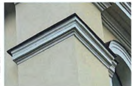
Карниз межоконный (уличные фасады, 3-ий этаж)
