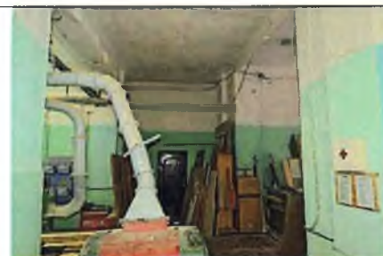
Плоское перекрытие (пом. 1.7)
