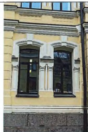
Уличный Ю-В фасад. Проемы 1-го этажа центрального ризалита
