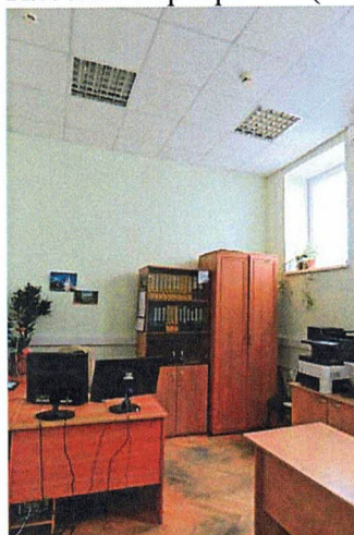
Плоское перекрытие (пом. 1.12)
