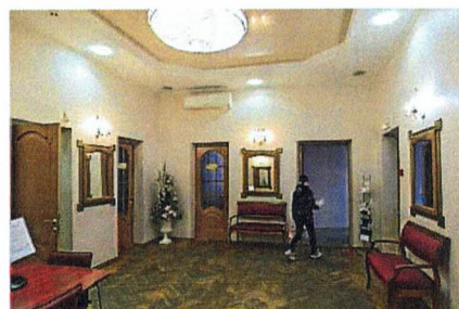
Плоское перекрытие (пом. 1.3)
