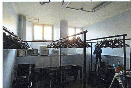
Плоское перекрытие (пом. 0.13)
