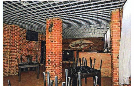
Опорные столбы (пом. 0.11)
