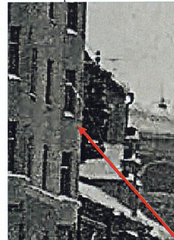
Башнеобразная надстройка. Фото 1968 г.
