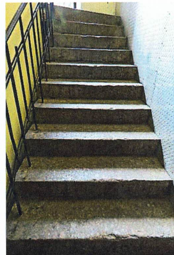
Гранитная лестница (спуск в подвал)
