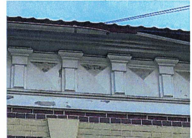
Фриз и карниз (уличный фасад)
