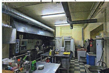
Плоское перекрытие (пом. 0.9)
