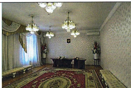
Плоское перекрытие (пом. 1.7)
