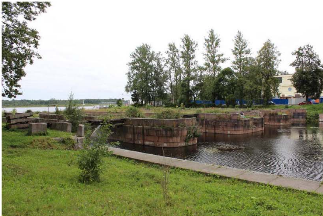
2. Вид на шлюзы Староладожского канала с площади перед Благовещенским собором (южный берег канала)
