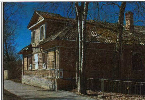
Вид на юго-восточный и северо-восточный фасады
