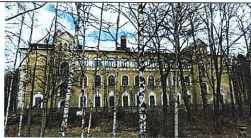
Лицевой Ю-3 фасад
