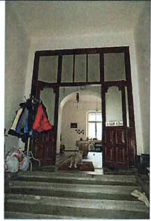
Пом. 18. Входная лестница. 1-ый этаж
