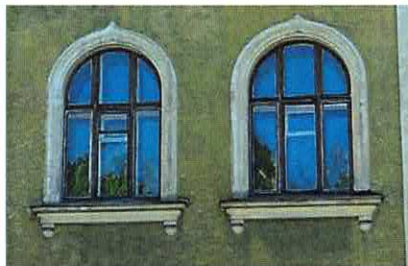
Оконные проемы, 2-ой этаж лицевых фасадов
