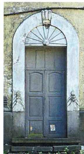
С-В дворовой фасад, входной проем
