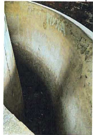
Бетонные стены резервуара
