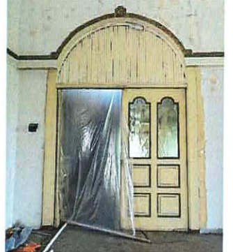
Дверь. Между ЛК-1 и пом. 151
