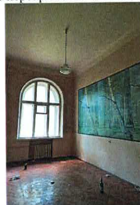
Плоское перекрытие. 2-ой этаж (пом. 102)
