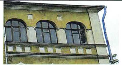
Межэтажный фриз. С-З, Ю-З лицевые, Ю-В фасады
