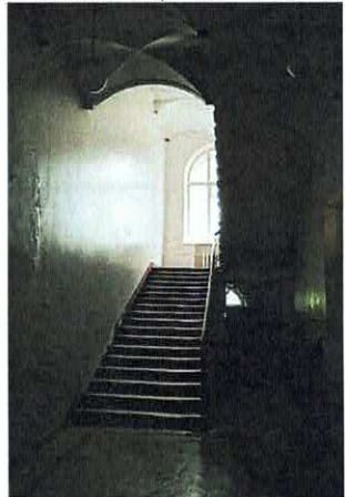
Лестница ЛК-1. 1-ый этаж
