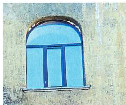
Оконный проем 3-го этажа. Дворовые фасады
