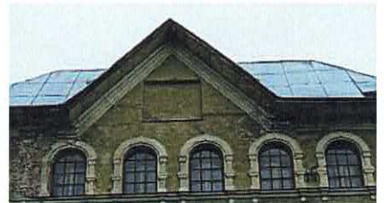
Венчающий карниз. Лицевые фасады и Ю-В дворовой фасад
