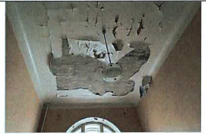
Плоское перекрытие. 2-ой этаж (пом. 116)
