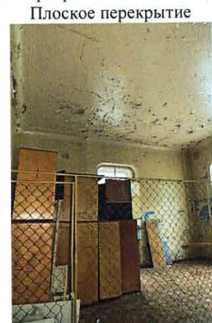
Плоское перекрытие. 1-ый этаж (пом. 28)
