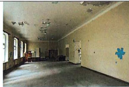
Плоское перекрытие 1-ый этаж (пом. 33)
