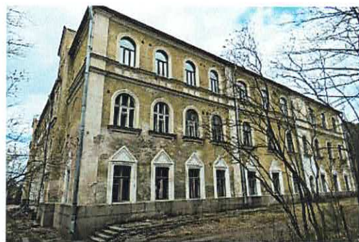
Ю-В фасад Ю-В крыла
