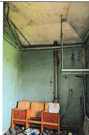
Плоское перекрытие. 4-ый этаж, пом. 214.
