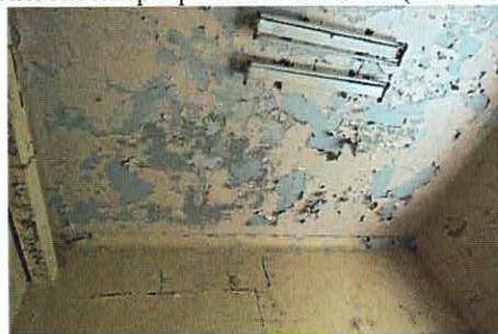
Плоское перекрытие. 1-ый этаж (пом. 57)
