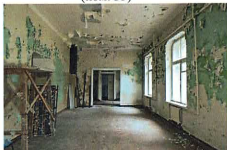
Плоское перекрытие. 1-ый этаж (пом. 35)
