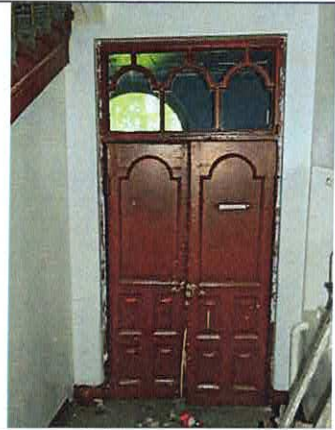
Дверь. Между пом. 29 и 30
