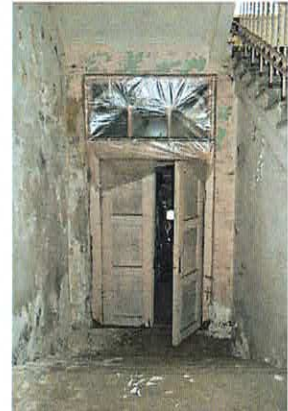
Бетонная лестница (входы в ЛК-1 и ЛК-2)
