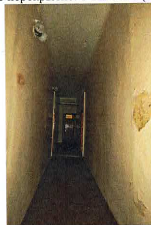
Плоское перекрытие. 2-ой этаж (пом. 67)
