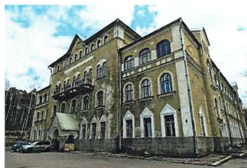
Лицевой С-З фасад
