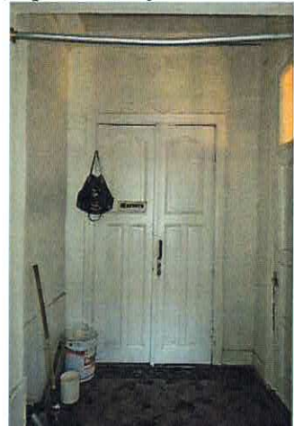
Дверь. Между пом. 20 и 22
