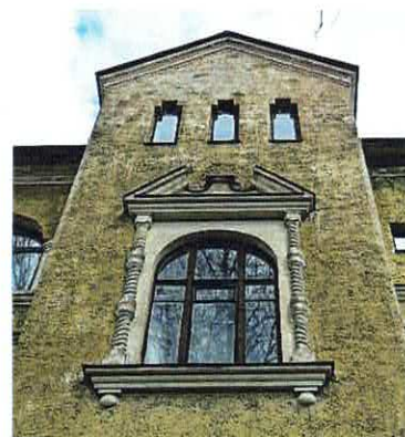
Оконные проемы лестничной клетки (3-ий и 4-ый этажи)
