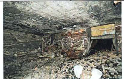
Плоские перекрытия. Подвал
