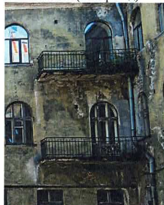
Балконы (С-3 дворовой фасад Ю-В крыла)
