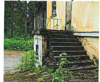
Крыльцо. Ю-В фасад
