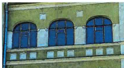
Оконные проемы 3-го этажа. С-3 и Ю-3 лицевые фасады
