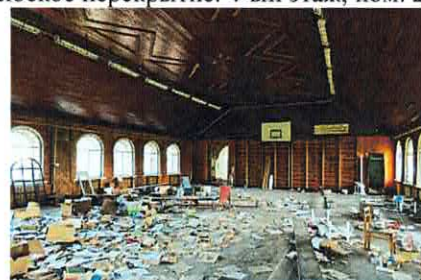
Плоские перекрытия 4-го этажа (пом. 114, 115)
