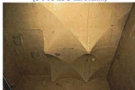
Совмещенные перекрытия (С-В часть ЛК-1, 1-ый - 3-ий этажи)
