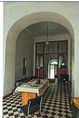
Арочный проем. Пом. 18
