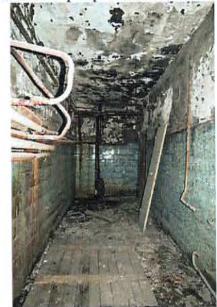
Плоское перекрытие. Подвал Плоское перекрытие. 1-ый этаж (пом. 28)
