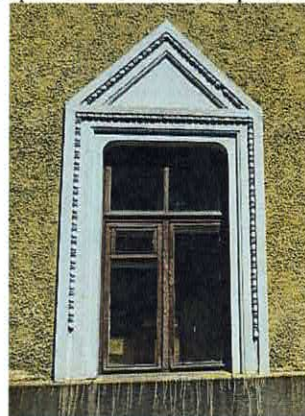
Оконный проем. 1-ый этаж
