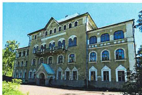
Лицевой С-З фасад
