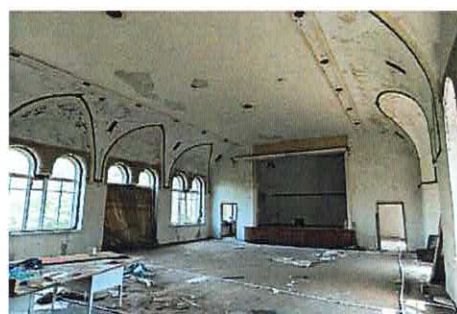
Плоское со сводами и распалубками перекрытие. 3-ий этаж (пом. 151)
