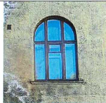
Оконный проем 2-го этажа, дворовые фасады
