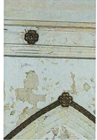
Оформление проема распалубки и потолочной галтели. Пом. 151
