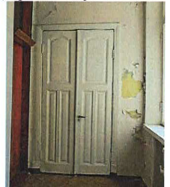
Дверь. Между пом. 61 и 62
