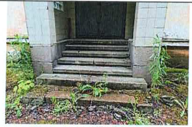
Крыльцо. С-В фасад
