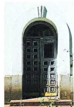
Входной проем, Ю-В фасад Ю-В крыла
