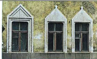
Оконные проемы С-3 лицевого фасада. 1-ый этаж
