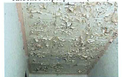
Плоское перекрытие (пом. ЛК-2)
