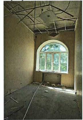
Плоское перекрытие. 3-ий этаж 2-ой этаж (пом. 169)
