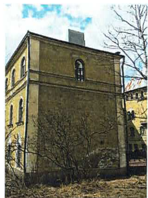
С-В торцевой фасад Ю-В крыла
