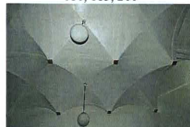
Потолок. Пом. 29. ЛК-1
