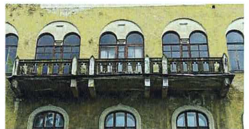
Балкон С-З лицевого фасада
