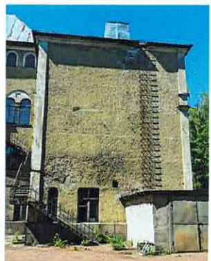
Ю-В торцевой фасад С-В крыла
