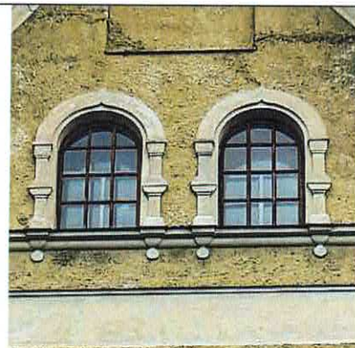
Оконные проемы 4-го этажа. С-3 лицевой фасад
