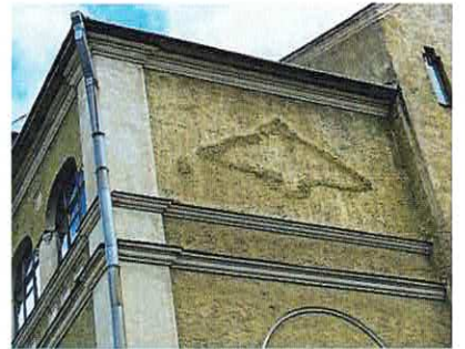
Фриз, венчающий карниз трехэтажной части и рельефное изображение орла. Ю-З фасад
