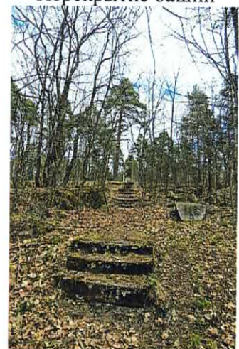
Лестница подъема на башню
