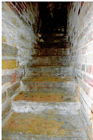
Лестница в подвал (пом. 0.1)
