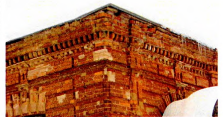
Венчающий карниз с фризом и завершениями замковых камней и «полотенец» простенков (южный и западный фасад)
