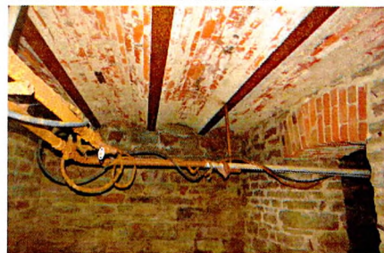
Перекрытие из кирпичных сводиков по металлическим балкам (подвал, пом. 0.3)
