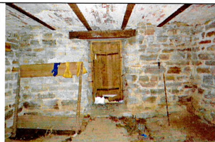
Подвал (пом. 0.10). Стены из известняковых блоков.
