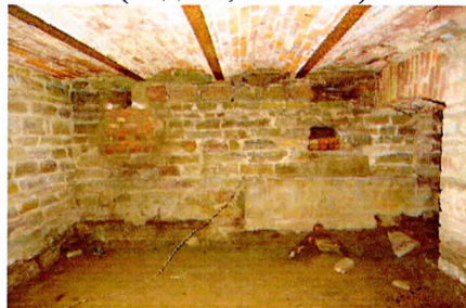
Подвал (пом. 0.13). Стены из известняковых блоков, перекрытие из кирпичных сводиков по металлическим балкам
