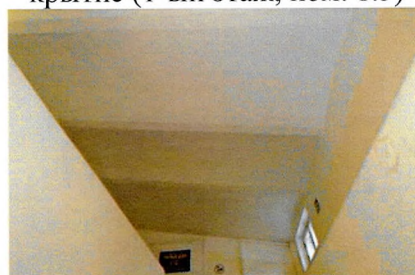
Своди по металлическим балкам (ЛК-2)
