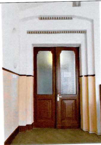
Двери между ЛК-1 и пом. 2.1
