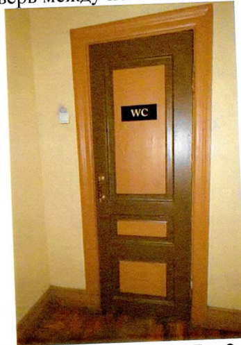
Дверь между пом. 2.17 и 2.21'
