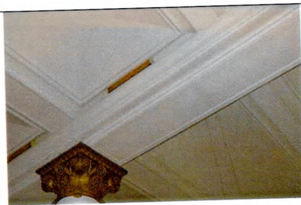
Карниз балок и декор сводов с распалубками (пом. 1.5)
