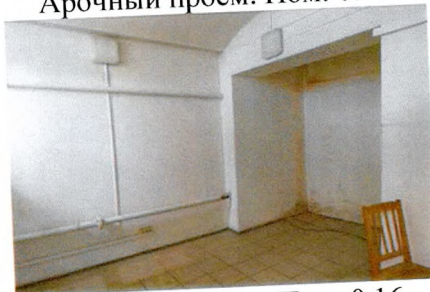
Арочный проем. Пом. 0.16
