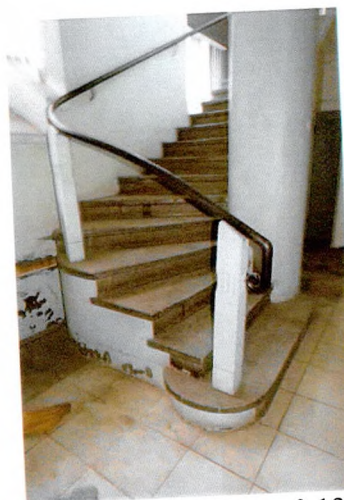
Лестница Л-5 (пом. 0.13)
