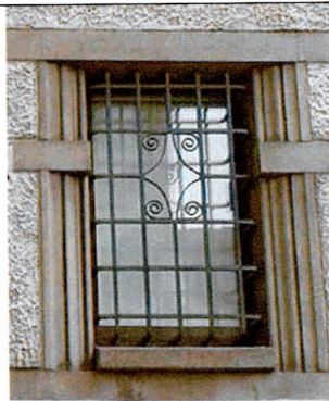
Решётки окон 1-го этажа (2 шт., уличный Ю-З фасад, угловая пониженная пристройка)
