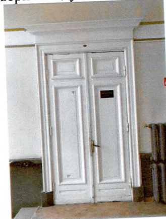
Двери между пом. 1.5 и 1.17
