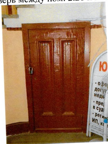
Дверь между ЛК-1 и пом. 1.7
