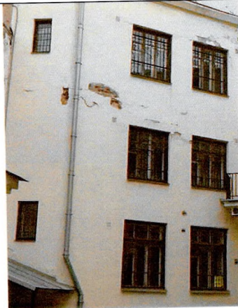
Оконные проемы трехэтажной дворовой пристройки
