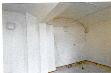
Опорные столбы, встроенные в стены (подвал, пом. 0.18)
