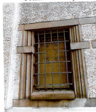
Оконный проем (уличный Ю-З фасад пристройки, 1-ый этаж – 2 шт.)
