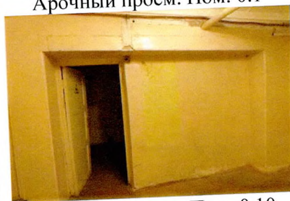
Арочный проем. Пом. 0.10
