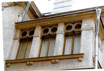
Проемы 1-го этажа (1 на лицевом Ю-В и 3 на уличном Ю-З фасадах)
