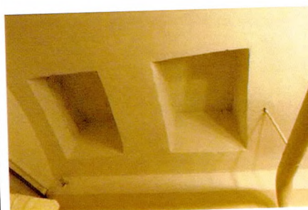
Проемы в своде (пом. 0.10)
