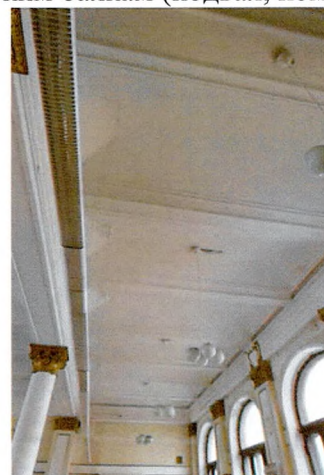
Кессонированное ж/б перекрытие (1-ый этаж, пом. 1.5)
