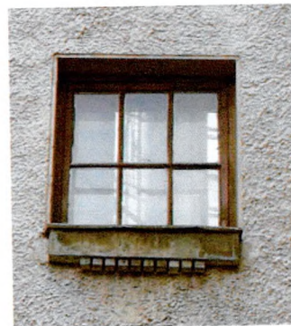
Оконный проем (уличный Ю-В фасад объема ЛК-1)
