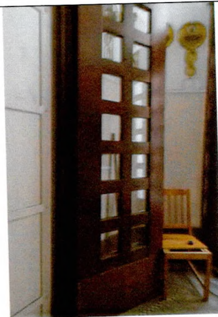
Дверь между пом. 1.1 и 1.2
