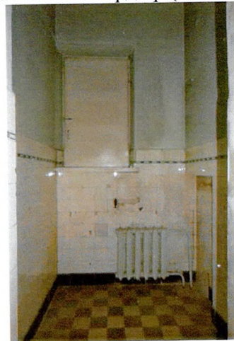
Облицовка керамической плиткой (пом. 1.14)
