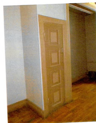
Дверь в кладовую (пом. 2.1).
