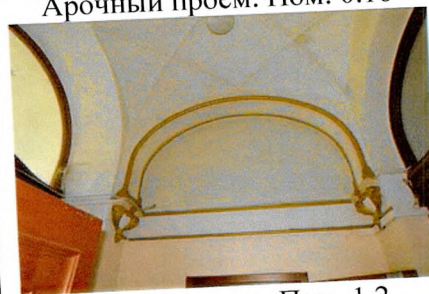
Арочная ниша. Пом. 1.2
