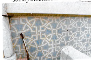
Облицовка из бетонных плиток (нижняя часть 2-го этажа лицевого Ю-В фасада)
