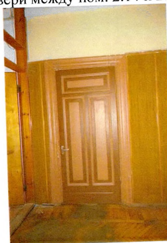
Дверь между пом. 2.14 и 2.17
