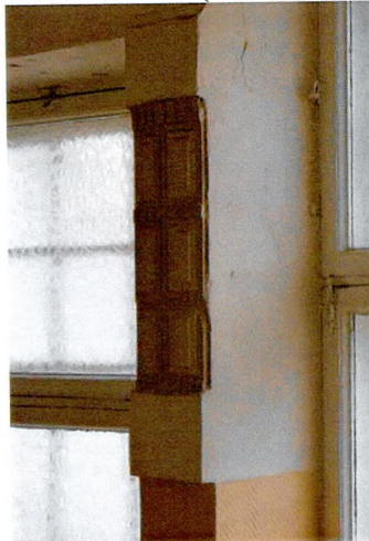
Декор простенков (ЛК-1), нижний ряд проемов
