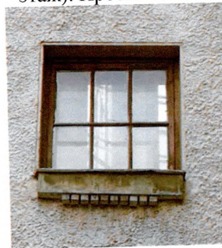
Оконный проем (уличный Ю-В фасад пристройки, над входом в ЛК-1
