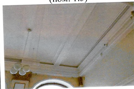
Фрагмент кессонированного потолка со сводами с распалубками (пом. 1.5, декор балок и карниз, боковой неф)
