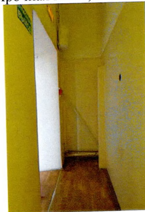
Арочный проем между пом. 2.26 и ЛК-2
