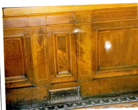
Панель бордюра с вентиляционной решеткой
