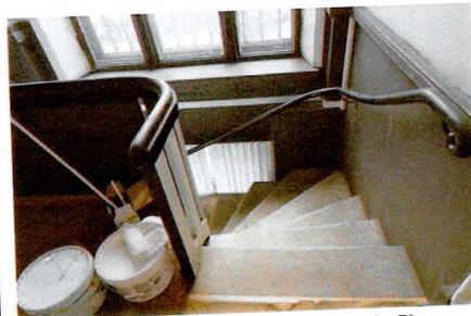
Лестница Л-5 (пом. 1.5)
