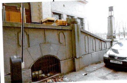
Ограждающая стена крыльца
