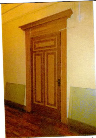
Дверь между пом. 2.17 и 2.20;
