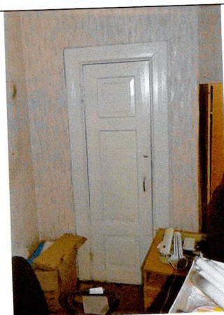
Дверь в кладовую (пом. 2.20)
