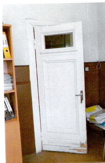
Дверь между пом. 2.11 и 2.12
