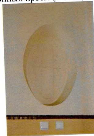
Оконный проем (2 этаж, ЛК-1)
