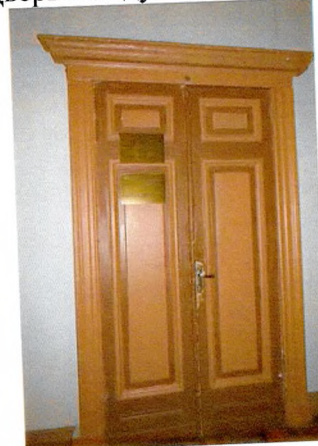
Дверь между пом. 2.9 и 2.13
