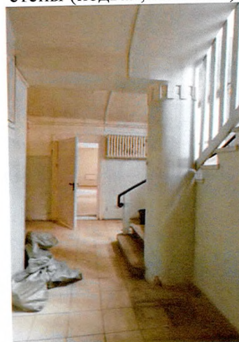
Опорный столб (подвал, пом. 0.13)
