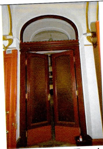
Арочный проем. Пом. 1.2
