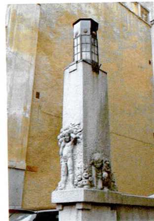
Крайний пилон крыльца
