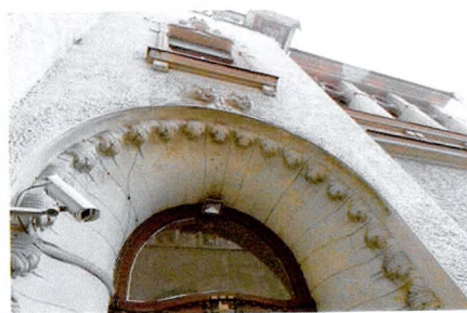
Главный вход (уличный Ю-З фасад)
