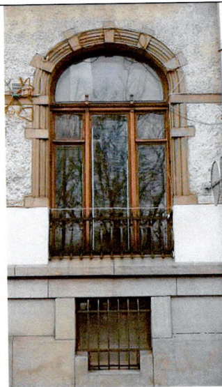
Оконные проемы (лицевой Ю-В фасад, подвал, 1-ый этаж)
