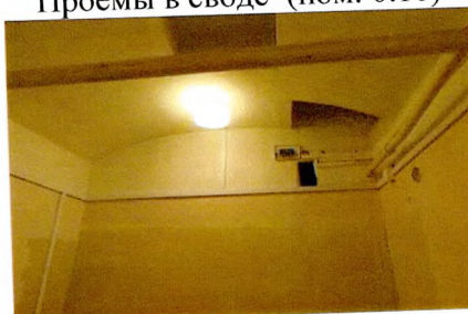
Проемы в своде (пом. 0.11)
