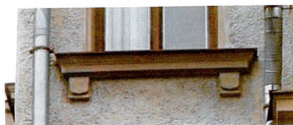
Подоконная тяга с консолями (лицевой Ю-В и уличный Ю-З фасады)
