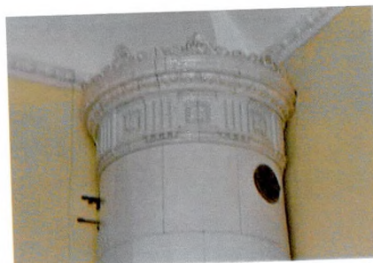
Венчающий карниз печи, пом. 2.20
