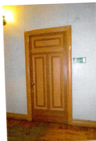
Дверь между пом. 2.2 и 2.7
