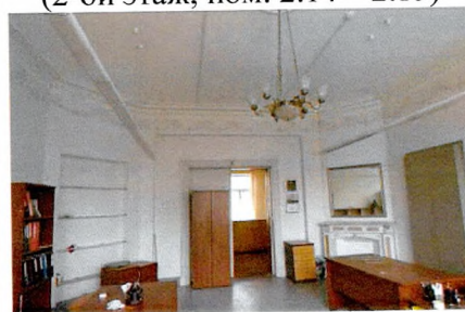
Плоское деревянное перекрытие (2-ой этаж, пом. 2.16)
