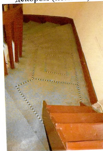
Мозаичный бетонный пол с декором (ЛК-1, промежуточная площадка)
