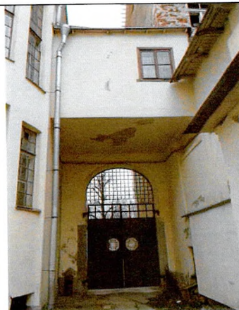
С-З фасад стены и висячей надстройки
