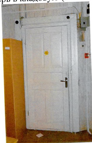
Дверь между пом. 2.28 и ЛК-2
