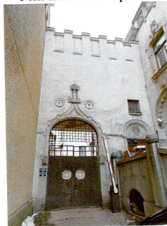
Уличный Ю-В фасад пристройки и стены с воротами
