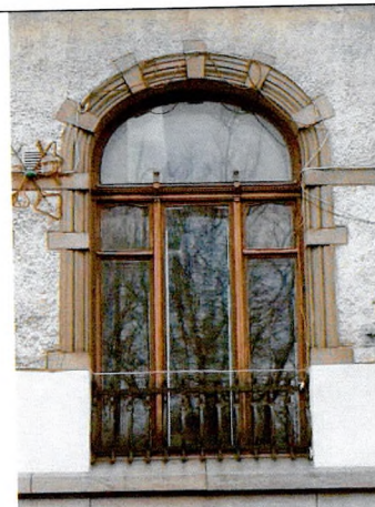
Оконный проем 1-го этажа (лицевой Ю-В фасад)
