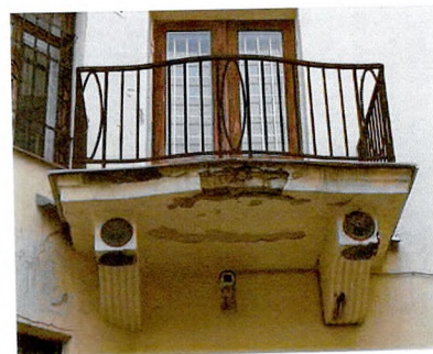
Балкон (дворовый Ю-3 фасад)
