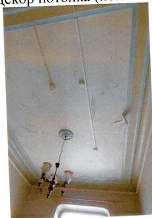
Карниз с паддугой (пом. 2.25)
