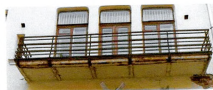
Балкон (дворовый С-3 фасад)
