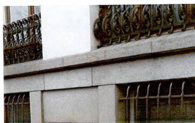
Подоконный карниз (цоколь, лицевой Ю-В фасад)
