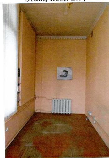
Плоское монолитное перекрытие (2-ой этаж, пом. 2.8)
