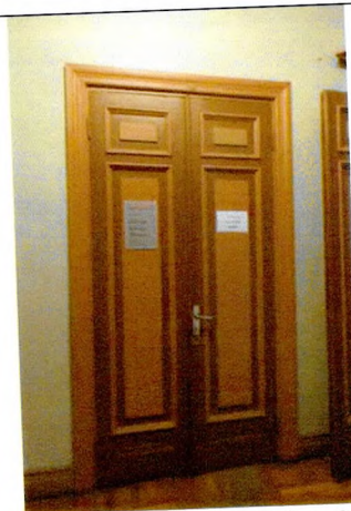
Дверь между пом. 2.9 и 2.10;
