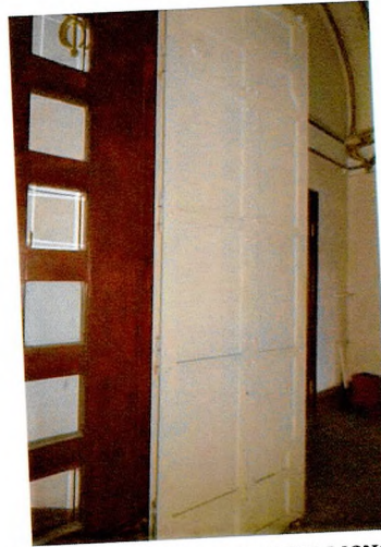
Металлические двери между пом. 1.1 и 1.2. Наружная сторона
