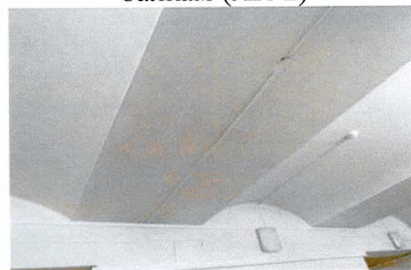
Совмещенные перекрытия (подвал, пом. 0.16)
