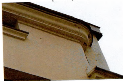
Венчающий карниз дворовых фасадов
