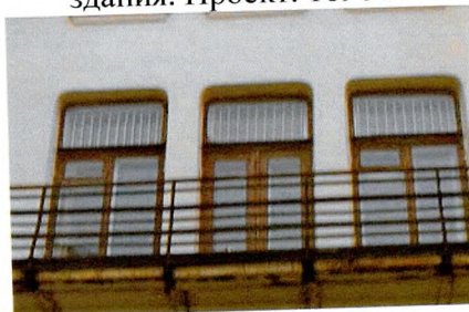
Оконные и дверной проемы (дворовой С-3 фасад, 2-ой этаж, балкон)
