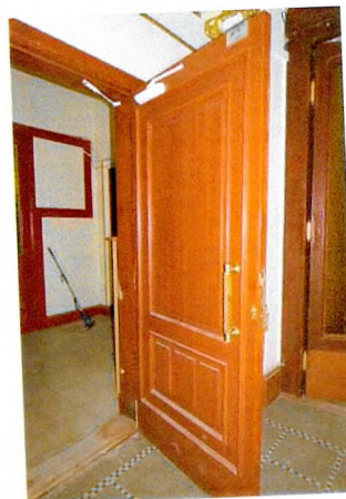
Дверь между пом. 1.2 и 1.9
