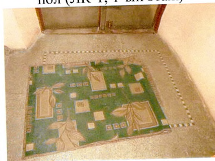
Мозаичный бетонный пол с декором (пом. 1.6)
