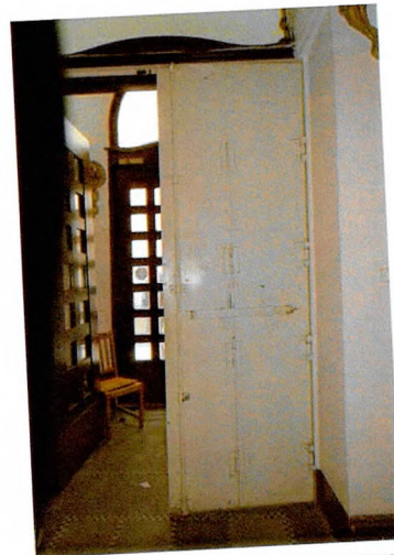
Металлические двери между пом. 1.1 и 1.2. Внутренняя сторона
