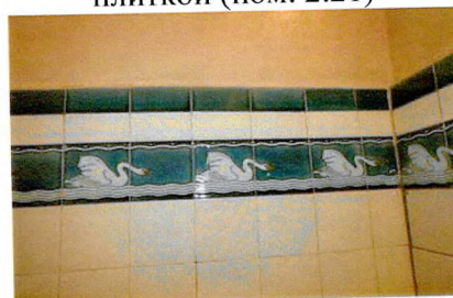
Облицовка керамической плиткой (пом. 2.21)
