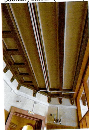
Кессонированный потолок (пом. 2.14 – 2.15)
