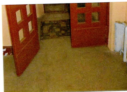
Простой мозаичный бетонный пол (ЛК-1, 1-ый этаж)
