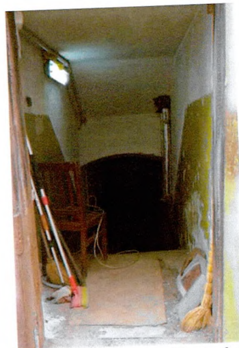
Арочный проем. Пом. 0.1
