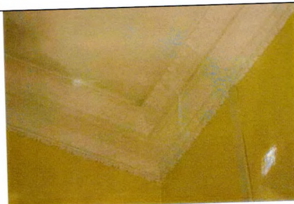
Декор потолка (пом. 1.17)
