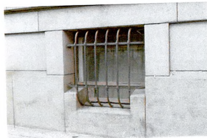
оконные решетки подвальных окон (лицевой Ю-В фасад)
