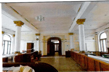
Колонны (1-ый этаж, пом. 1.5)
