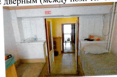
Оконные проемы, совмещенные с дверным (между пом. 1.9-1.10)
