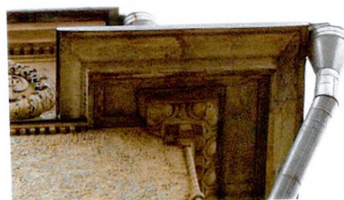
Венчающий карниз (уличные Ю-В и Ю-З фасады заглубленной части)
