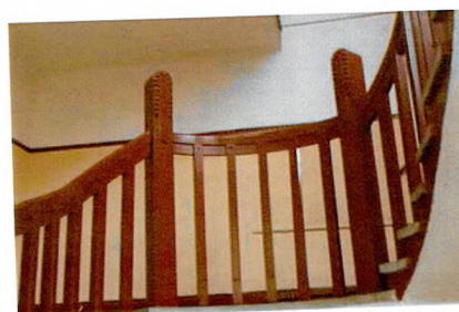
Ограждение лестницы ЛК-1
