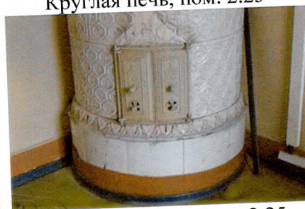
Основание печи, пом. 2.25
