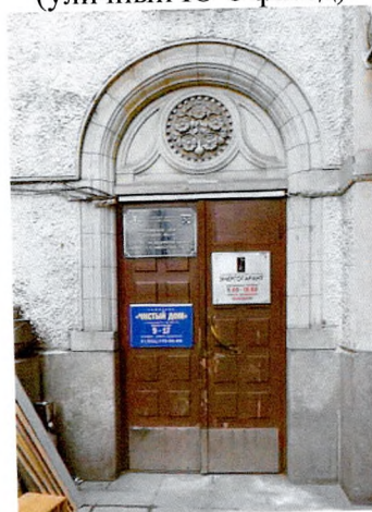
Портал входа в объем ЛК-1 (уличный Ю-В фасад, пристройка)
