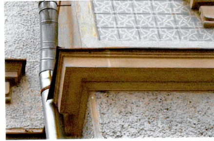
Межэтажный карниз (лицевой Ю-В и уличный Ю-3 фасады)
