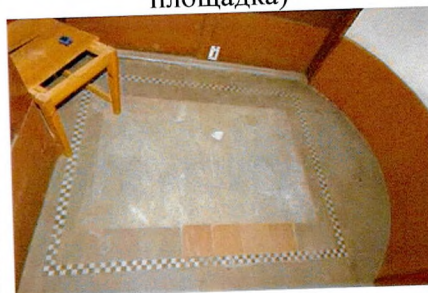
Пол из керамических плиток с декором (пом. 1.1)
