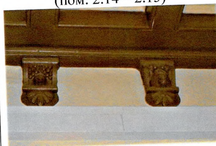
Консоли кессонированного потолка (пом. 2.14-2.15)
