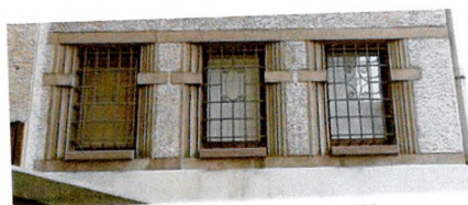
Проемы 1-го этажа (1 на лицевом Ю-В и 3 на уличном Ю-З фасадах)
