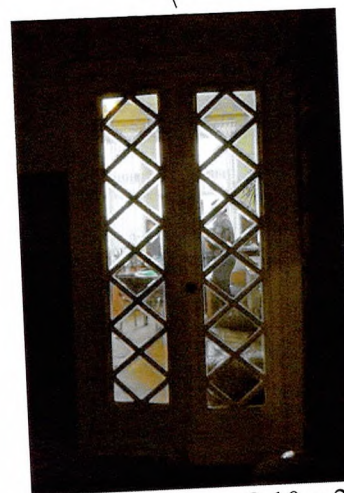
Дверь между пом. 2.10 и 2.12
