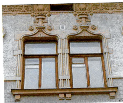
Оконные проемы 2-го этажа (лицевой Ю-В фасад и 1 проема на уличном Ю-З фасаде)
