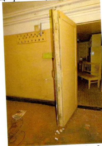
Дверь между пом.0.8 - 0.9
