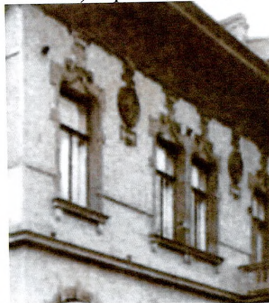
Оконные проемы (лицевой Ю-В и уличный Ю-З фасады, 2-ой этаж). Фото (копия) 1930-х гг.
