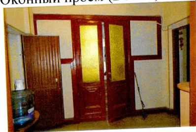
Оконные проемы, совмещенные с дверным (между пом. 1.9-1.10)
