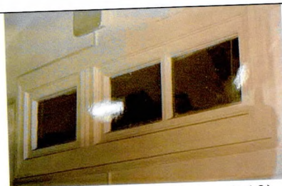
Оконный проем (пом. 0.13). Фото 2003 г.
