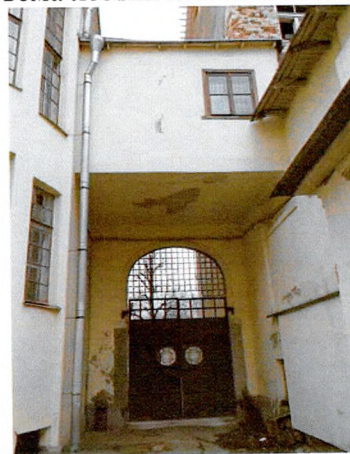
Дворовые фасады навесной надстройки и стены с воротами
