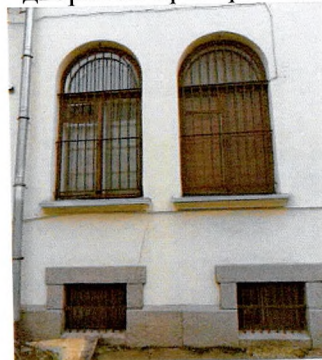
Оконные проемы (дворовой С-3 фасад, подвал, 1-ый этаж)
