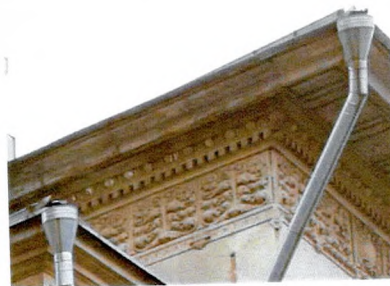
Венчающий карниз (уличные Ю-З и Ю-В фасады заглубленной части)
