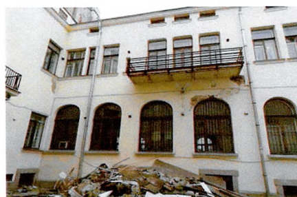
С-3 дворовый фасад (левая часть)
