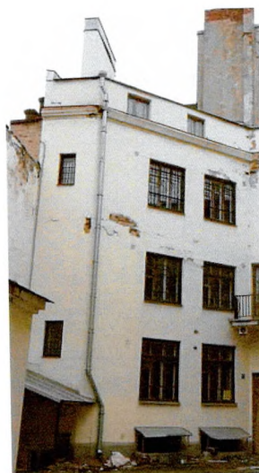
Фасады дворовой пристройки
