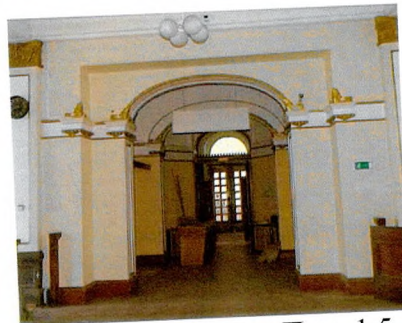
Арочные проемы. Пом. 1.5
