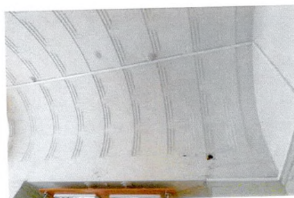
Кессонный потолок свода (пом. 1.15, 1.16)
