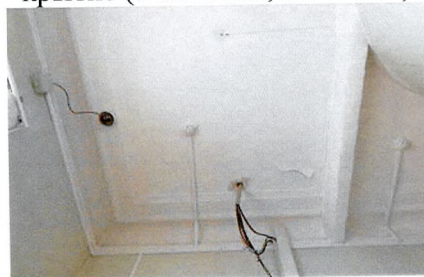
Плоское монолитное перекрытие по балкам(2-ой этаж, пом. 2.5)
