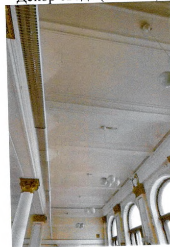
Кессонированный потолок (пом. 1.5)
