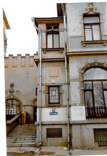
Фасад левой части лицевого Ю-В фасада
