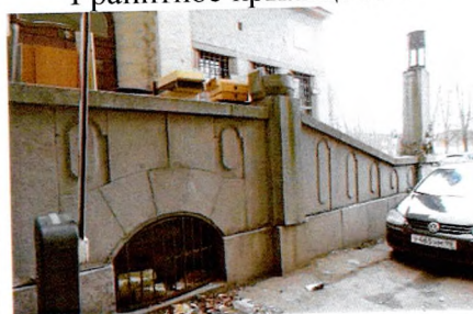
Ограждение крыльца Л-1
