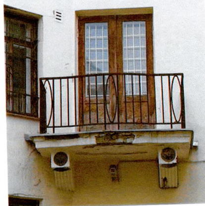
Балкон (дворовый Ю-З фасад)
