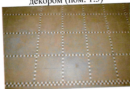
Пол из керамических плиток с декором (пом. 1.4)
