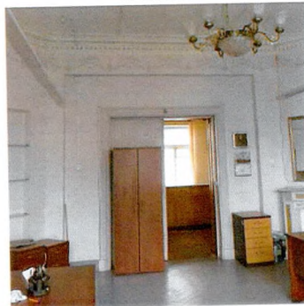
Арочная ниша дверного проема между пом. 2.14 и 2.16
