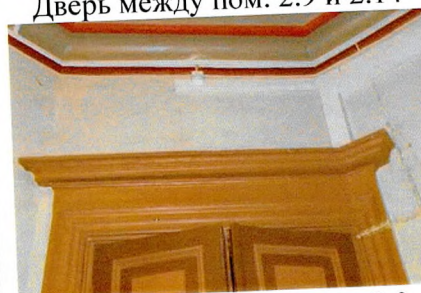
Карниз двери между пом. 2.9 и 2.14
