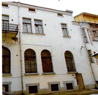
Дворовой С-З фасада (правая часть)
