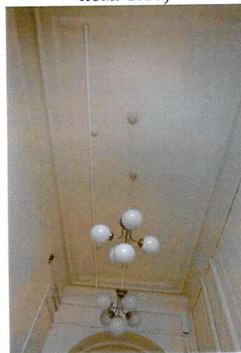
Плоское монолитное перекрытие (1-ый этаж, пом. 1.12)
