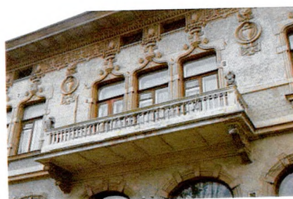
Балкон (лицевой Ю-В фасад)
