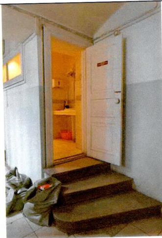
Лестница Л-6, пом. 0.13
