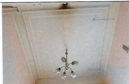
Плоское перекрытие (1-ый этаж, пом. 1.10)
