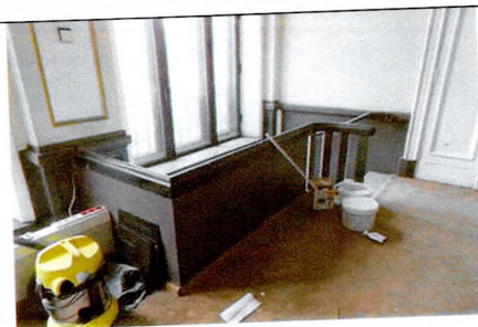
Лестница Л-5, ограждение
