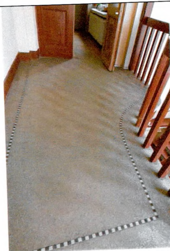
Мозаичный бетонный пол с декором (ЛК-1, верхняя площадка)
