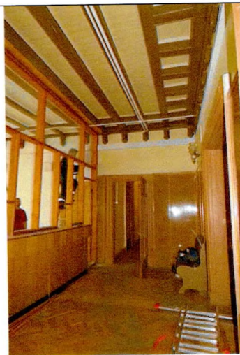
Плоское деревянное перекрытие (2-ой этаж, пом. 2.14 – 2.15)
