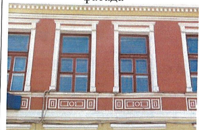
Обрамление проемов 2-го этажа лицевых С-В и С-З фасадов
