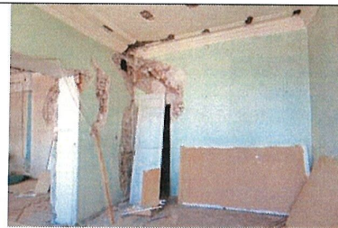
Пом. 2.16. Кирпичные стены
