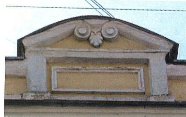
Сохранившийся фрагмент фронтона аттика ( навершие утрачено )
