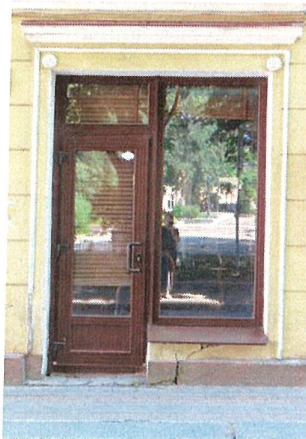
Обрамление проема 1-го этажа. С-З фасад
