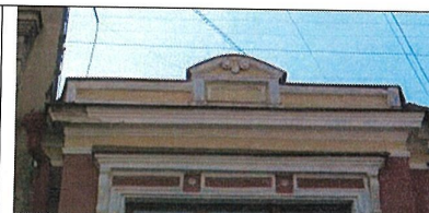
Аттик (левая часть лицевого С-В фасада)
