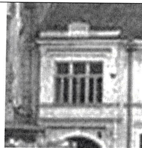
Расстекловка оконного проёма 2-го этажа в левой части лицевого С-В фасада. Фото (копия) 1964 г.
