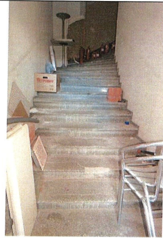
ЛК-1, бетонная лестница
