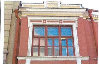
Обрамление проема в левой части 2-го этажа лицевого С-В фасада
