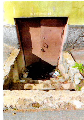
Спуск в подвал (дворовый Ю-В фасад)
