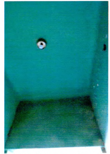
Плоское ж/б перекрытие (главный вход)
