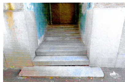
Лестница главного входа
