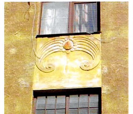
Орнамент между проемами 2-го и 3-го этажей (С-З фасад; Ю-З фасад – 1 ось)
