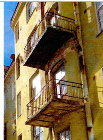
Балконы (Ю-В дворовый фасад)
