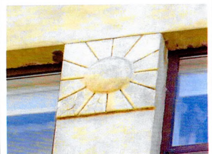
Рельефный орнамент в простенках проемов 4-го этажа (С-3 фасад)
