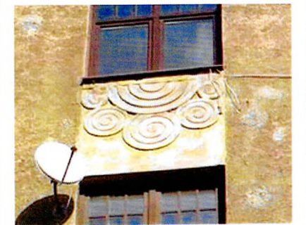
Орнамент между проемами 3-го и 4-го этажей (С-З фасад – 8-ая ось; Ю-З фасад – 1-ая ось)
