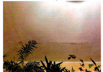
Плоское ж/б перекрытие (квартира 4-го этажа в восточной части здания)
