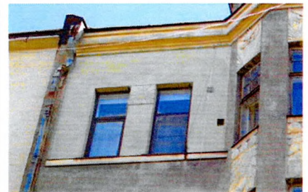
Межэтажная тяга и венчающий карниз
