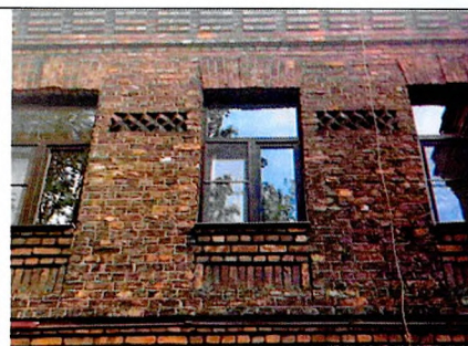
Оконные проемы боковых частей С-З и Ю-В фасадов (2-ой этаж)
