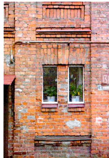
Оконные проемы С-З ризалита (1-ый этаж)
