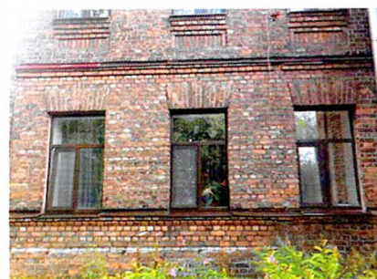
Оконные проемы боковых частей С-З и Ю-В фасадов (1-ый этаж)
