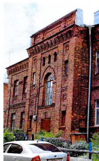
Фасады Ю-В ризалита
