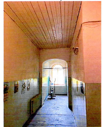
Плоское перекрытие (коридор 2-го этажа)
