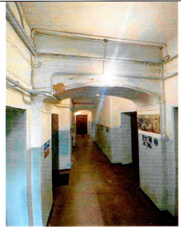
Плоское перекрытие (коридор 1-го этажа)
