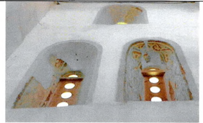
откосы северной стены
