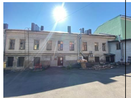
Дворовый С-З фасад (правая часть)
