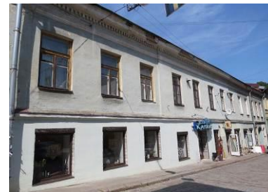
Лицевой Ю-В фасад
