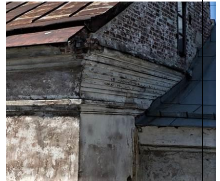
Венчающий карниз (уличный С-З и боковой С-В фасады основного объема здания)
