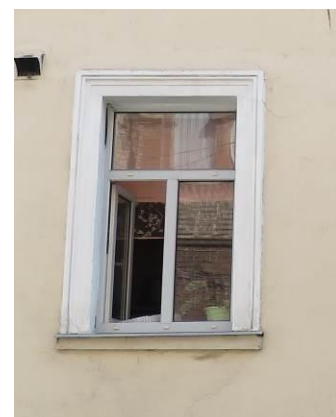
Оформление оконного проема 1-го этажа (уличный С-З фасад)
