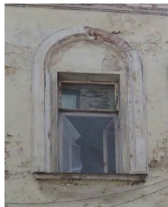
Оформление оконного проема 2-го этажа (уличный С-З фасад)
