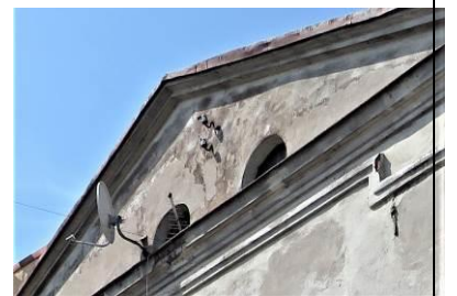
Карниз фронтона ризалита (дворовой фасад)
