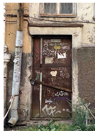
Оформление дверного проема (уличный С-З фасад)
