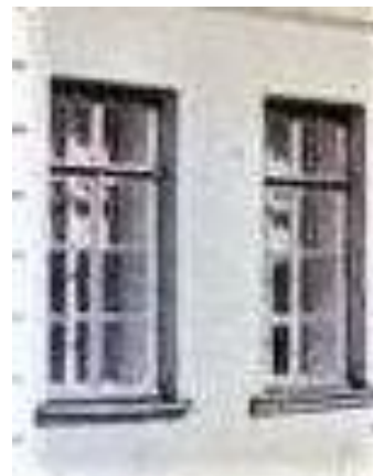
Подоконные тяги (проемы дворового фасада). Фрагмент фото (копия) 1922 г.
