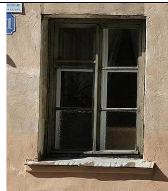
Подоконная тяга (проем 1-го этажа, лицевой фасад)
