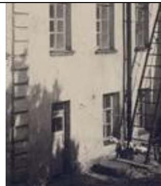
Фрагмент дворового фасада. Фото (копия) 1922 г.
