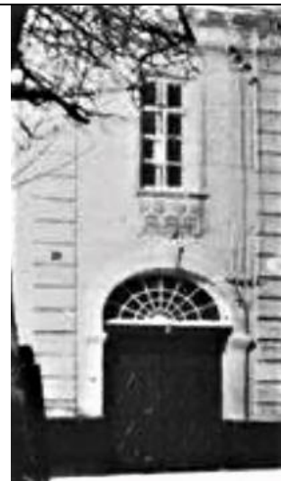
Оформление арочного проема и оконного проема (лицевой фасад). Фрагмент фото (копия) 1930-х гг.
