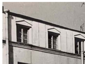
Оформление проемов 5-го этажа (лицевой фасад)
