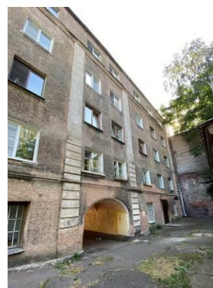
Лопатки (дворовый фасад)
