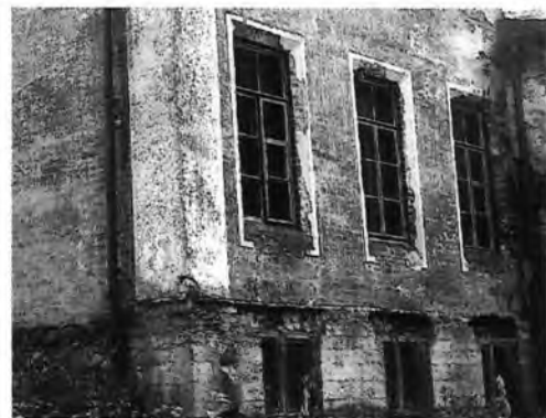
Фрагмент лицевого фасада
