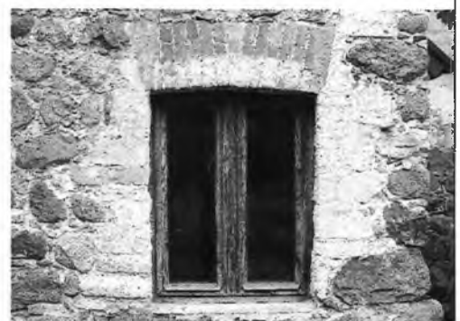
Оконный проем пристройки
