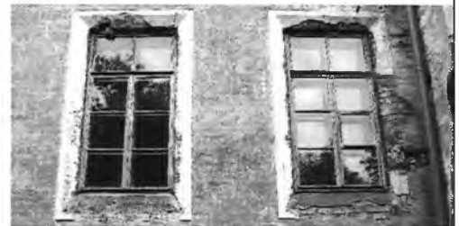
Оконные проемы 1-го этажа
