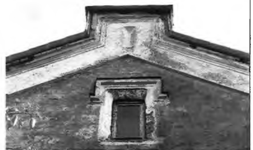
Оконный проем одноэтажного объема, северный фасад
