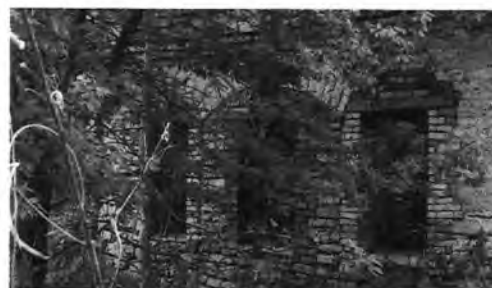
Фрагмент южного фасада. Левая часть.
