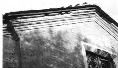
Венчающий карниз западного фасада
