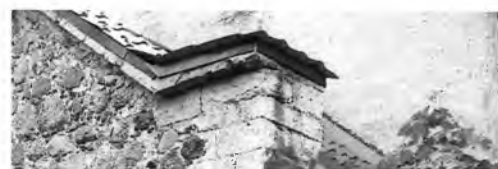
Венчающий карниз фасада восточной пристройки
