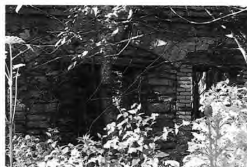
Фрагмент южного фасада.
