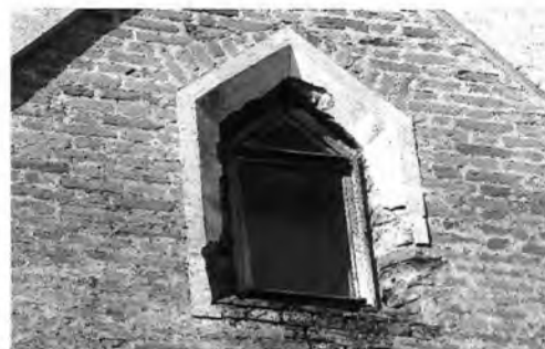
Оконный проем чердачного помещения двухэтажного объема, южного фасада
