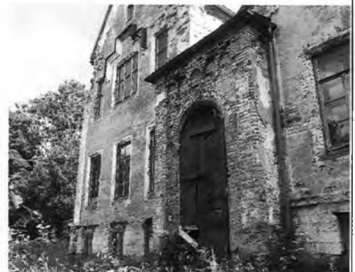
Выделение креповками объема центрального входа
