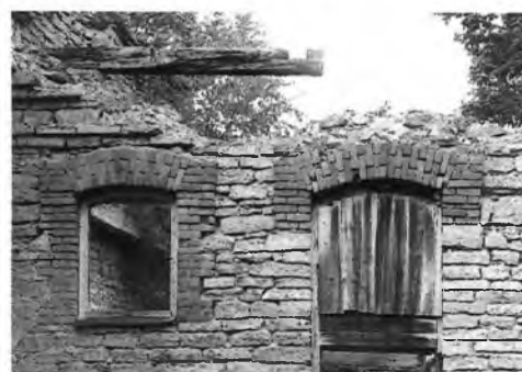
Фрагмент южного фасада. Правая часть
