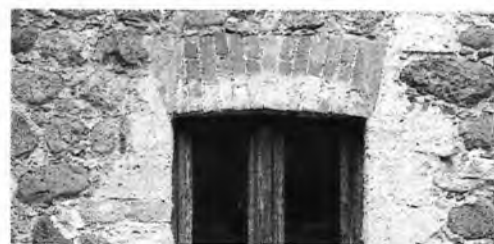
Фрагмент отделки фасада
