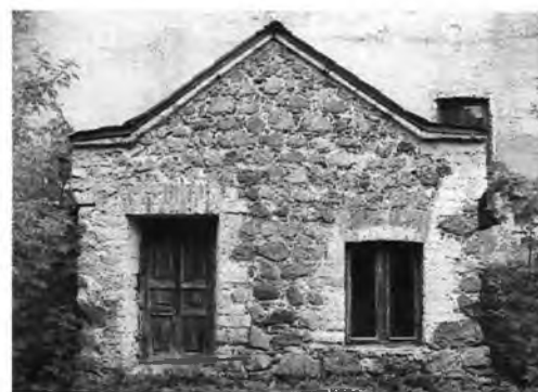
Архитектурная композиция восточного фасада пристройки
