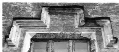
Оформление проема 2-го этажа двухэтажного объема по центральной оси северного фасада
