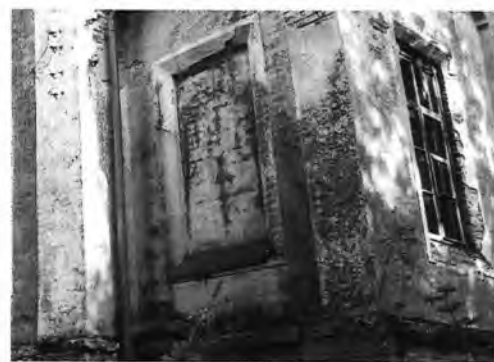
Фрагмент отделки фасада
