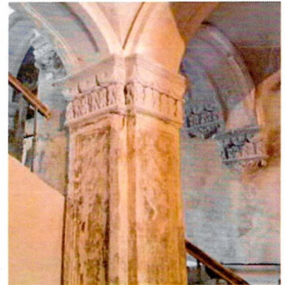
Колонна (холл 1-го этажа). Фото при производстве реставрационных работ
