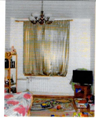
Плоское перекрытие (квартира, С-В часть 1-го этажа)
