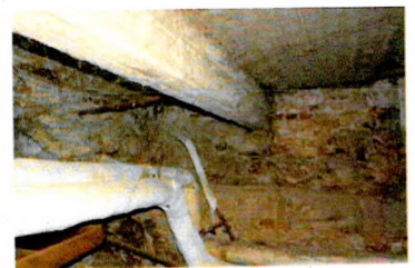
Плоское перекрытие (помещение в Ю-З части подвала)
