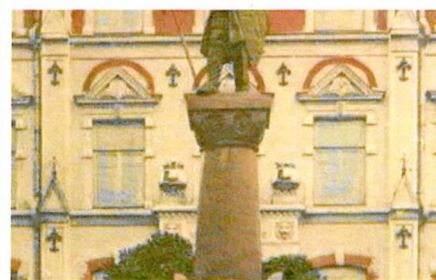
Анкерные скрепы на лицевом фасаде
