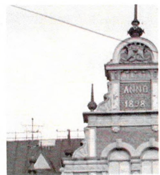
Центральный ступенчатый фронтон (лицевой фасад). Фрагмент фото (копия) 1935 г.
