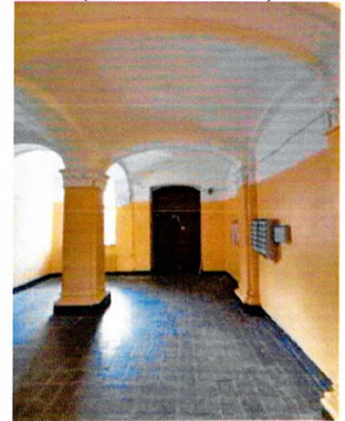
Крестовый свод, совмещенный с арками (холл 1-го этажа)
