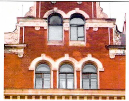
Проемы центрального фронтона (лицевой фасад)
