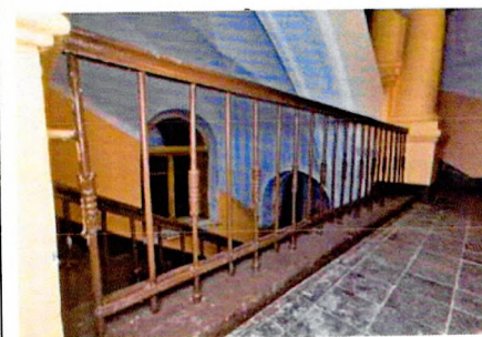
Историческое ограждение лестничного марша ЛК
