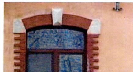
Оконные проемы 1-го этажа (уличные фасады)
