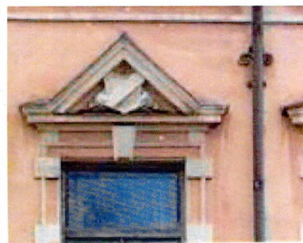
Оконные проемы 2-го этажа (уличные фасады)
