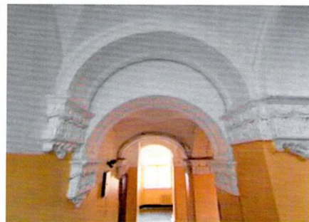
Оформление арок (холл 1-го этажа и центральная ЛК)
