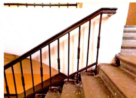
Историческое ограждение лестничного марша ЛК
