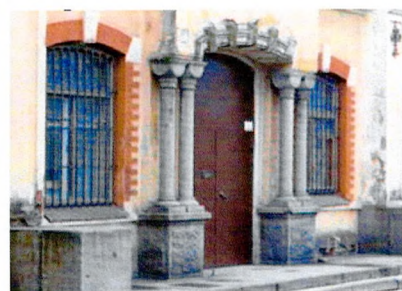
Главный вход. Лицевой фасад. Колонны портала
