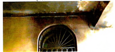
Плоское монолитное ж/б перекрытие сквозного арочного проезда
