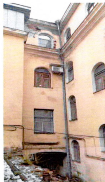
Дворовый С-В фасад южного крыла
