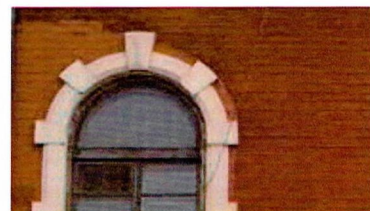
Оконные проемы 3-го этажа (уличные фасады)
