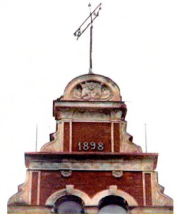
Верхняя часть центрального ступенчатого фронтона (лицевой фасад)
