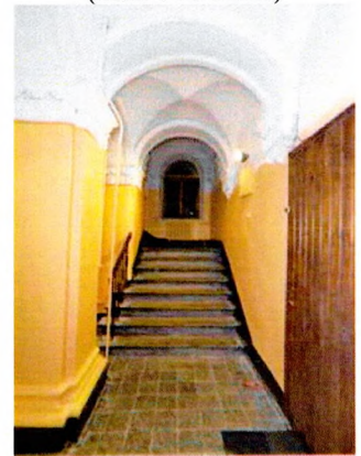
Крестовые своды, совмещенные с арками (холл 1-го этажа)
