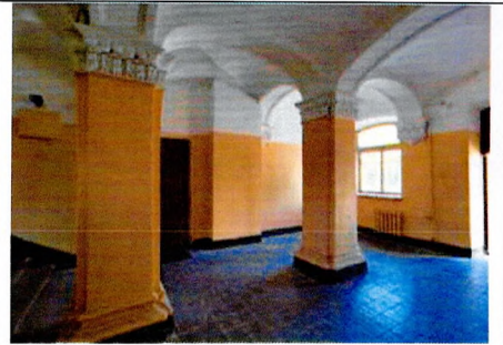
Крестовые своды, совмещенные с арками (холл 1-го этажа)
