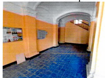
Центральный холл (1-ый этаж). Трехцентровые пониженные арки
