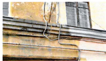
Межэтажный карниз (Ю-В фасад дворового С-3 крыла)
