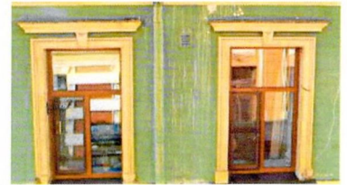
Оформление оконных проемов 3-го яруса. Лицевой Ю-В фасад
