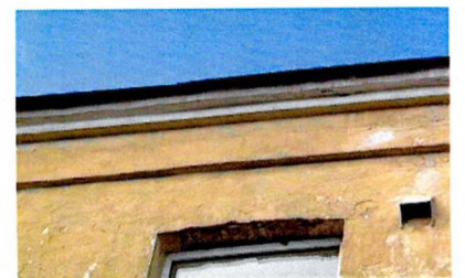
Ю-В фасад С-З дворового крыла
