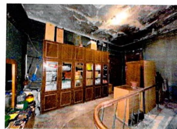
Помещение ЛК в южной части главного дома. 2-ой этаж
