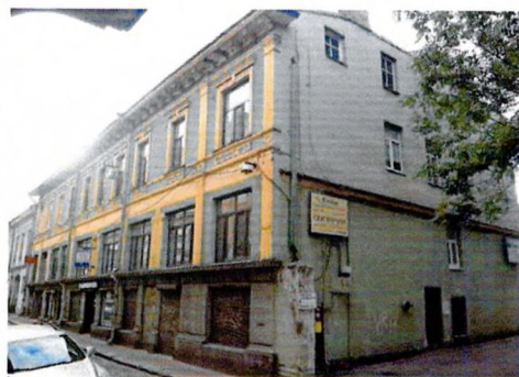
Лицевой Ю-В фасад
