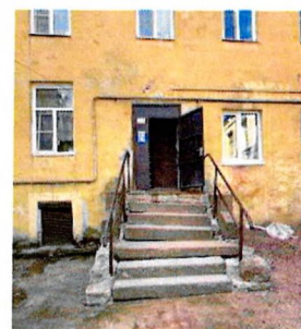
Гранитное крыльцо. С-В фасад дворового западного крыла
