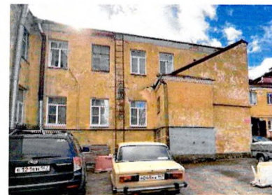
Дворовый С-В фасад Ю-3 крыла главного дома
