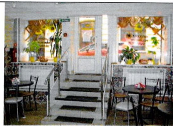
Лестница в помещении цокольного этажа центральной уличной части главного дома
