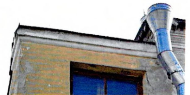
Венчающий карниз (двухэтажный объем пристройки к дворовому западному ризалиту главного дома)
