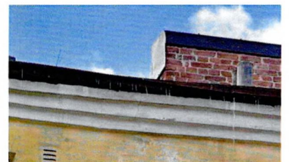
Венчающий карниз (С-В фасад дворовой западной пристройки)
