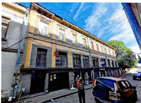
Лицевой Ю-В фасад
