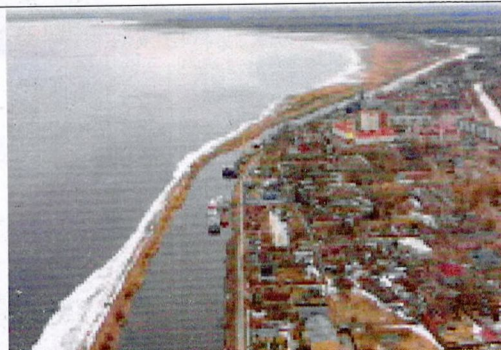
4. Панорама канала и дамбы в г. Шлиссельбург. Устье канала.
