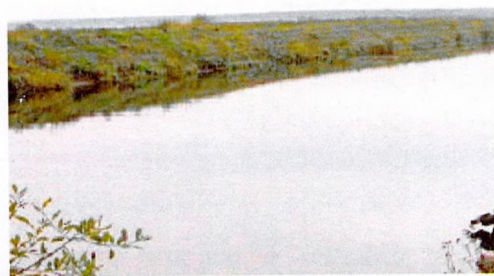
21. Фрагменты берегоукрепления на трассе канала
