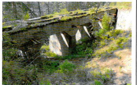
Общий вид бетонной конструкции основания с арками для ж.-д. полотна и парового козлового крана
