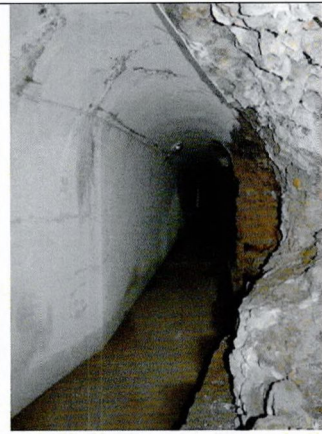
Потерна под бруствером батареи у орудийного двора № 3
