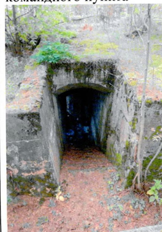
ГКП 3. Западный выход из командного пункта
