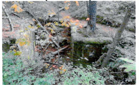
ОП-7. Убежище для противотанковых пушек № 18. Спуск в бетонированную траншею
