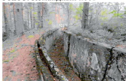
ГКП 3. Бетонированная стрелковая траншея на крыше группового командного пункта
