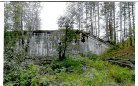
Северо-западная часть батареи
