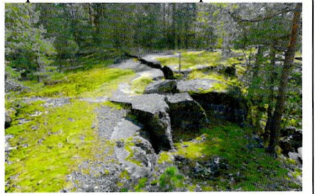
Бронебетонная крыша батареи у второй башенной орудийной установки
