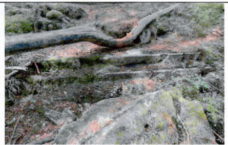
ОП-7. Убежище для противоштурмовых пушек № 18. Бетонные ступеньки спуска в траншею
