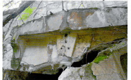
Фронтон входного проема (фрагмент)
