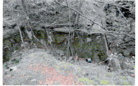
ОП-7. Убежище для дежурных частей на 45 человек пехоты № 17. Бетонированная траншея
