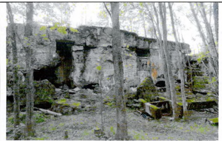
Юго-восточная часть тыльного фасада батареи со стороны горжи
