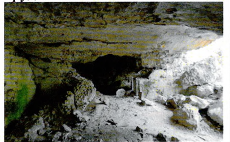
Казематы бруствера правого фланга батареи
