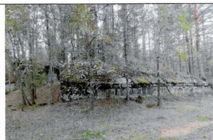
ГКП 1. Фото с северо-востока
