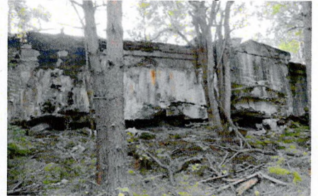
Правый фланг. Тыльная стена батареи
