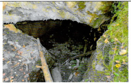
Открытый при разрушении каземат во втором оружейном дворике
