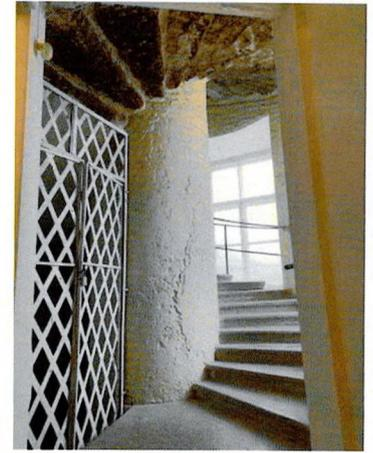
Винтовые лестницы в Часовой и Сигнальной башнях – из цельнотесанных каменных профилированных известняковых ступеней вместе с осевыми центрально расположенными столбами.
