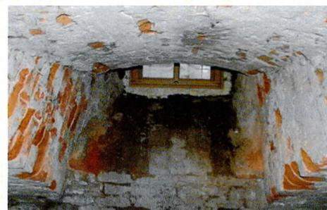
Перемышки оконных и дверных проемов: кирпичные, арочные.
