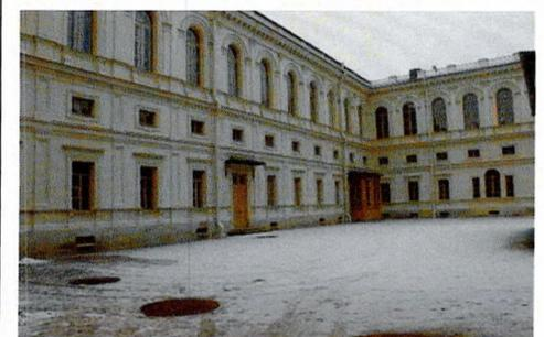
известняковых блоков, окрашены, оконные проемы 3-го этажа – арочные, полуциркульные,
