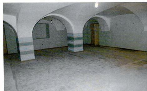
цилиндрические, с распалубками над оконными проемами, поверх оштукатурены и окрашены.
