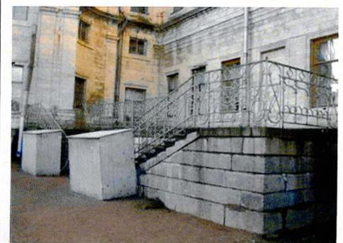
из известняка на известковом растворе, трапециевидной и прямоугольной формы, с уступами и без уступов, различной ширины с включениями валунных участков.
