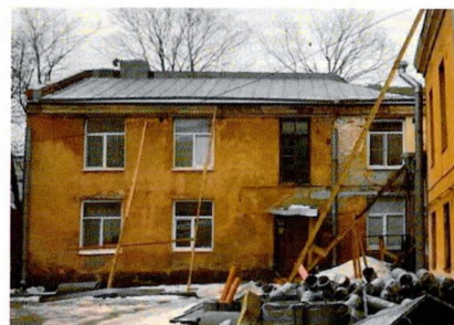
Ю-З фасад С-В дворового флигеля
