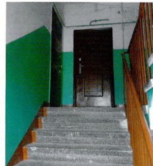
ЛК-2. Бетонное мозаичное покрытие ступеней
