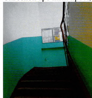
ЛК-1 (Ю-В часть главного корпуса)
