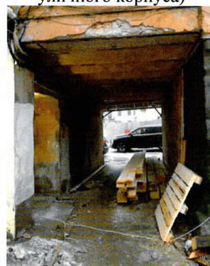
Кирпичные своды «монье». Сквозной арочный проезд
