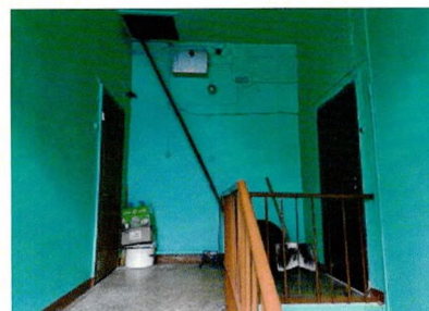
ЛК-4. Бетонное мозаичное покрытие верхней площадки. Металлическое ограждение
