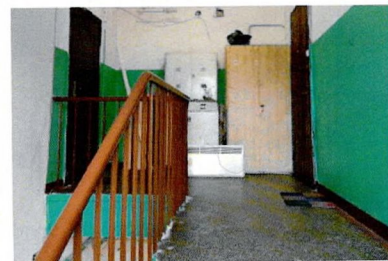
ЛК-5. Бетонное мозаичное покрытие верхней площадки. Металлическое ограждение
