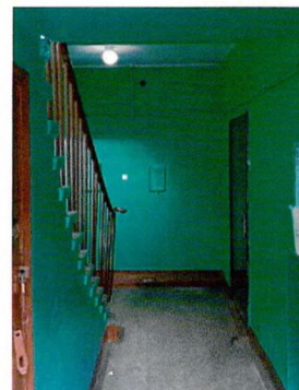
ЛК-3. Бетонное мозаичное покрытие входной площадки. Металлическое ограждение
