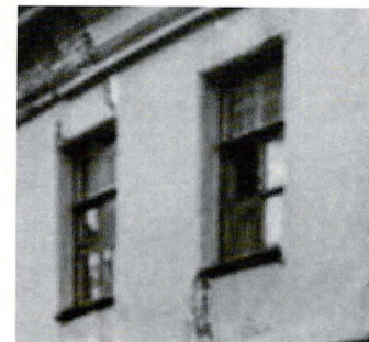
Рисунок расстекловки проёмов. Фрагмент уличного фасада. Фото (копия) 1939 г.
