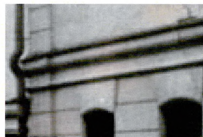
Фрагмент уличного Ю-З фасада. Межэтажный карниз. Фото (копия) 1939 г.
