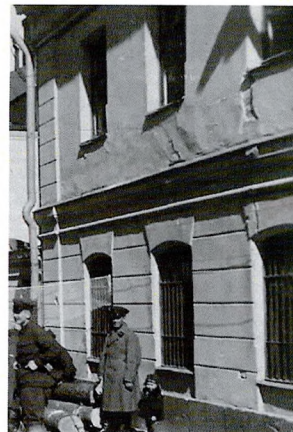
Фрагмент уличного Ю-З фасада Рустованные угловые лопатки и основная плоскость фасада 1-го этажа
