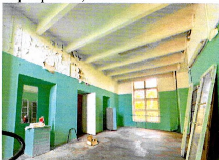
2-ой этаж. Холл. Плоское ж/бребристое перекрытие, кирпичные стены
