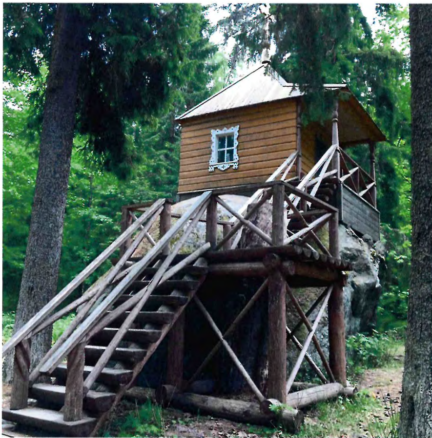
«Успенская часовня на Конь-камне», 1815 г. (памятник): Ленинградская область, Приозерский район, п/о Владимировка, о. Коневец, лит. Ю;
