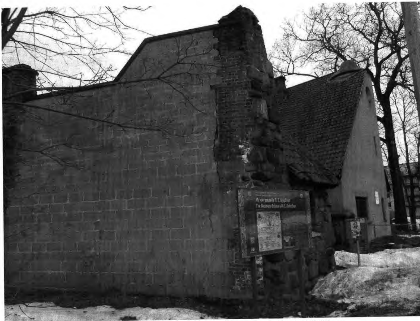
Фрагмент южного и восточного фасадов, вид с юго-востока.
