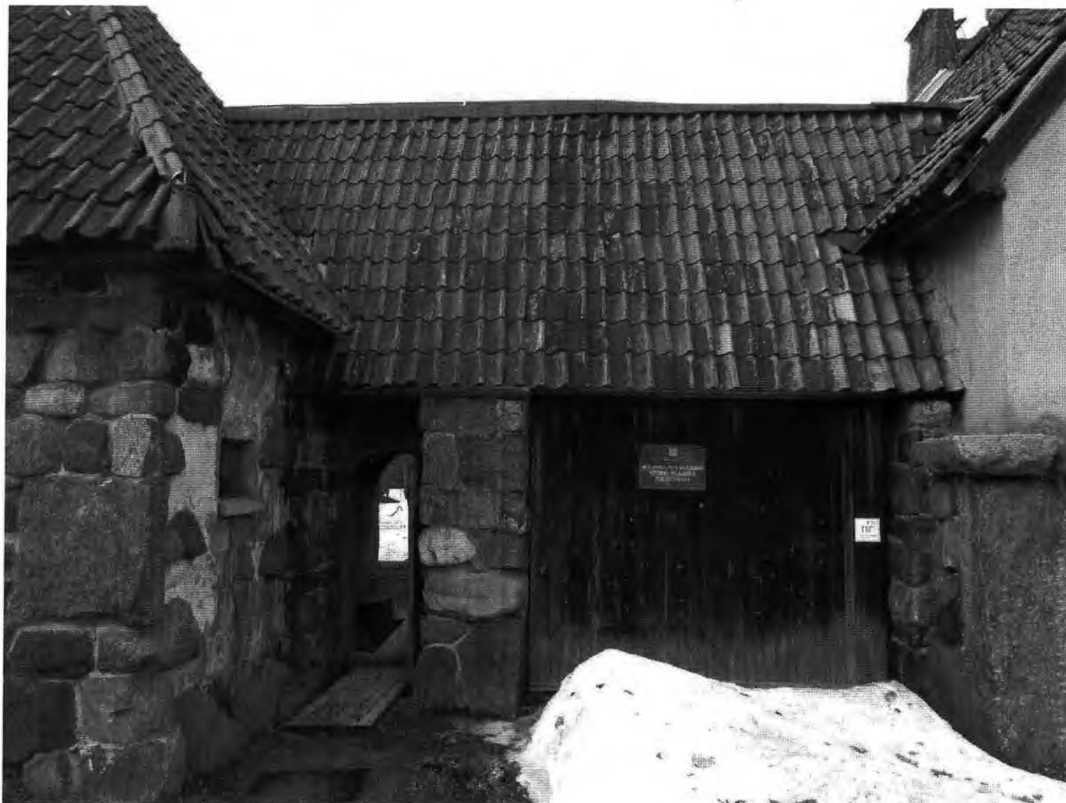
Фрагмент восточного фасада, вид с востока.
