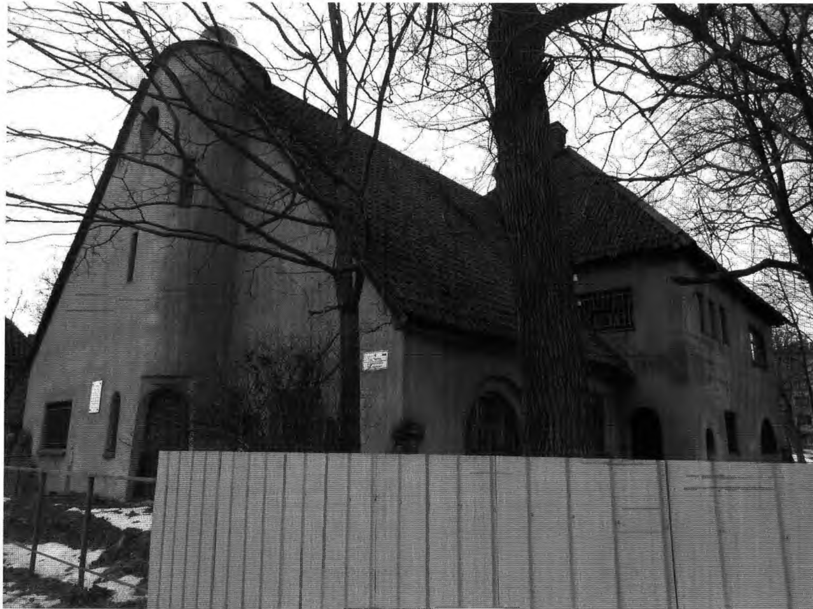
Фрагмент восточного и северного фасадов, вид с северо-востока.
