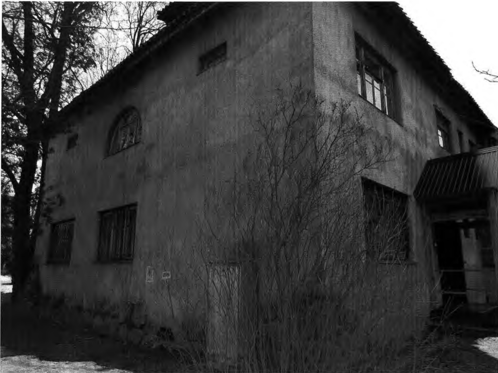
Фрагмент западного и южного фасадов, вид с юго-запада.
