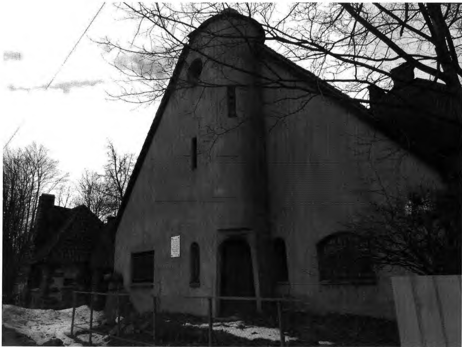
Фрагмент восточного фасада, вид с северо-востока.
