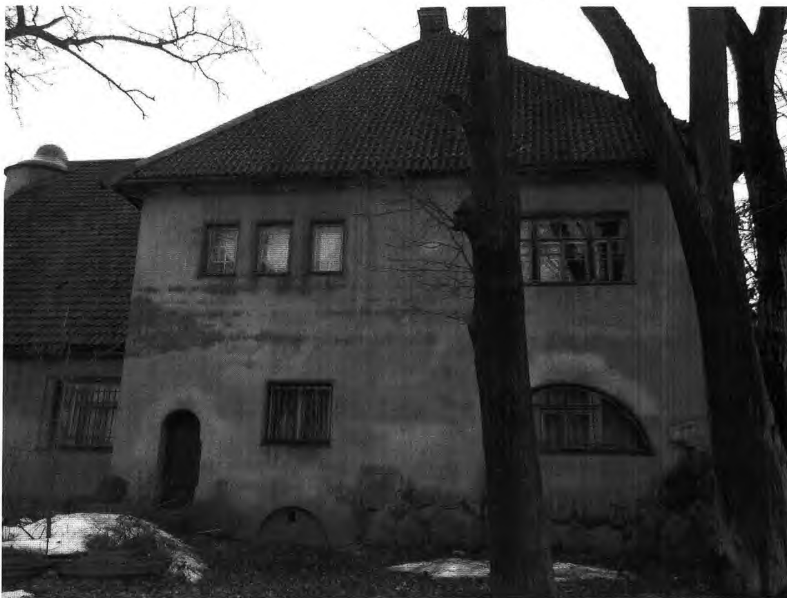
Фрагмент северного фасада, вид с севера.
