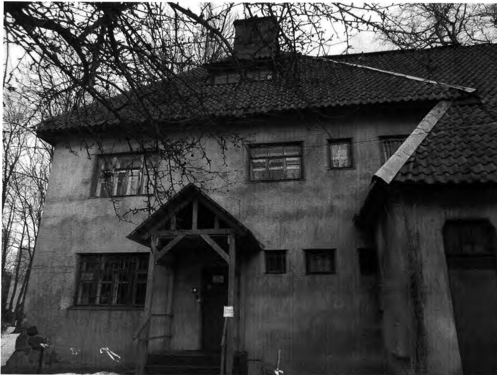
Фрагмент южного фасада, вид с юга.
