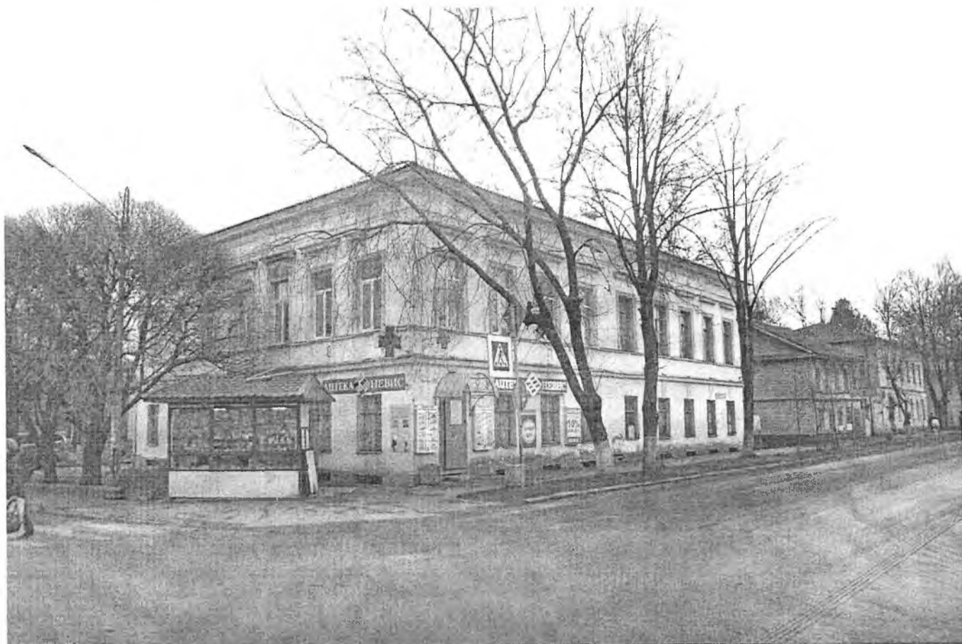
Общий вид объекта культурного наследия «Здание городского училища». Вид с севера.
