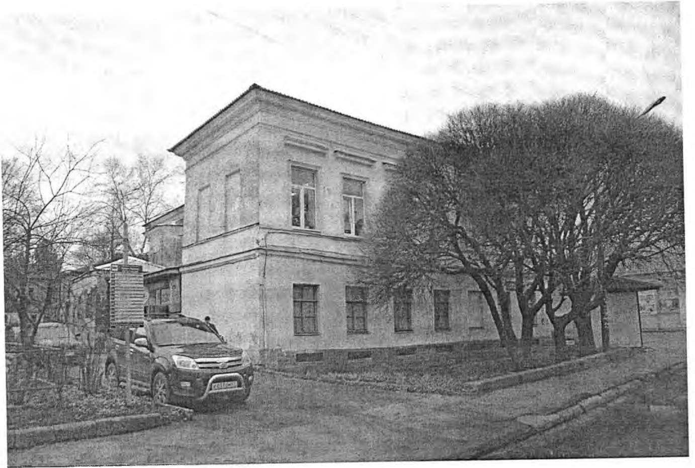
Северный фасад. Вид с востока.
