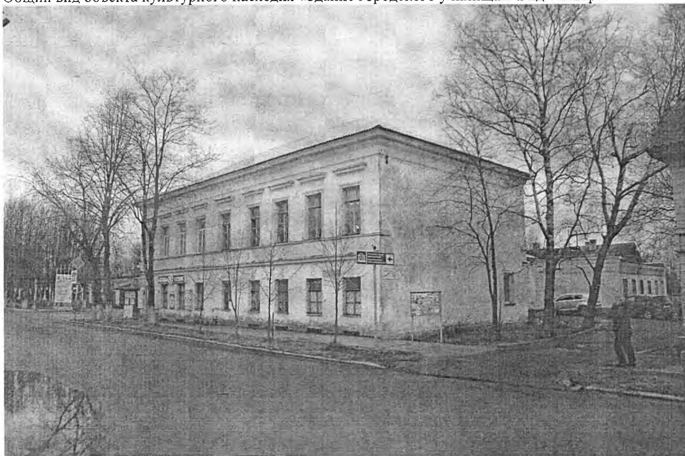
Общий вид объекта культурного наследия «Здание городского училища». Вид с запада.
