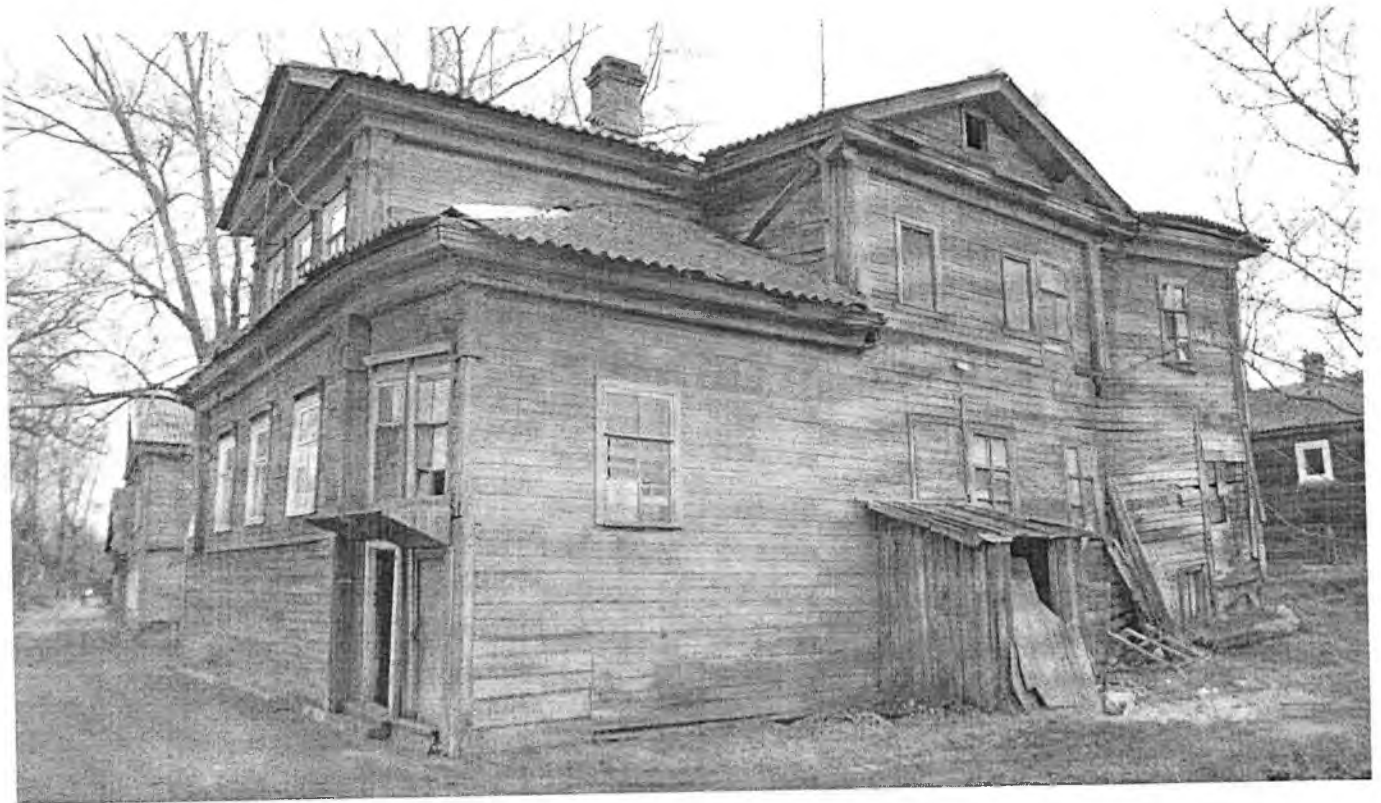
Северный фасад здания
